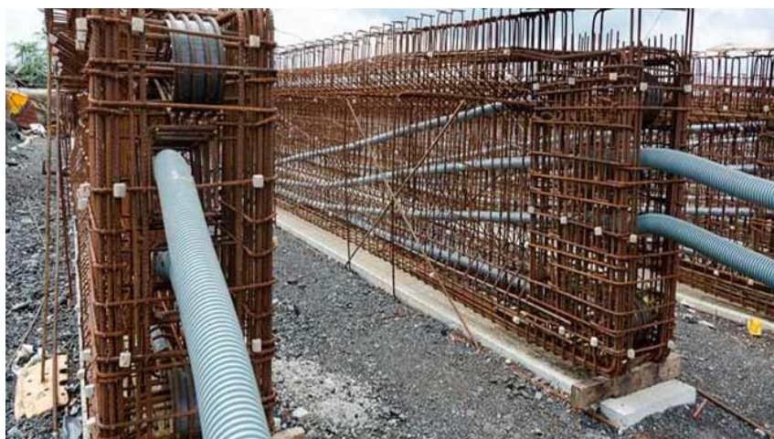
Figura 2 – Viga pré-moldada em canteiro de obra em concreto protendido pós-tracionado com aderência. Fonte: EVEHX (2019).
