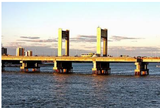
Figura 10 – Ponte de Juazeiro (Presidente Eurico Gaspar Dutra), primeira obra protendida construída com aço brasileiro. Fonte: Viver as cidades (2013).
