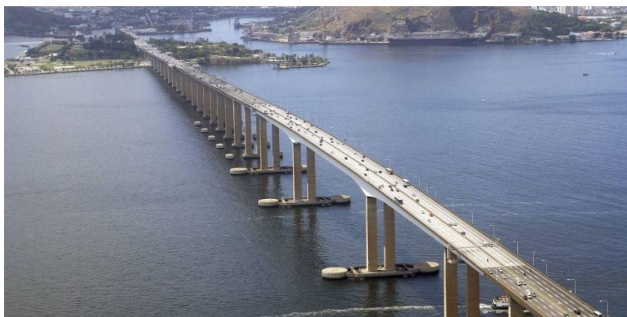
Figura 11 – Ponte Rio-Niterói, na Baía de Guanabara. Fonte: Construct App (2018).
