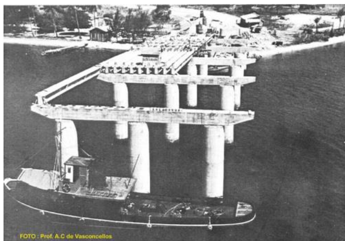
Figura 9 – Ponte do Galeão, Rio de Janeiro: primeira obra em concreto protendido no Brasil. Fonte: AWA (2019).
