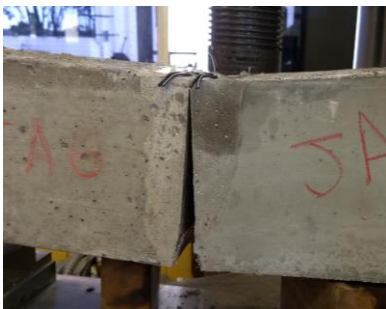
Detalhe da ruptura
