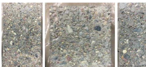
Figura 2.18 - Superfície com o agregado exposto no CAR para receber o UHPC (Fonte: SEMENDARY; SVECOVA, 2020)
