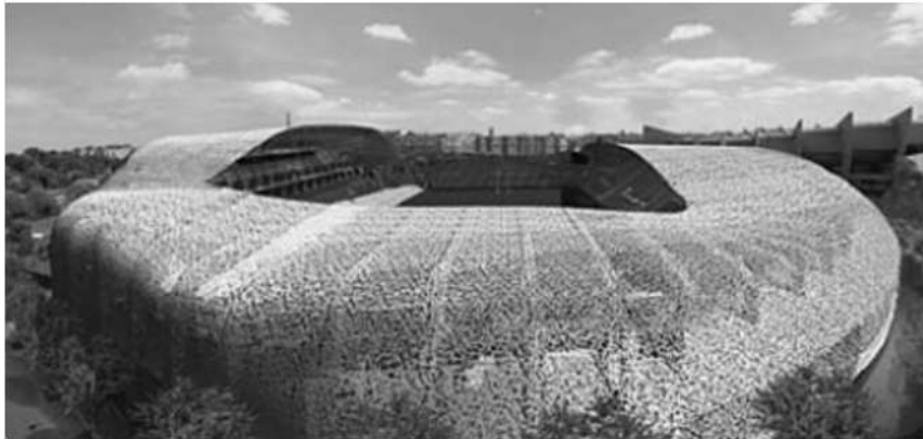
Figura 1.1: Cobertura do Jean Bouin Stadium , Paris. Fonte: Fehling et al. (2014)
