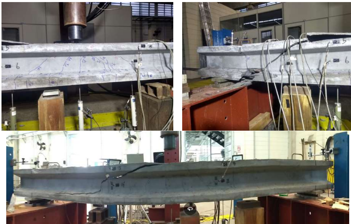
Figura 7.10: Ruptura da viga UHPC protendida (V04)
