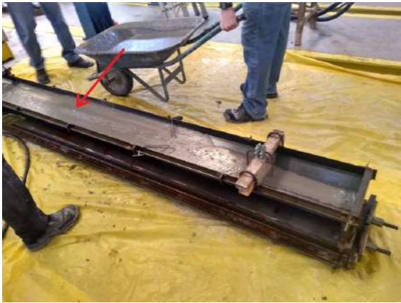
(a) Lançamento do UHPFRC na fôrma metálica auto portante
