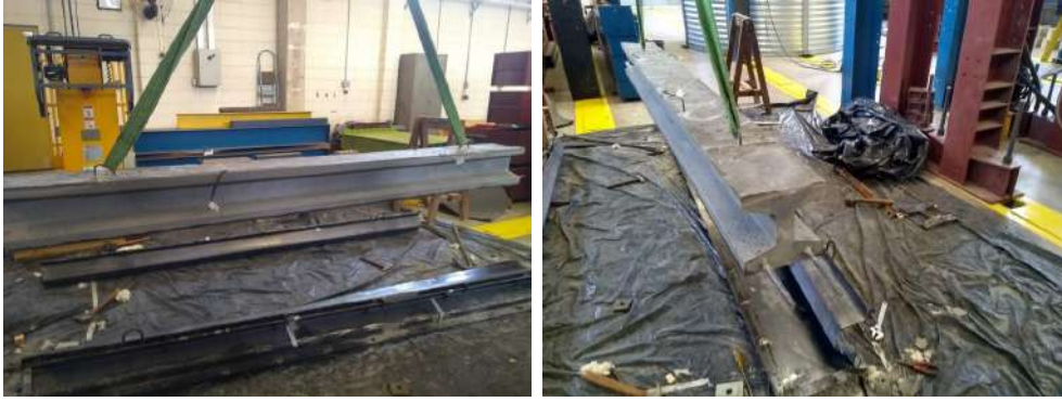
Figura 5.9: Desforma e içamento
