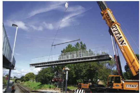
(b) Içamento de uma parte da estrutura
