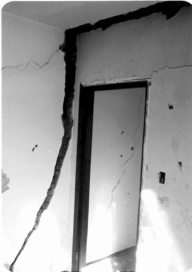
*Foto 4.4. Trincas em edificação assentada sobre área de lixo soterrado - Parque Duque de Caxias*
