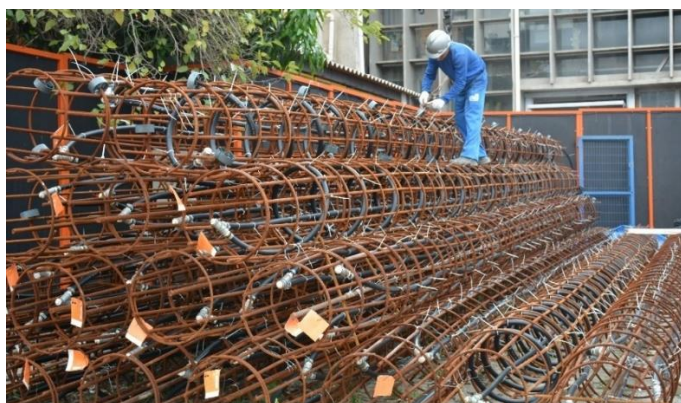
Figura 3.28: Armações com geotermia e sensores instalados antes da execução das estacas.
