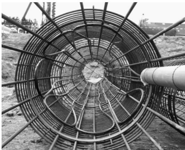
Figura 2.9: Armação de estaca com tubos instalados para sistema geotérmico de climatização.
