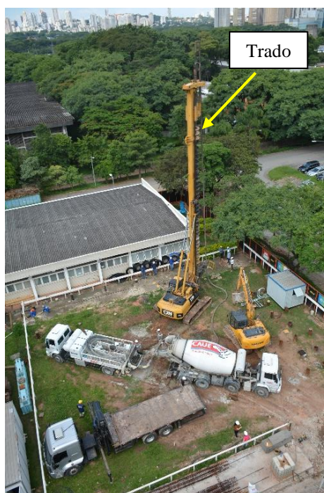
Figura 3.13: Equipamento de estaca hélice contínua no canteiro do CICS.
