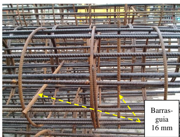
Figura 3.24: Barra para guiar os sensores (a) barra central e (b) barras guia.
