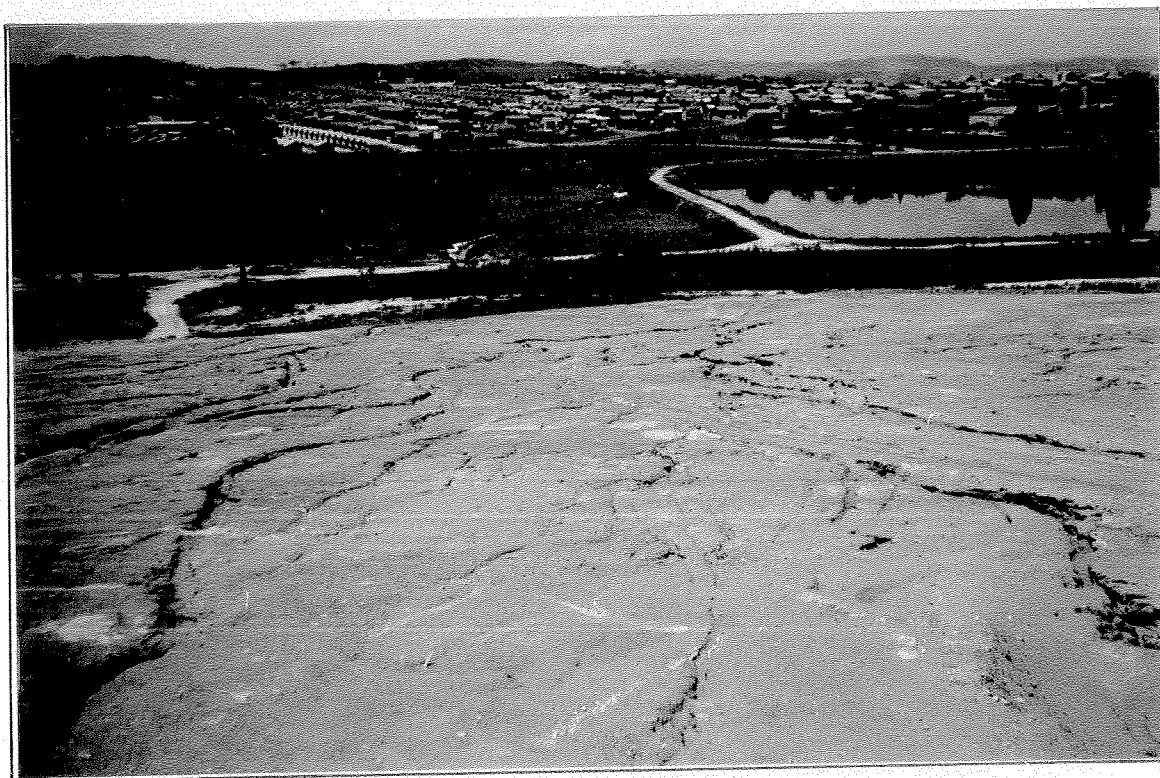
Fotografia nº 2 - Instalação de processo erosivo na unidade REGq, em local de implantação de conjunto habitacional, à NW de Itapira ( Pto. 106, Anexo 1)
