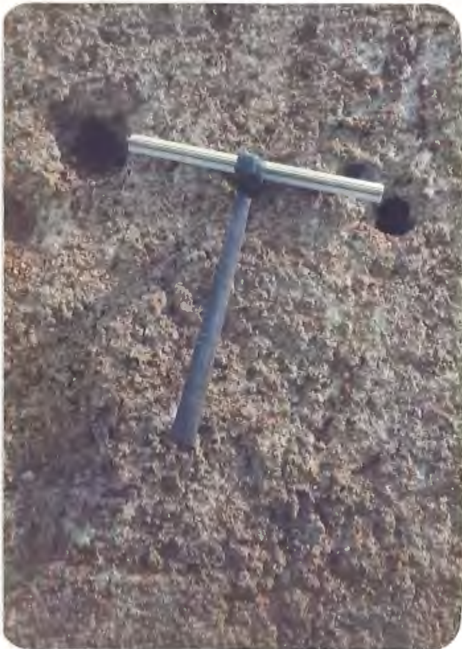
Foto 01 - Canalículos do Grupo I - Formados por lixiviação e erosão em encostas e barrancos.
