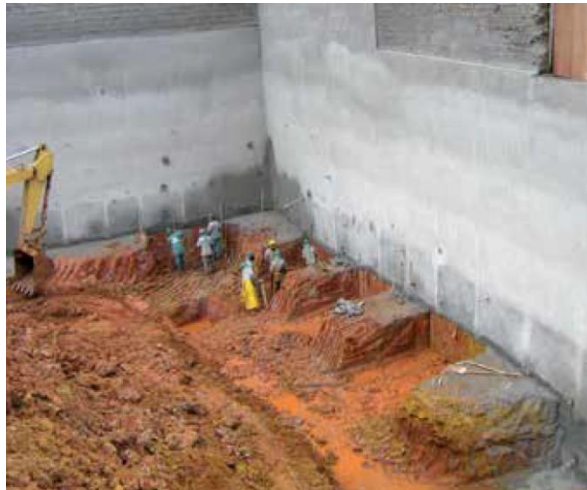
Figura 14 - Escavação do solo entre bermas (Pitta, Souza e Zirlis, 2013)
