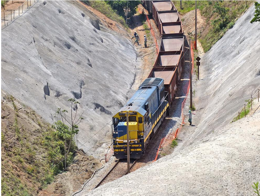
Figura 2 - Reforço de taludes naturais com solo grampeado (Solotrat, 2020)
