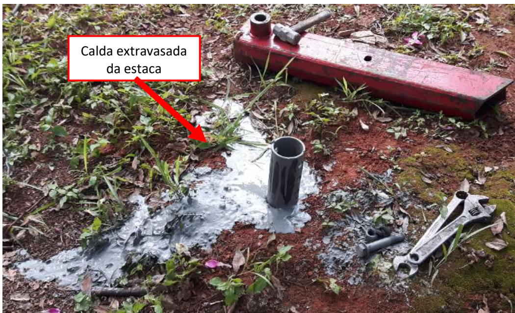
Figura 5.19: Aspecto da estaca INJ-2H-101-EXUM ao final da injeção. Detalhe da calda extravasada na superfície, percolada pela interface estaca-solo.
