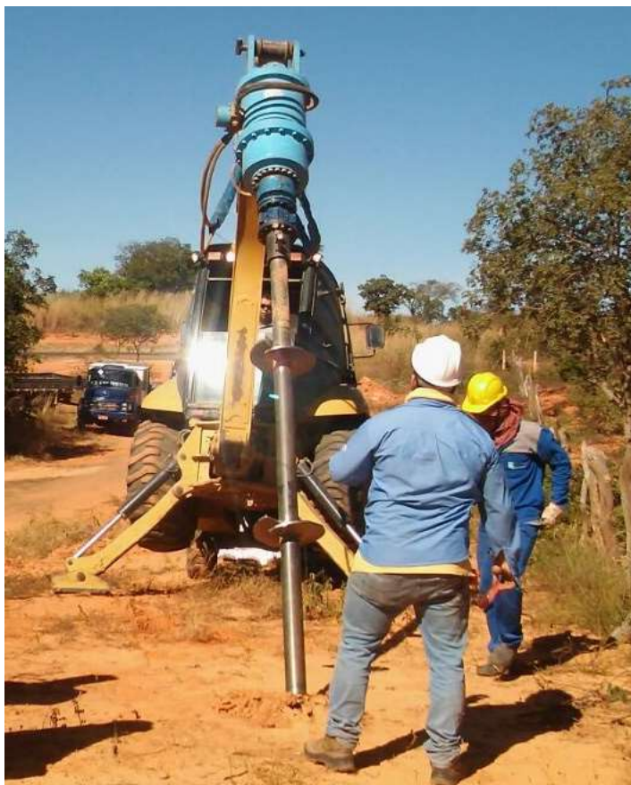
Figura 3.7: Equipamento de instalação de estacas helicoidais.
