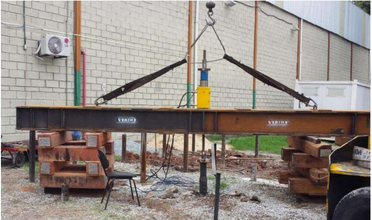
Figura 4.12: Sistema de reação utilizado nas provas de carga à tração em estacas verticais.
