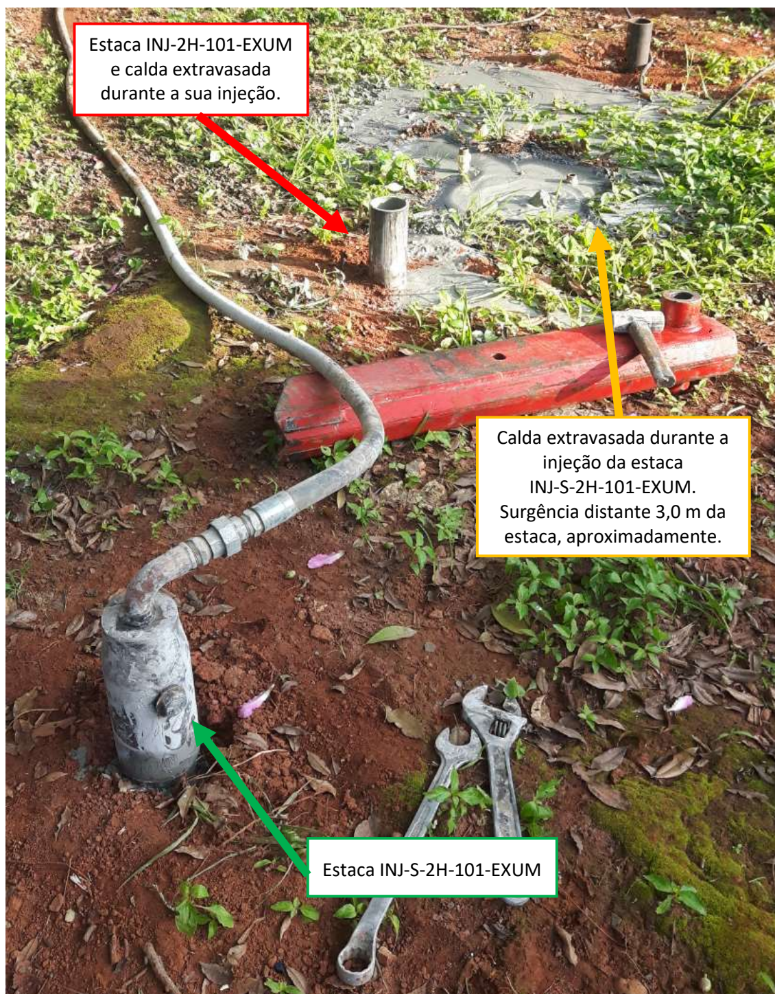
Figura 5.20: Aspecto da estaca INJ-S-2H-101-EXUM ao final da injeção. Detalhe para ocorrência do extravasamento afastado da estaca.
