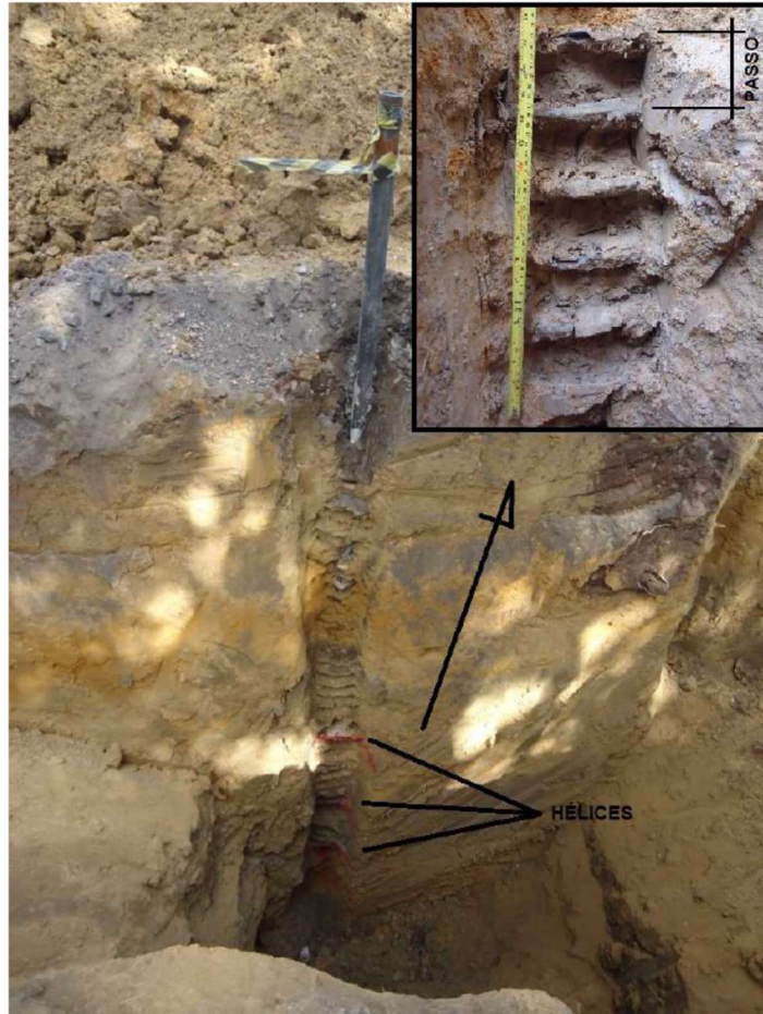
Figura 3.21: Detalhe das placas de calda endurecida (SANCHEZ, 2014).
