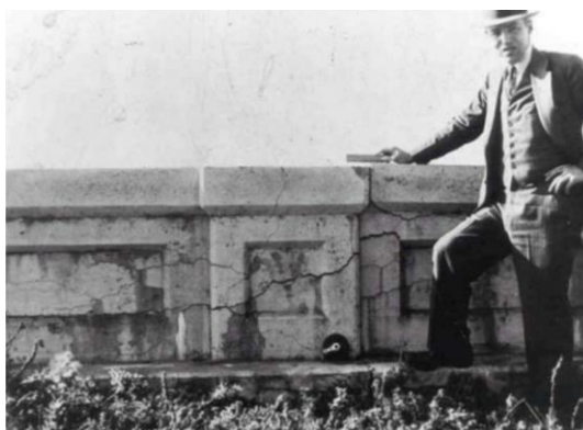
Figura 3.1 - Thomas Stanton em um guarda-corpo de ponte com fissuras devido à RAA
