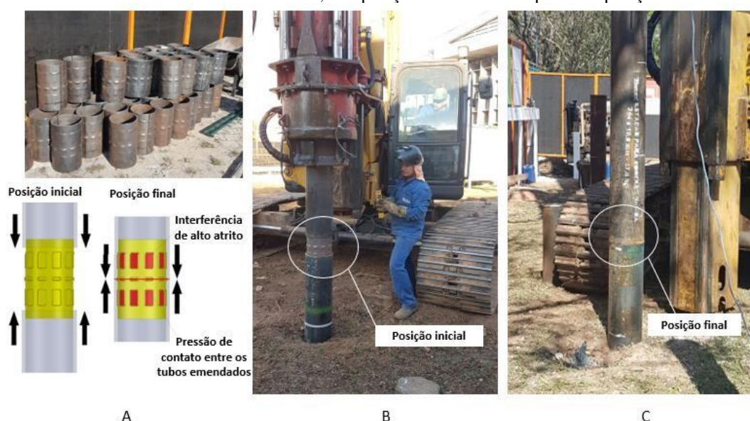
Figura 3. 23- Luva de conexão rápida para emenda das estacas tubulares (A- Imagem das Luvas e apresentação do mecanismo de funcionamento, B – posição inicial em campo e C – posição final em campo)
