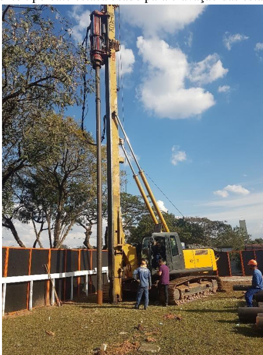
Figura 3. 21- Equipamento tipo bate estaca usado para cravação das estacas metálicas do CICS
