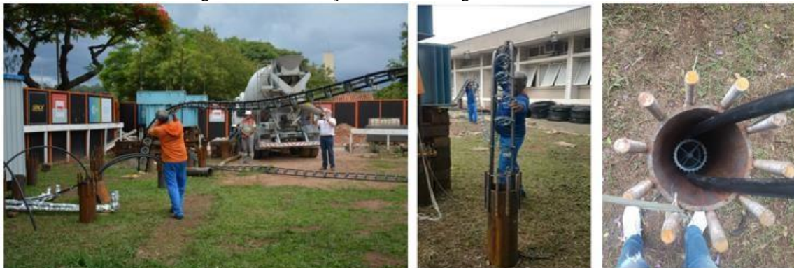
Figura 3. 31-Instalação dos tubos de geotermia nas estacas metálicas
