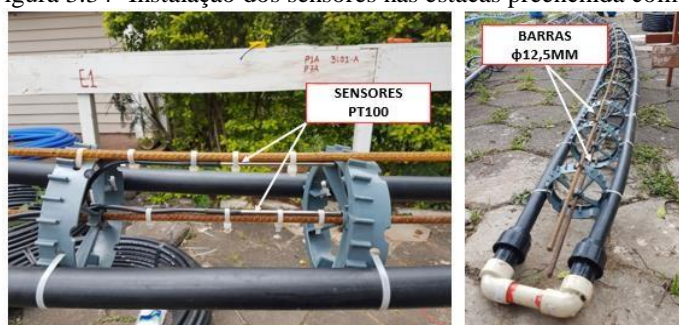
Figura 3.34- Instalação dos sensores nas estacas preenchida com água
