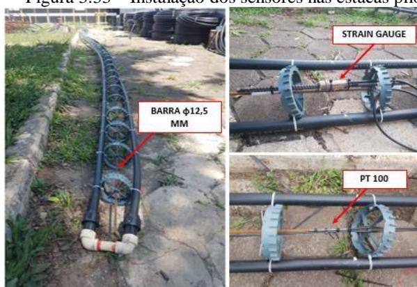
Figura 3.33 – Instalação dos sensores nas estacas piloto do CICS
