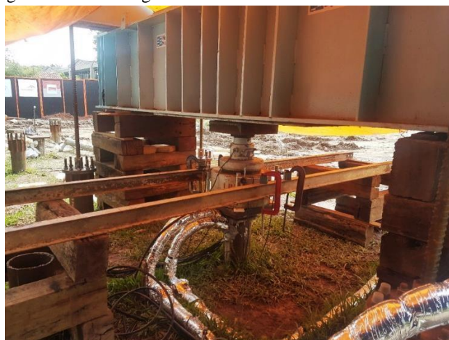
Figura 3. 43- Montagem do ensaio termomecânico na estaca T6
