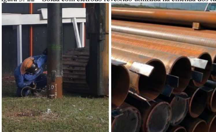
Figura 3. 22 – Solda com eletrodo revestido utilizada na emenda dos tubos metálicos
