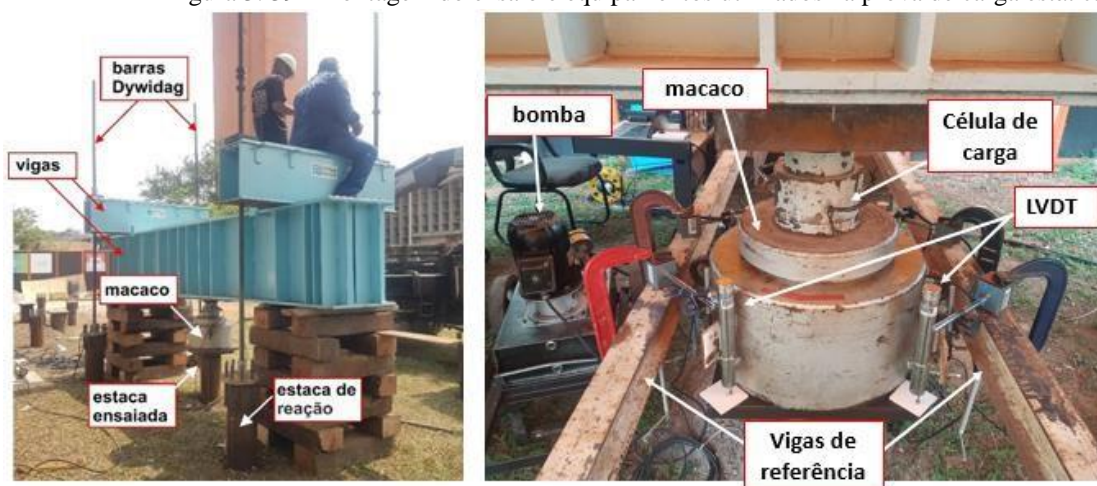
Figura 3. 39– Montagem do ensaio e equipamentos utilizados na prova de carga estática
