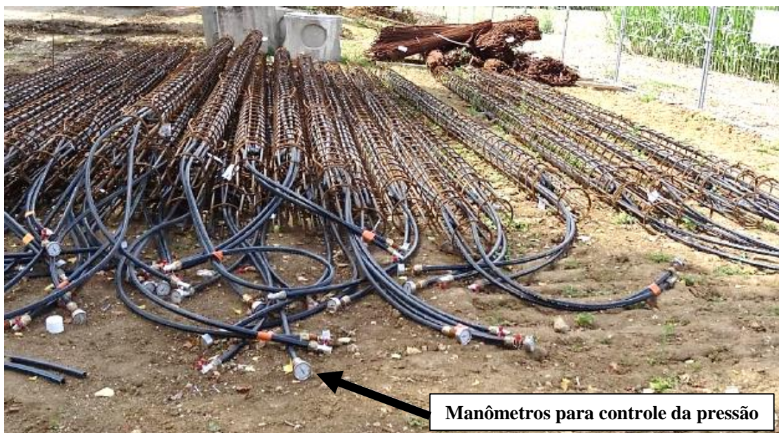
Figura 2.19: Uso de manômetros nos tubos trocadores de calor para aferição e garantia da pressão nos tubos durante a execução e processo de cura de estacas trocadoras de calor.
