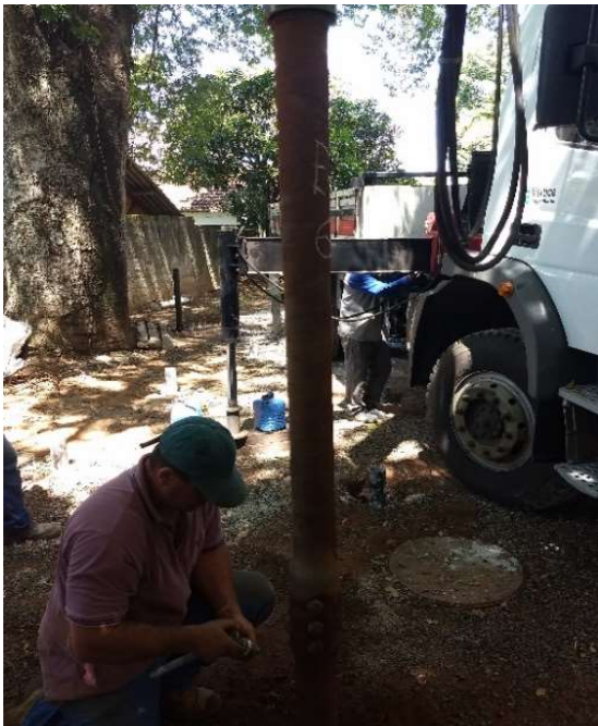
Figura 16 –Exumação das estacas
