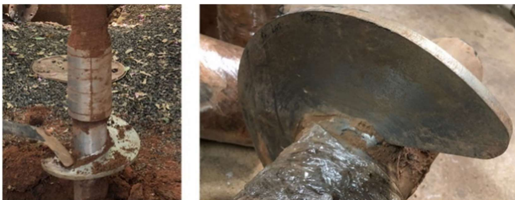
Figura 59 – Região da ponta de estaca exumada durante e após a extração do terreno
