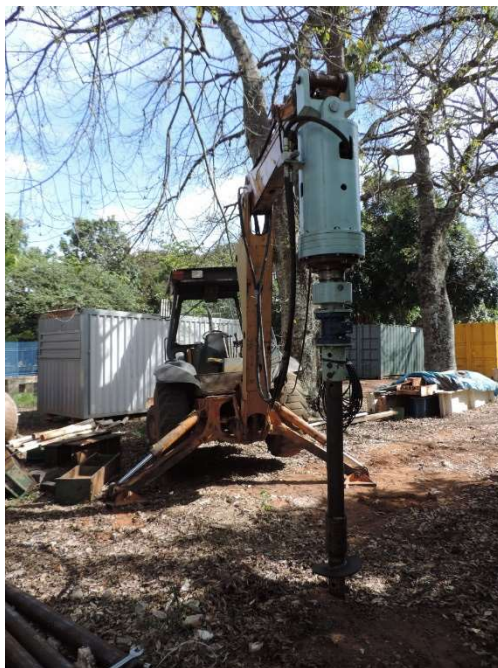
Figura 2 – Retroescavadeira com rotor, instalando a haste guia.
