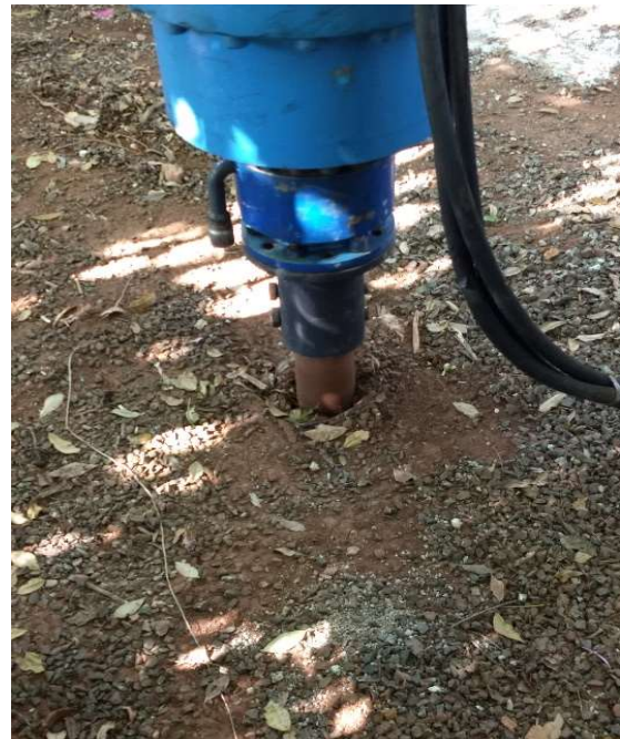
Figura 17 – Munck exumando as estacas
