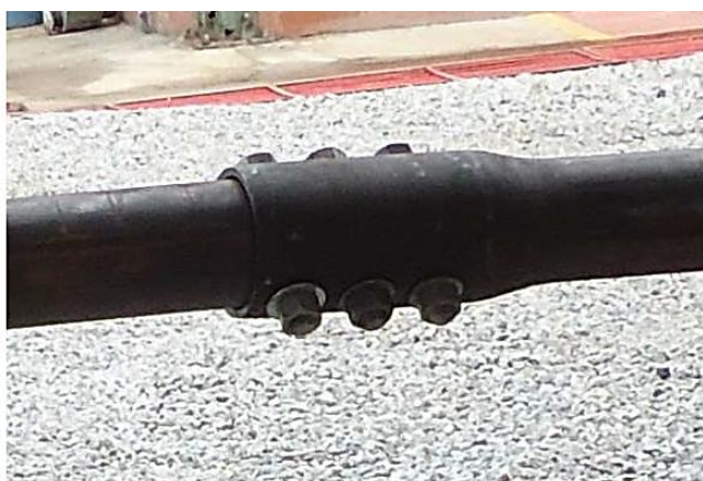
Figura 4: Detalhe de emenda para extensões
