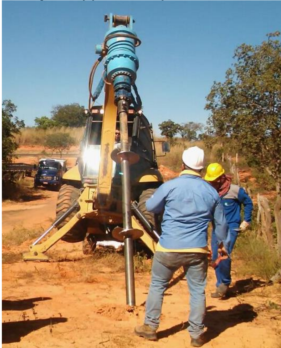
Figura 3.6: Equipamento de instalação de estacas helicoidais
