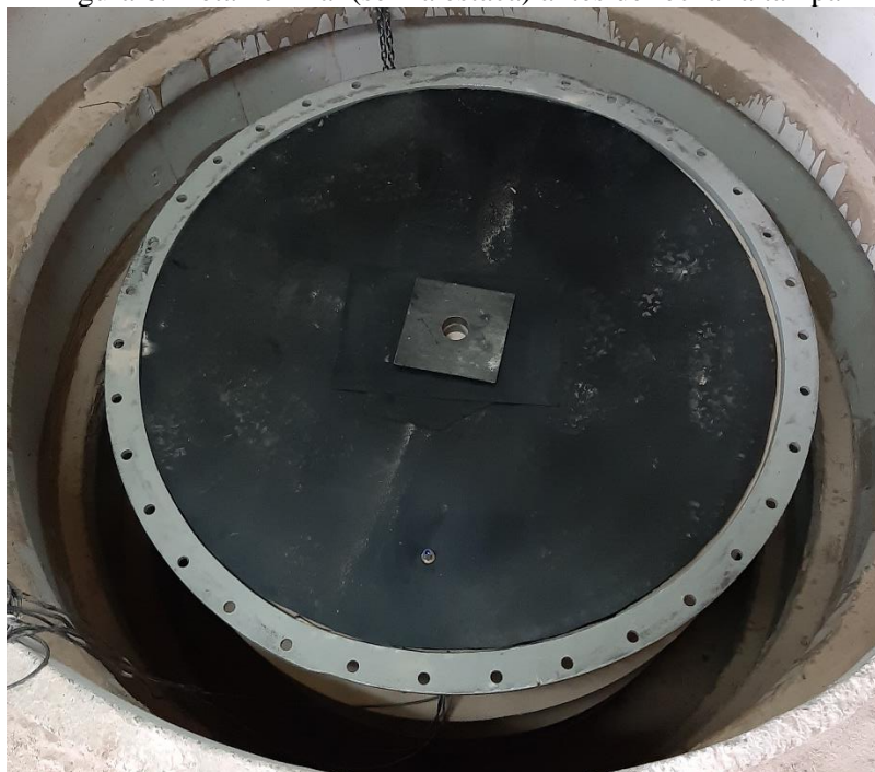
Figura 6: Detalhe final (sem a estaca) antes de fechar a tampa
