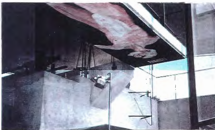
Foto 31. Vistas da sacristia, da laje do coro da Capela.
