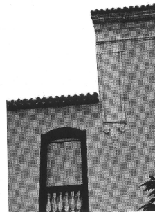
21. Detalhe na fachada lateral da Igreja Nossa Senhora da Boa Morte. (Foto de Deusa Maria Rodrigues Boaventura)
