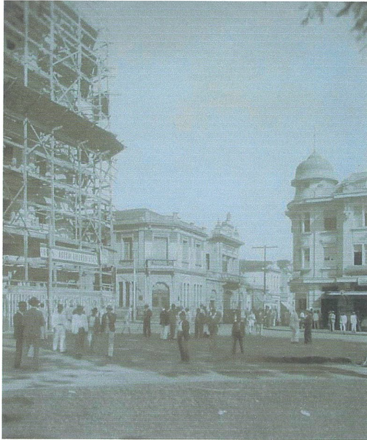
Figura 2.23 - Construção do Edifício Diederichsen - dec. 1930
