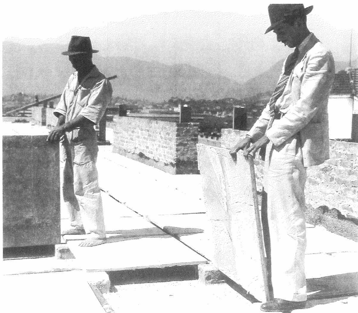
Casa São Luiz para a Velhice, 1937. Laje do Pavilhão Lebrão em construção. À direita Paulo de Camargo e Almeida.
