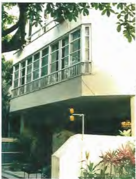
Detalhe da varanda em balanço.
