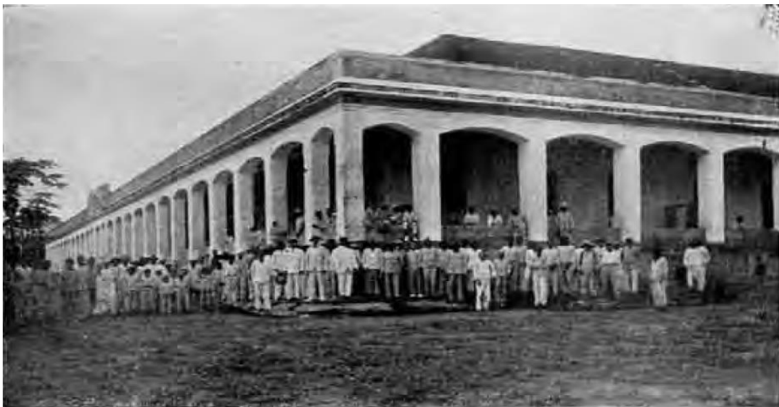
Figura 3: Frente do edifício principal da Leprosaria de Paricatuba
