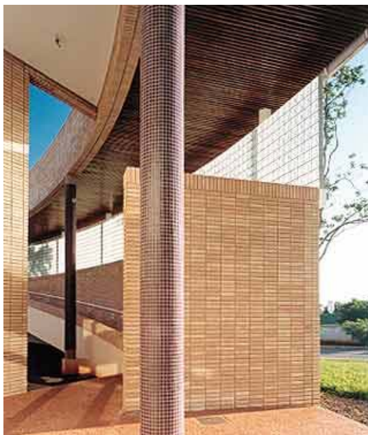
Figura 107. Foto da obra. Fonte: Arcoweb.
