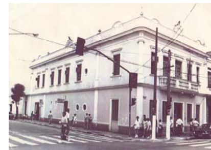
Figura 88: Biblioteca Pública Cassiano Ricardo, São José dos Campos. Guilherme Motta e Antonio Luiz Dias de Andrade, 1995-1996. Aspecto do edifício antes da intervenção
