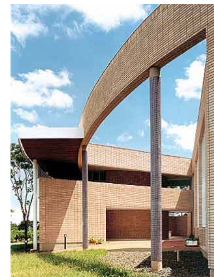
Figura 110. Foto da obra. Fonte: Arcoweb.
