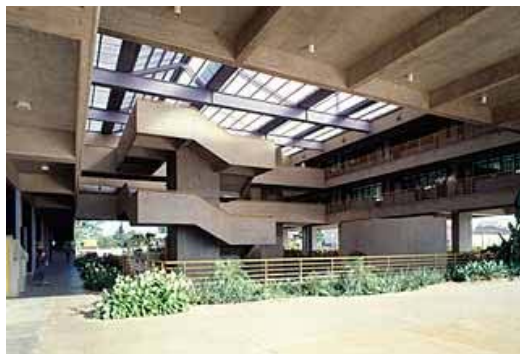
Figura 102: Paço Municipal de Suzano, São Paulo. Fonte: Arcoweb.
