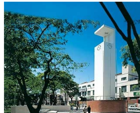
Figura 50. Terminal de Ônibus Urbanos na Lapa, São Paulo. Luciano Margotto, Marcelo Ursini e Sérgio Salles, 2002. Foto de torre da caixa-d’água com relógios marcando o acesso principal à praça. Fonte: www.arcoweb.com.br
