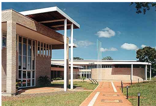
Figura 109. Foto da obra. Fonte: Arcoweb.
