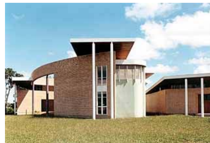
Figura 108. Foto da obra. Fonte: Arcoweb.
