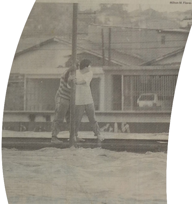
Antos (à esq.) e Nelson Nakada sobem em proteção da av. Aricanduva, após a chuva de terça-feira, que causou 113 km de engarrafamentos em SP sem energia; obras em diversos pontos pioraram ainda mais o trânsito
