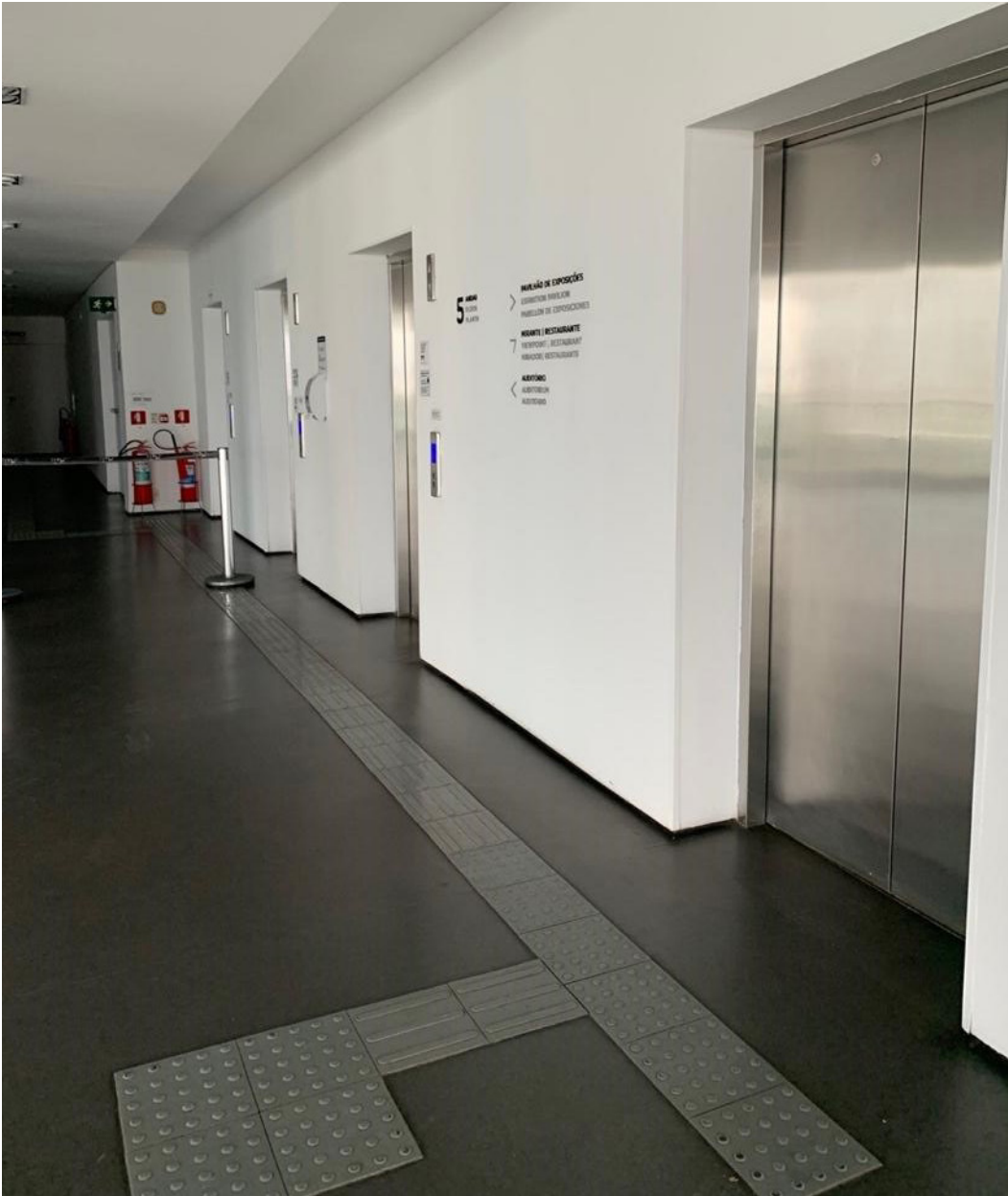
Imagem 116: Sinalização podotátil nos elevadores do observatório
