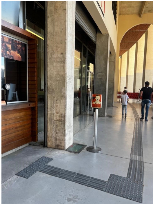
Imagem 48: Sinalização podotátil a partir da bilheteria do Museu do Futebol Fonte: Acervo pessoal da autora (2023)
