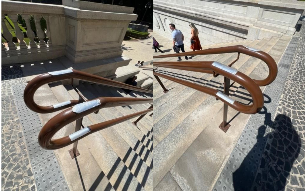
Imagem 23: Sinalização podotátil de alerta nas escadas
