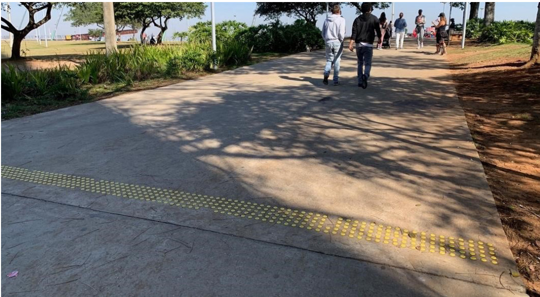
Imagem 204: Piso podotátil na Usina do Gasômetro
