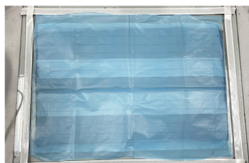
Etapa 4 - Aplicação do tecido desmoldante filme perfurado
