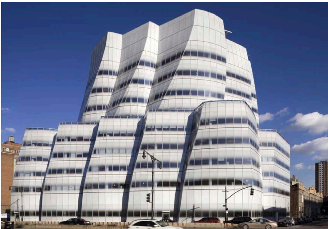
Figura 112 – Sede do IAC, em Nova Iorque, cuja fachada foi executada com placas de vidro curvado
