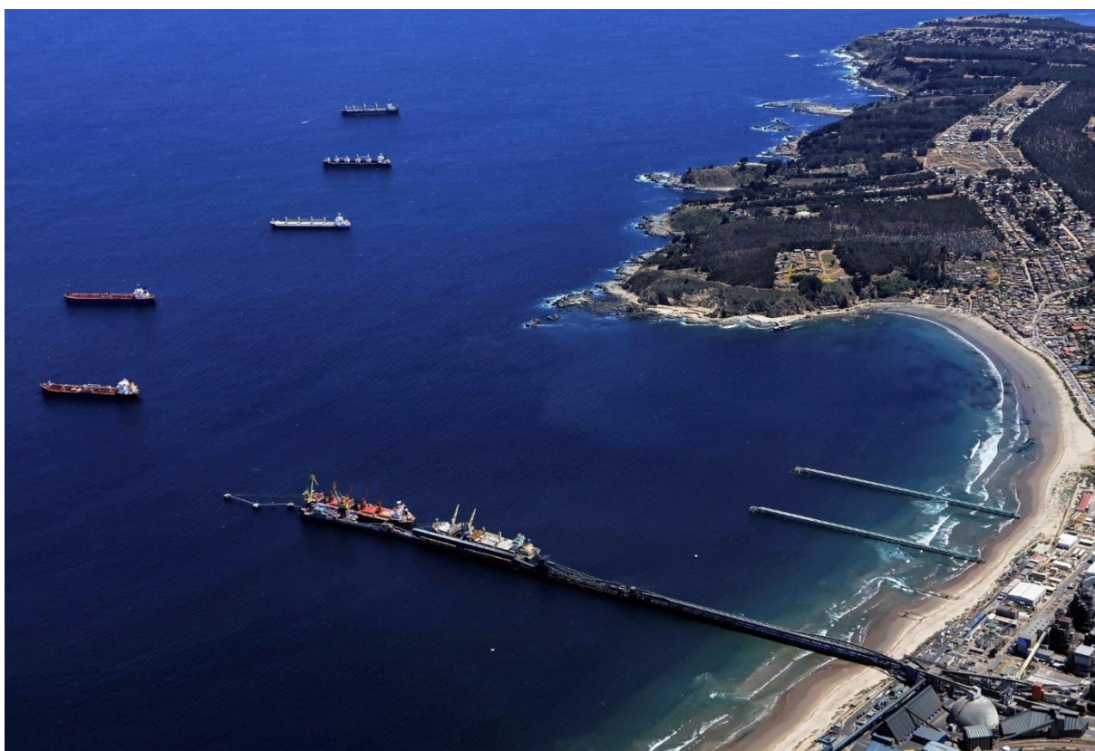
Figura 3.23 – Porto Quintero-Ventanas, Região de Valparaíso
