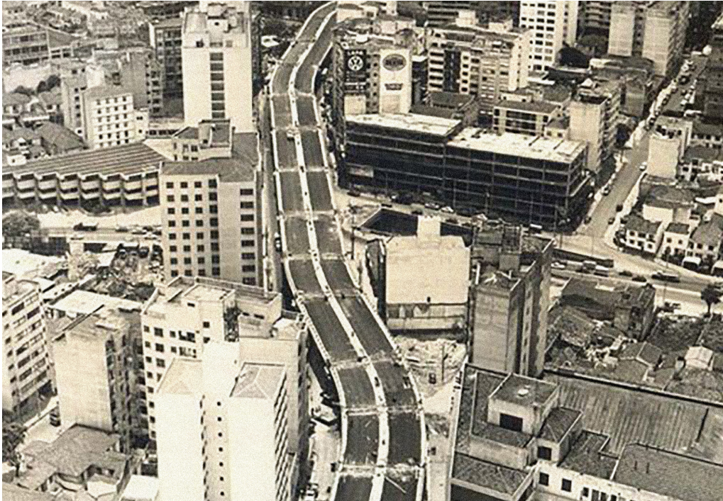
Figura 7. Obras do elevador Presidente Arthur da Costa e Silva, 1970.
