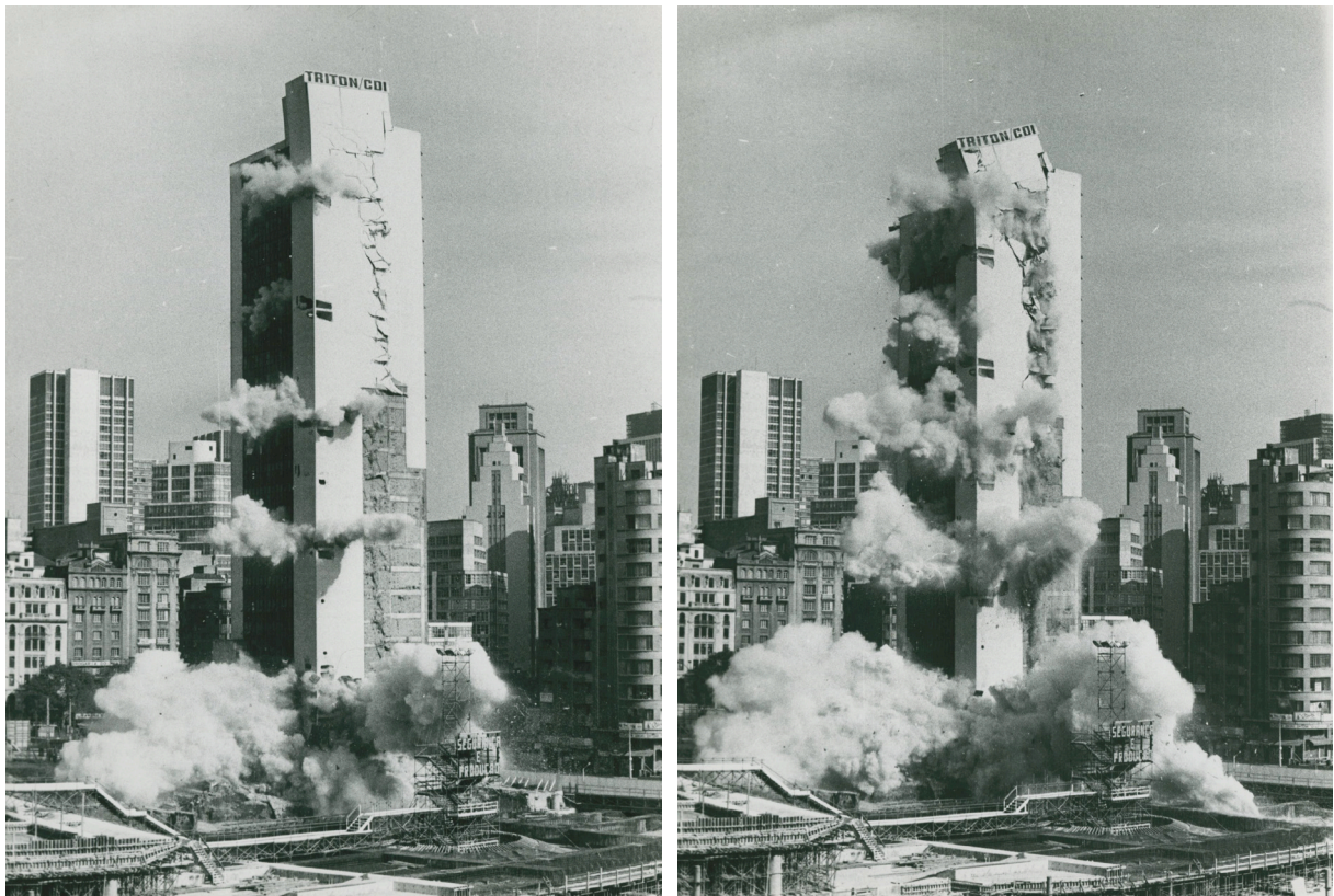
Figuras 5 e 6 - fotos do edifício Mendes Caldeira sendo demolido (1975).
