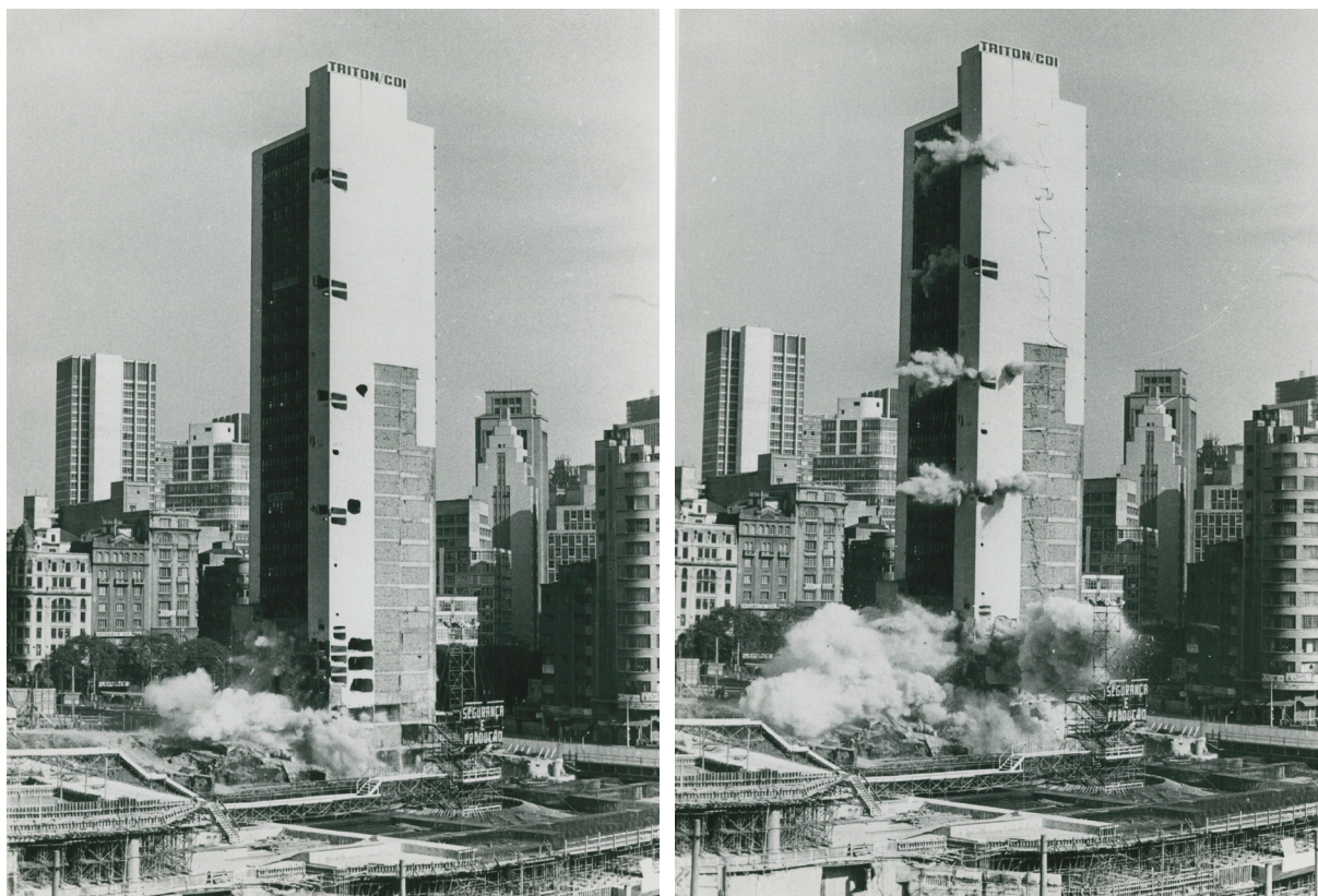
Figuras 3 e 4 - fotos do edifício Mendes Caldeira sendo demolido (1975).
