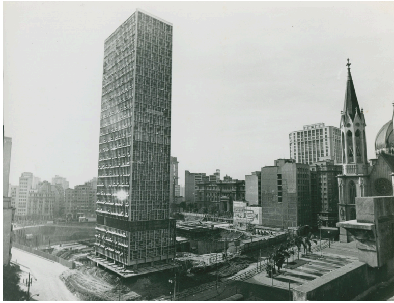
Figuras 7 a 9 - fotos do edifício Mendes Caldeira sendo demolido, com vista da Praça da Sé (1975).
