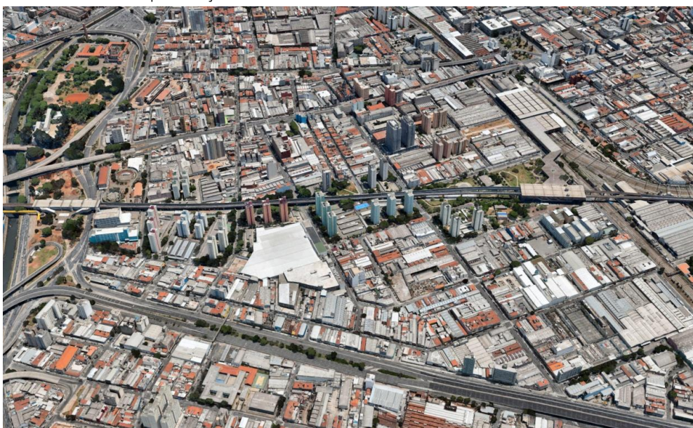
FIGURA 2.6 | SITUAÇÃO URBANA ATUAL DA ÁREA DO PROJETO BRÁS BRESSER
