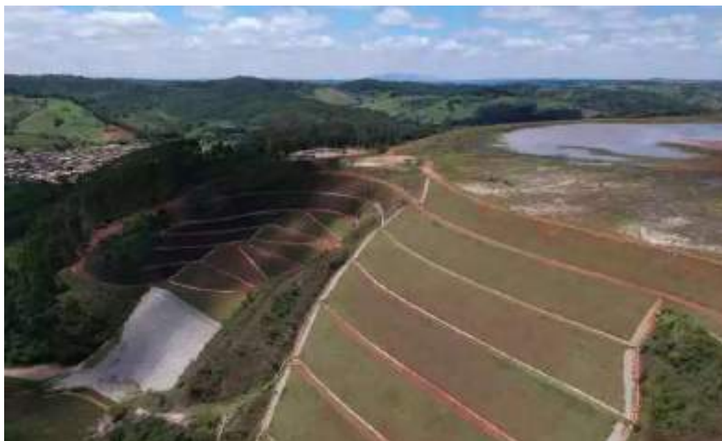
Fig. 122- Barragem de Rejeitos da Casa de Pedras – Congonhas. Fonte: Estado de Minas. foto: Mateus Parreiras/EM/D.A. Press)Disponível em: https://www.em.com.br/app/noticia/gerais/2019/11/26/interna_gerais,1103878/moradores-relatam-desespero-com-tremor-e-barragem-em-congonhas-veja-v.shtml
