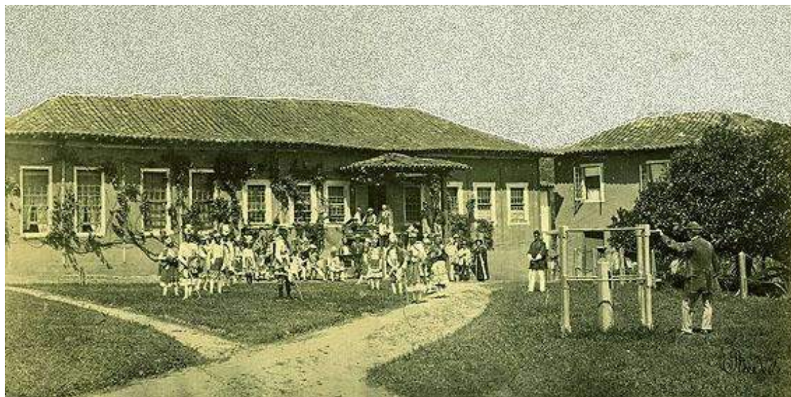
Fig. 50 – Preparativos da visita de Dom Pedro II à Casa Grande, sede da Mina de Morro Velho.
