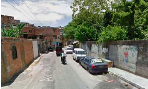
Figura 61: Muro que divide a Nova República do Parque da Cidade
