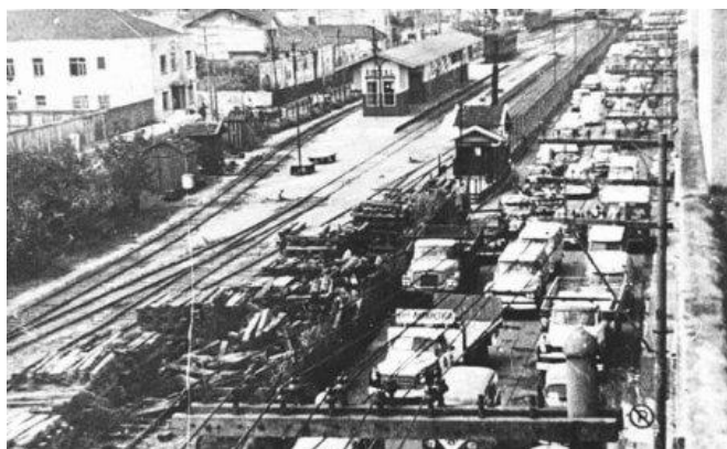
3 – Estação Areal (desconhecido, anos 1960 apud Giesbrecht).
