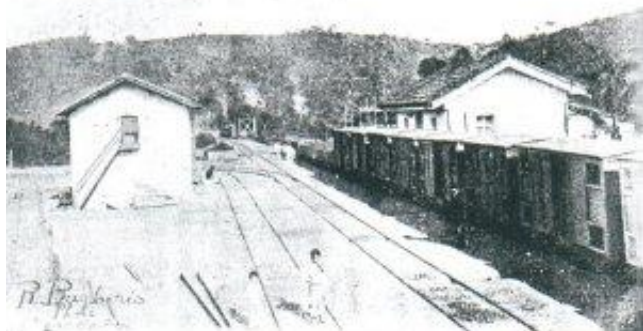
1 – Antiga estação São João, final do século XIX (“90 anos da EFS” apud Giesbrecht, s/d).
