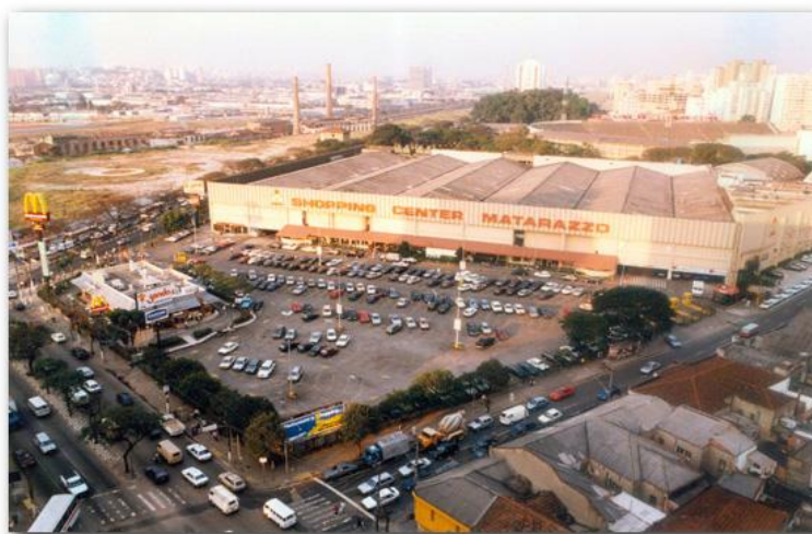
Figura 37 - Shopping Matarazzo: empreendimento associado Shopping-Estação (OESP, 1989)
