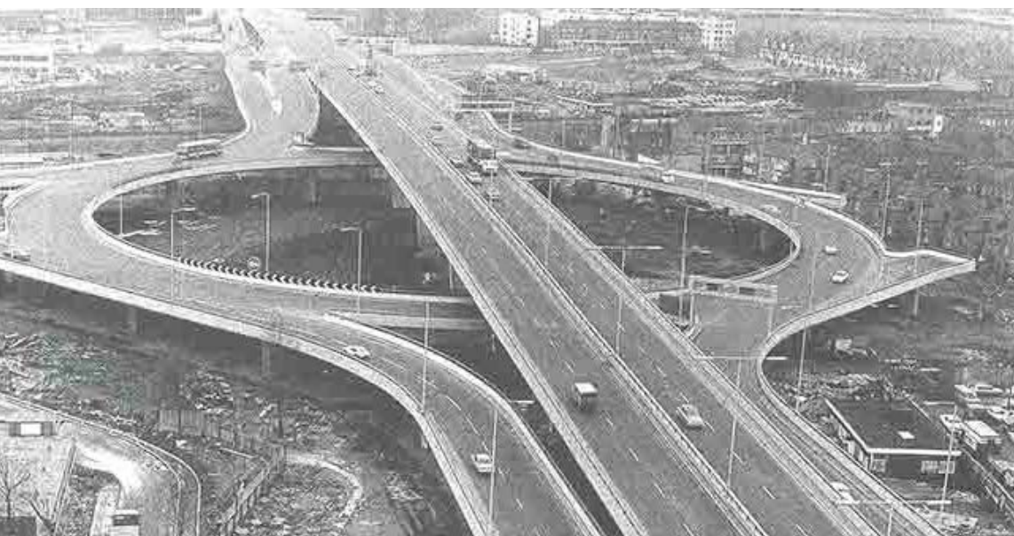
Figura 3. O Westway Flyover após a finalização das obras, anos 1970 (fonte: International Times ) 4
