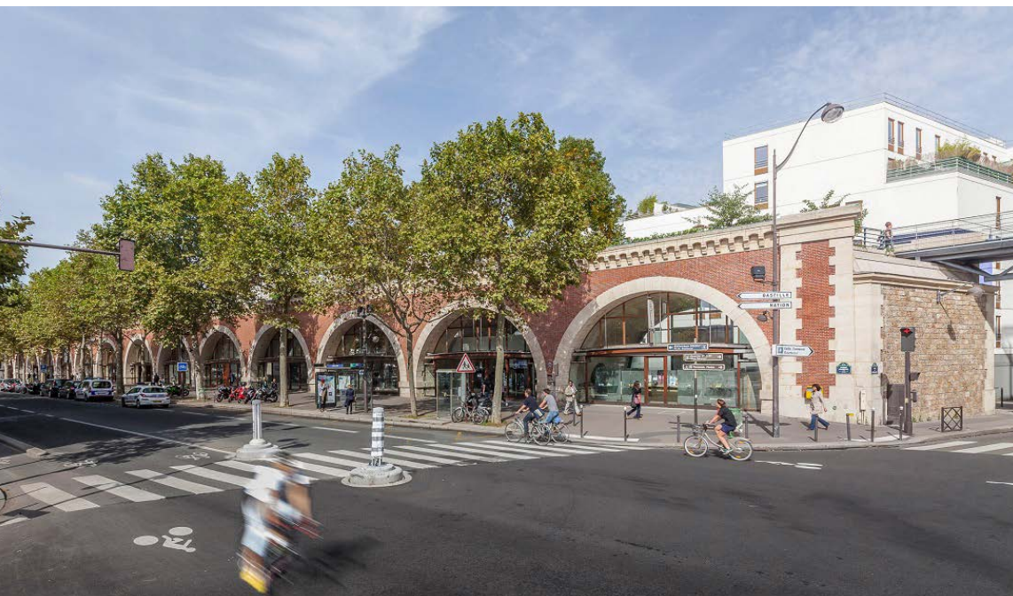
Figura 1. Vista da rua do Viaduc des Arts. (fonte: Semaest) 2
