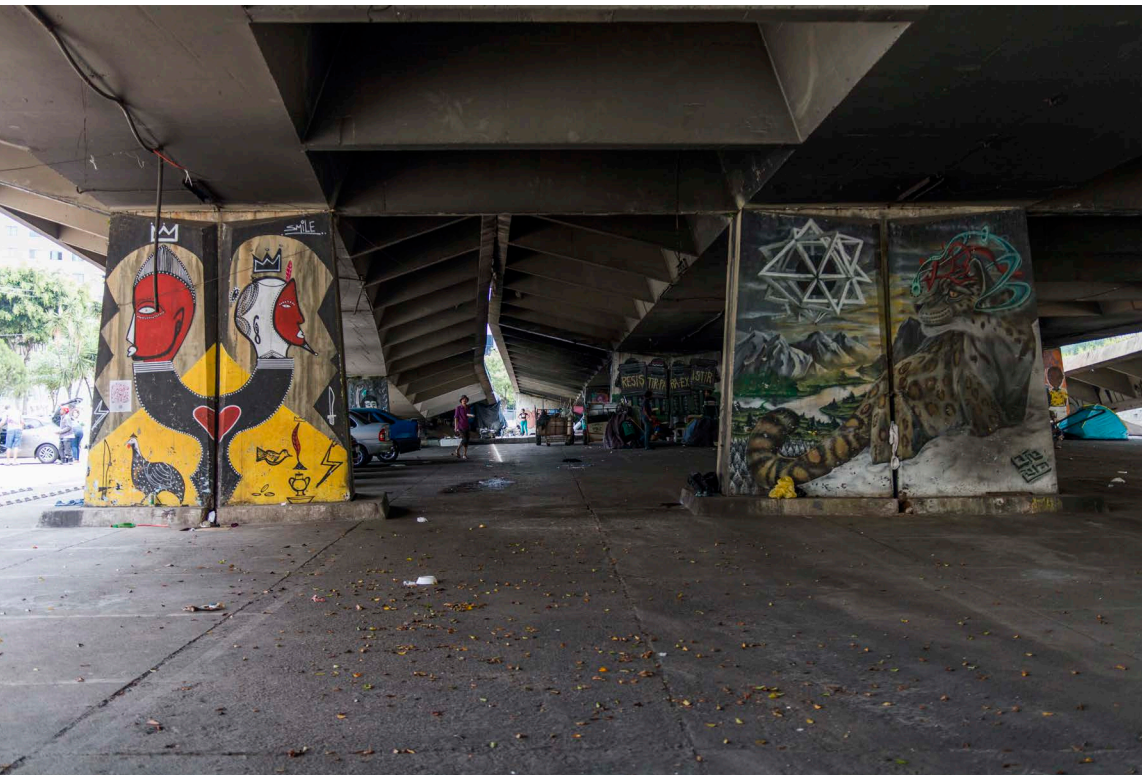
Figura 24. Baixios do viaduto no trecho próximo à rua Major Diogo, com moradias de pessoas em situação de rua (acervo pessoal; fonte: João Cassaro Jr., 2022)
