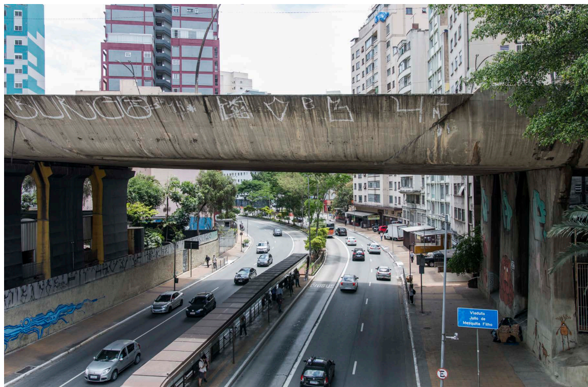
Figura 18. Viaduto no trecho sobre a avenida Nove de Julho. À esquerda, o Complexo #9 (acervo pessoal; fonte: João Cassaro Jr., 2022)
