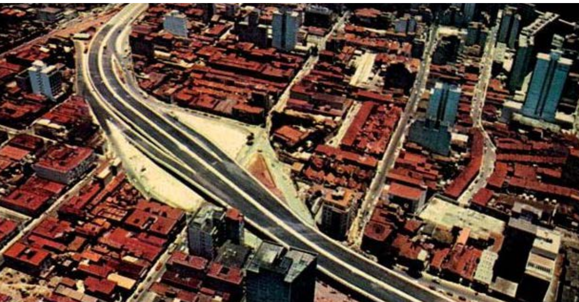
Figura 11. Imagem aérea do viaduto Júlio de Mesquita Filho após a conclusão das obras (fonte: São Paulo Antiga) 21
