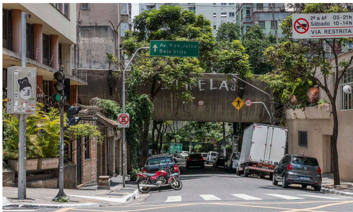
Figura 12. O viaduto Júlio de Mesquita Filho visto da rua Avanhandava (acervo pessoal; fonte: João Cassaro Jr., 2022)
