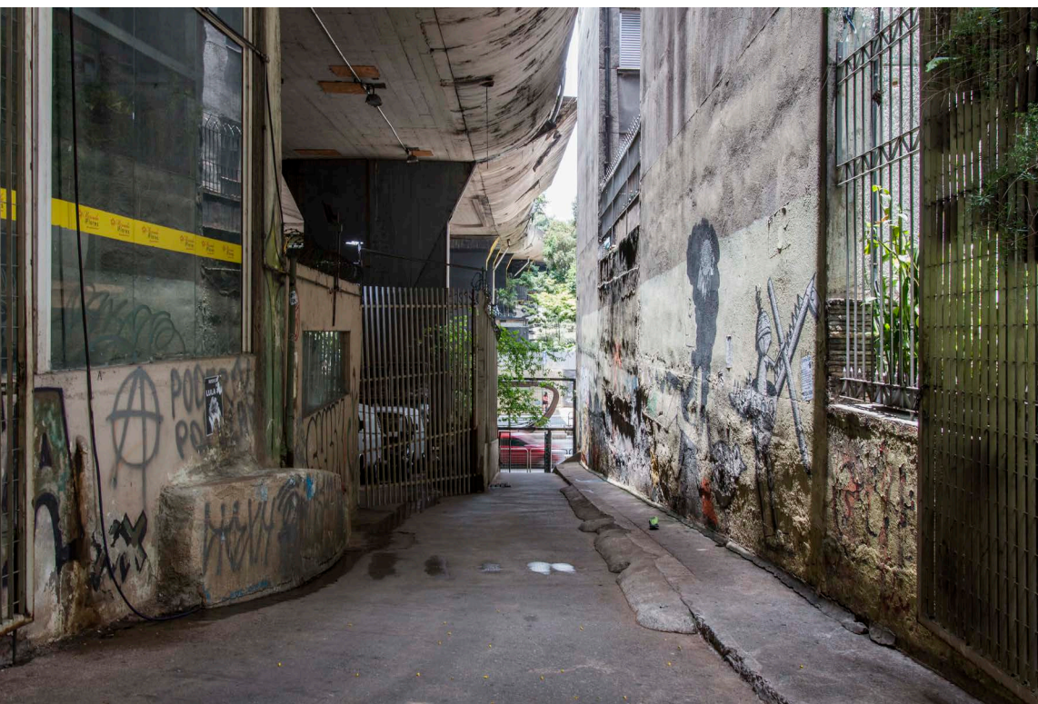
Figuras 15. Escadas laterais de acesso à avenida Nove de Julho e à parte superior do viaduto (acervo pessoal; fonte: João Cassaro Jr., 2022)
