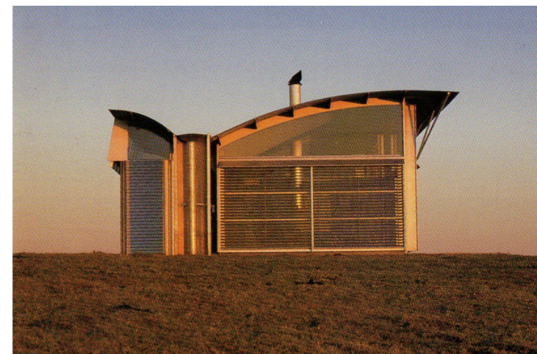
> 15 Residência Magney Bingi Point | 1982–1984
