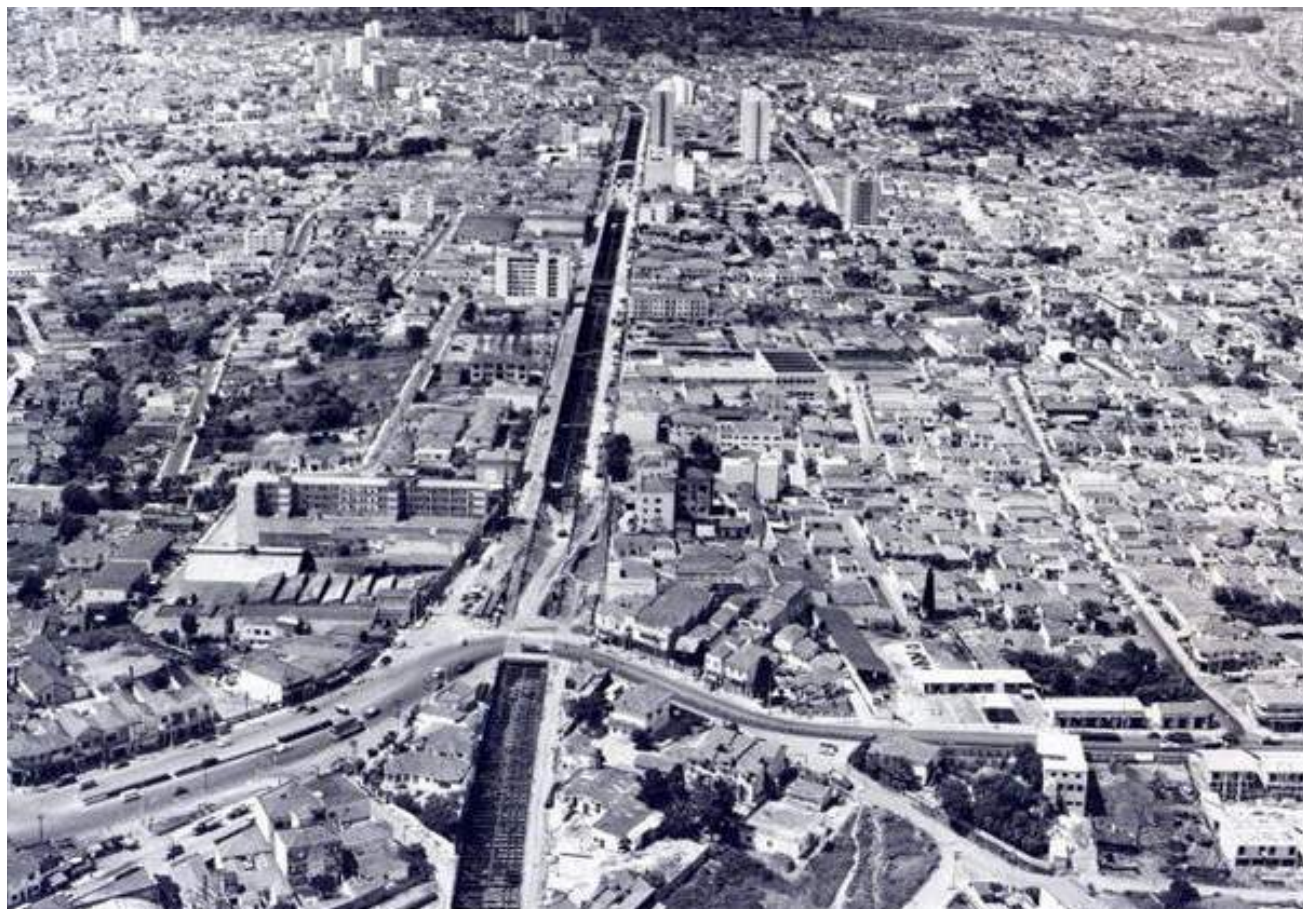
IMAGEM 168 Avenida Jabaquara com a vala aberta pela construção em cut-and-cover da Linha 1–Azul do Metrô.
