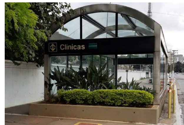
IMAGEM 261 Estação Clínicas. Abrigo original provisório de acesso.
