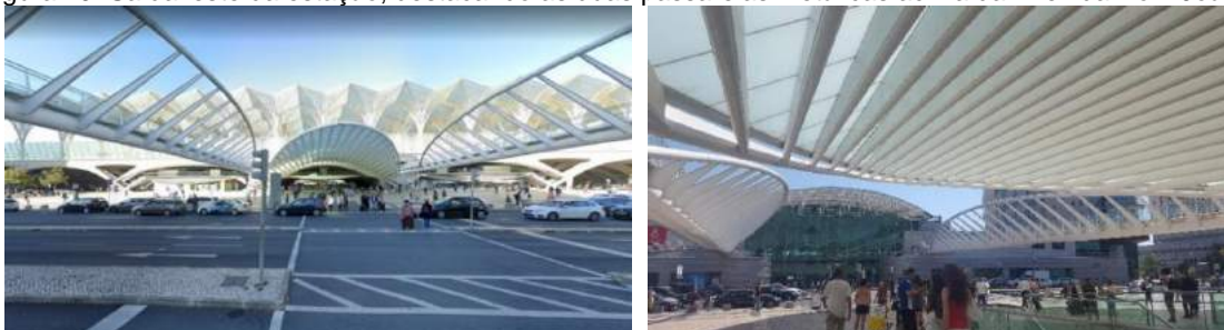
Figura 79: Saída leste da estação, destacando as duas passarelas metálicas acima da Avenida Dom João II
