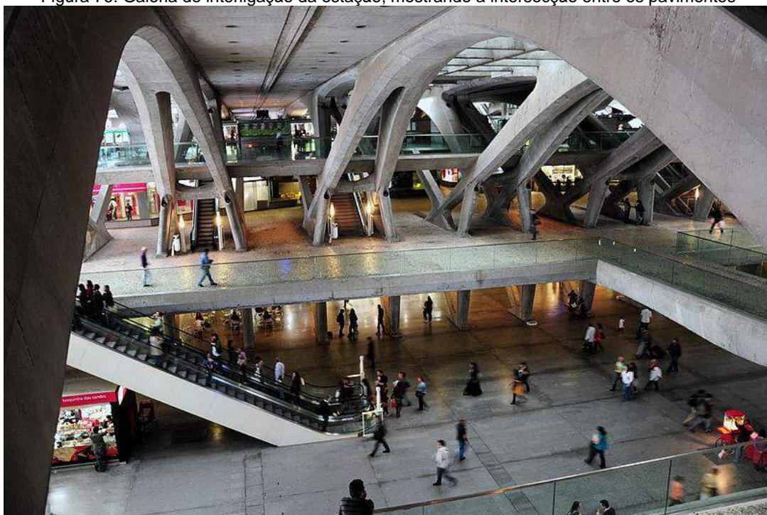
Figura 76: Galeria de interligação da estação, mostrando a intersecção entre os pavimentos
