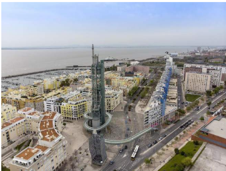
Figura 42 - Porta do Mar, vista aérea
