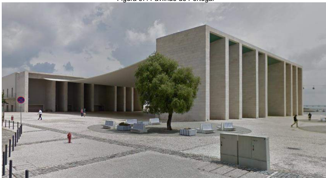
Figura 67: Pavilhão de Portugal
