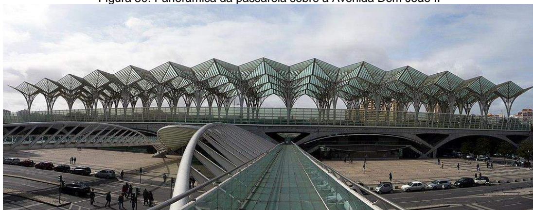
Figura 80: Panorâmica da passarela sobre a Avenida Dom João II
