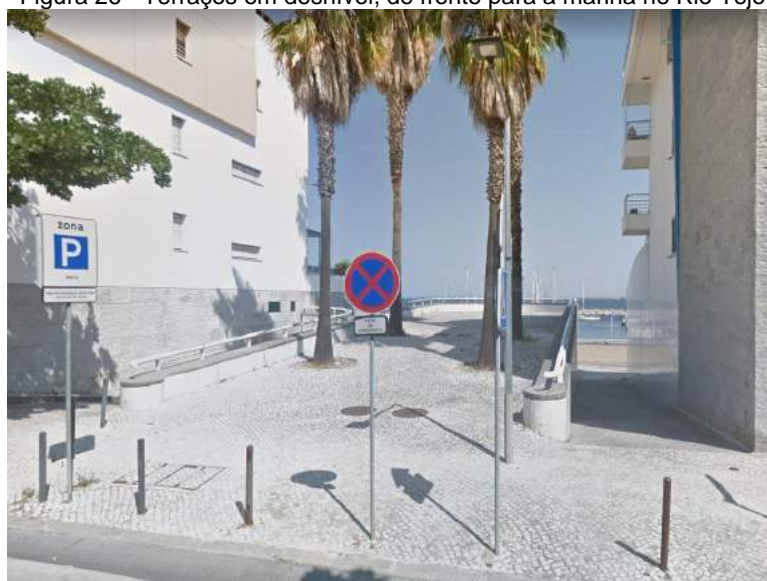
Figura 26 - Terraços em desnível, de frente para a marina no Rio Tejo
