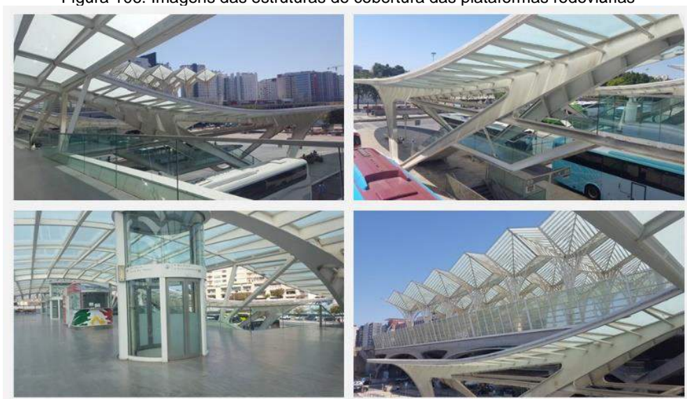
Figura 106: Imagens das estruturas de cobertura das plataformas rodoviárias
