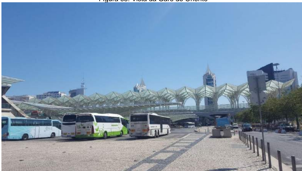
Figura 65: Vista da Gare do Oriente
