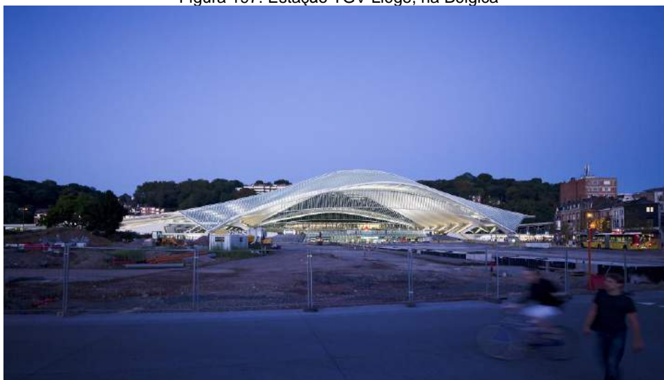
Figura 197: Estação TGV Liège, na Bélgica
