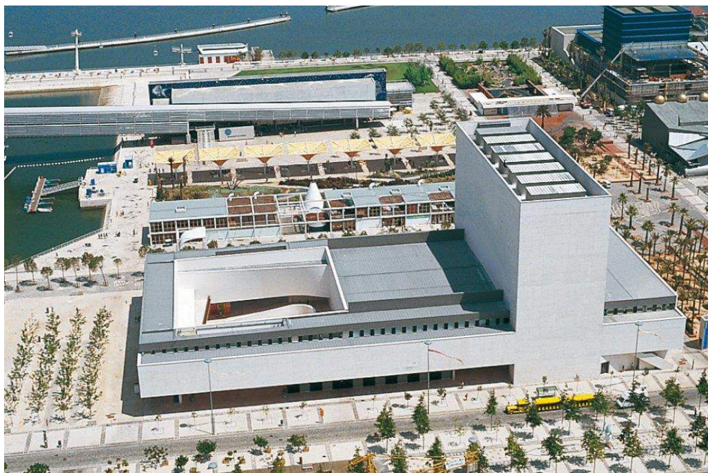
Figura 51: Vista aérea do Pavilhão do Conhecimento dos Mares
