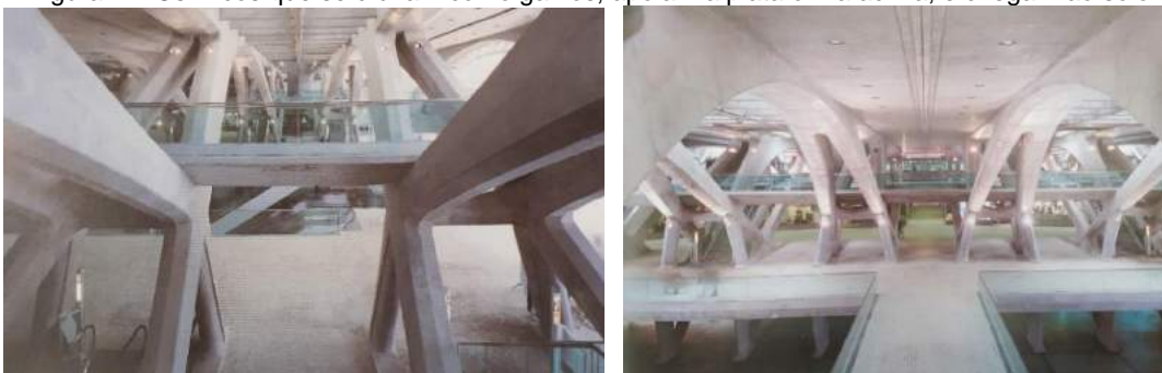
Figura 72: Os Arcos que se cruzam como galhos, apoiam a plataforma acima, e chegam ao solo
