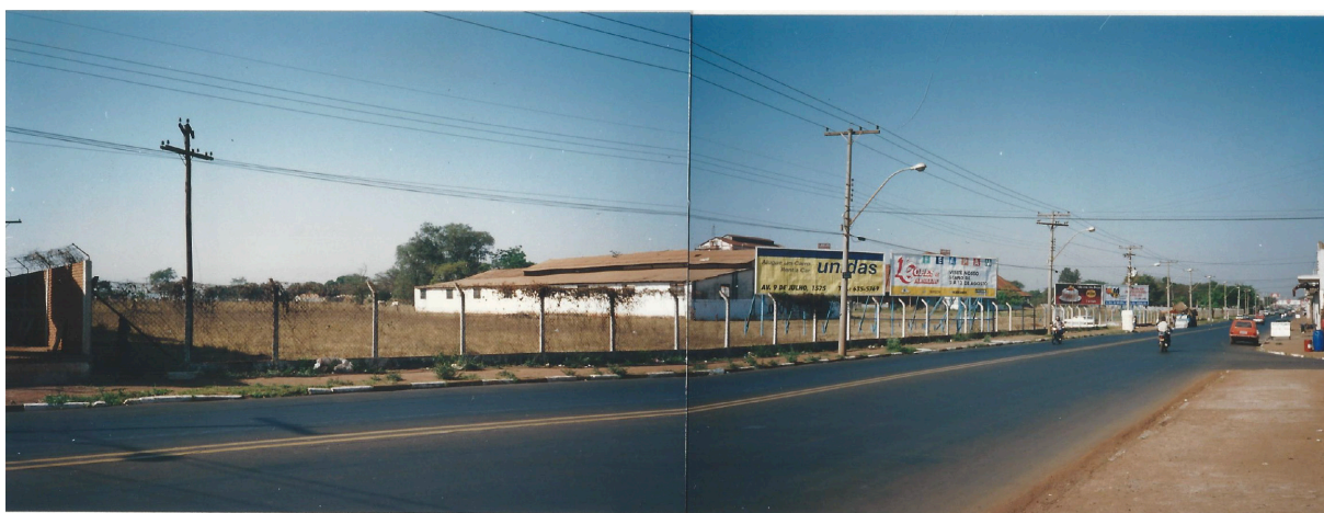
81 Fotografias do terreno de implantação do projeto contido no termo de referência, 1996. Superior: vista da Rua Barretos Inferior: vista da Av. Brasil FONTE: Acervo digital do IABsp, acesso em janeiro de 2023.
