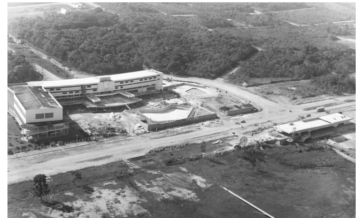
Vista aérea do Santapaula late Clube em obras Foto: sem autor e data / Fonte: Acervo da Biblioteca da FAUUSP
