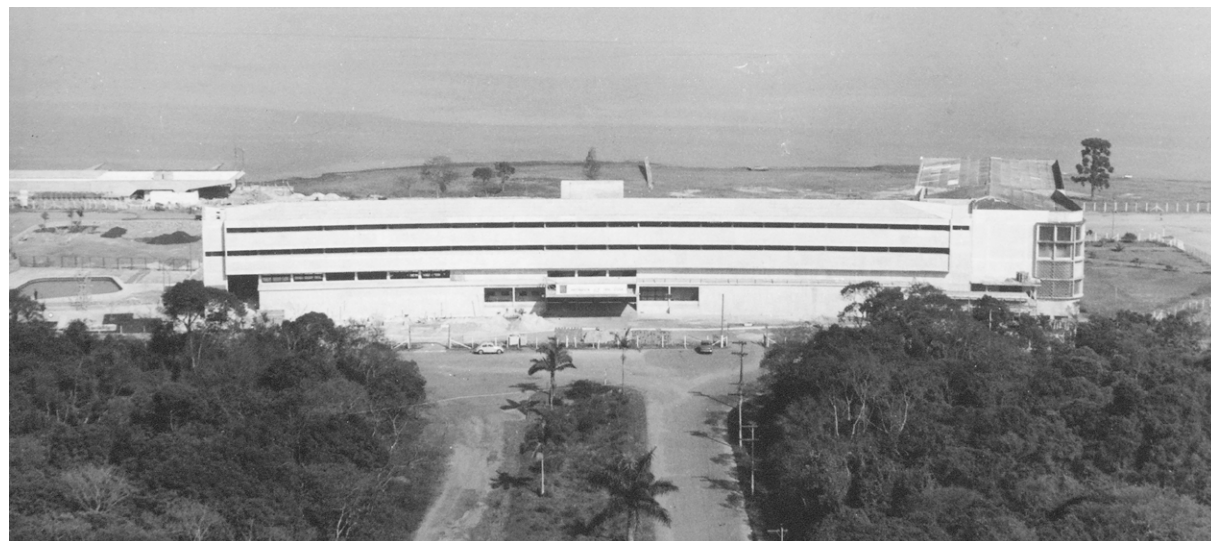
Sede social do Santapaula late Clube em obras - acesso principal alinhado ao eixo do bairro-jardim de Interlagos Foto: sem autor e data / Fonte: Acervo da Biblioteca da FAUUSP
