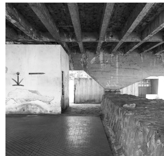
Vista interna à área do bar voltada à cabine de acesso Foto: Bruno Manso, 2020
