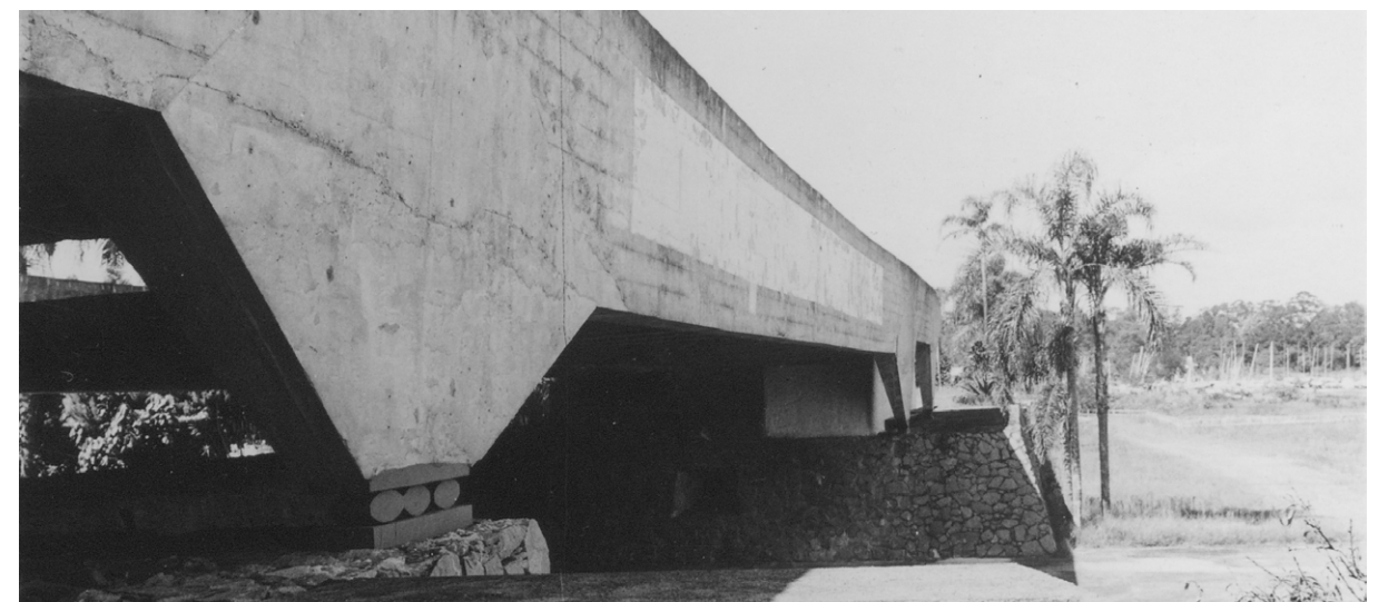
Detalhe do pilar nº06 da garagem de barcos
