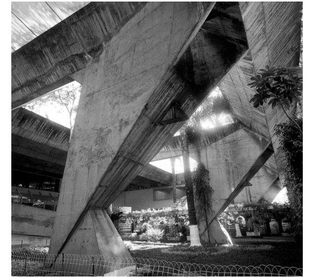
Detalhe dos pórticos do Anhembi Tênis Clube
