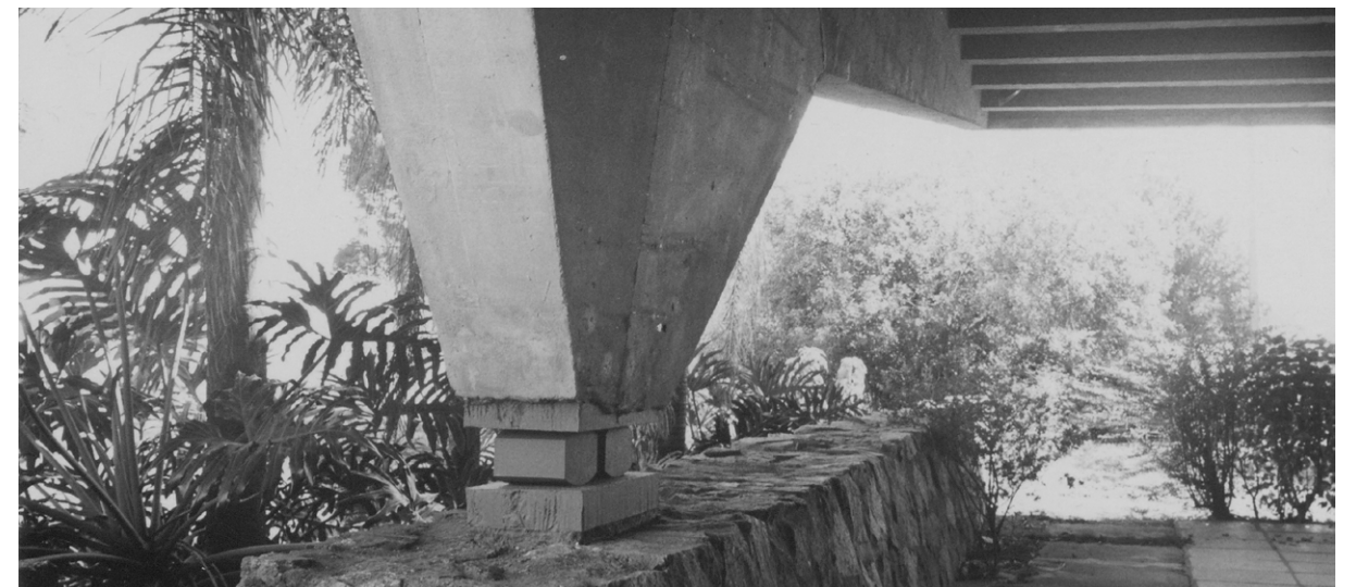
Detalhe do pilar nº05 da garagem de barcos
