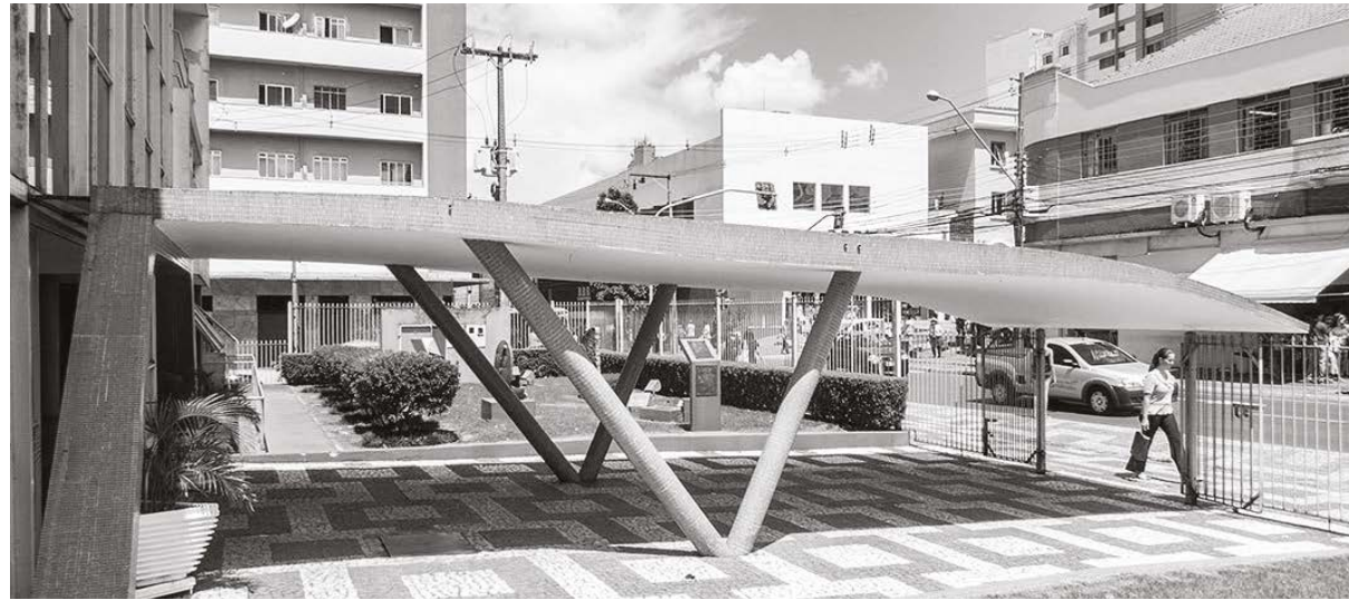
Marquise de acesso à antiga Rodoviária de Londrina Foto: Fernando Stankuns, 2014
