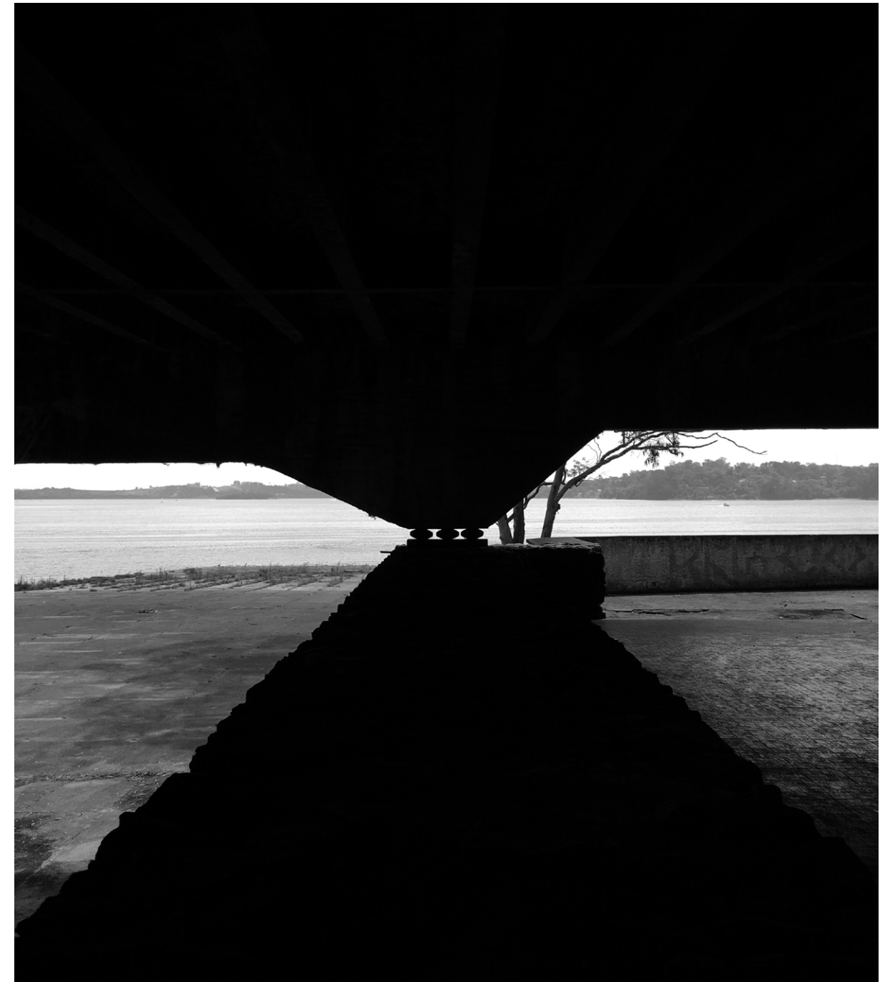
Vista interna ao edifício da garagem de barcos voltada à represa Foto: Bruno Manso, 2020
