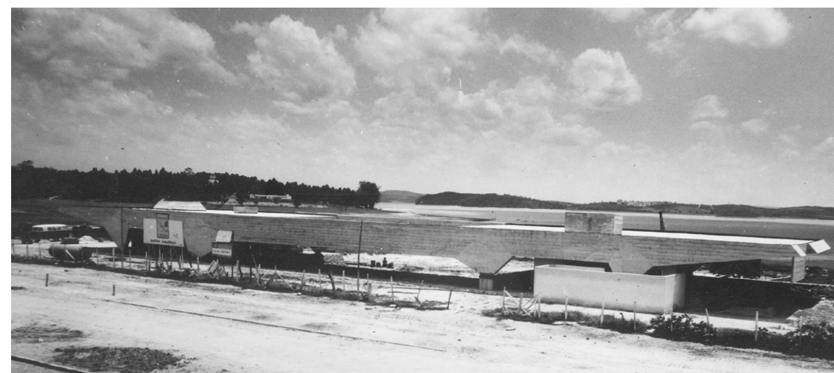
Vista da fachada nordeste da garagem de barcos em obras no início dos anos 60 Foto: sem autor e data / Fonte: Acervo da Biblioteca da FAUUSP
