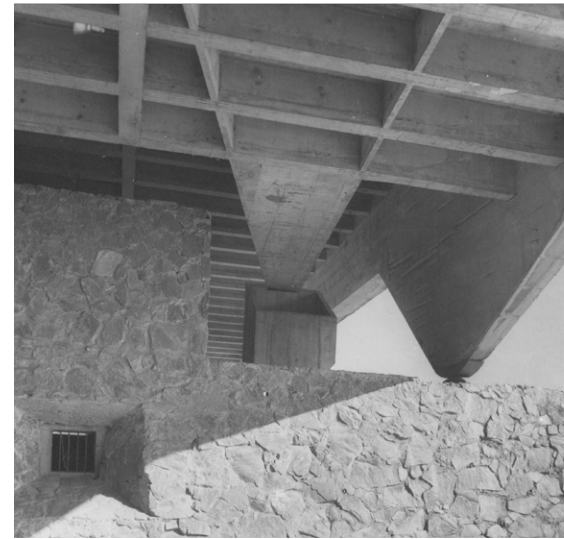
Detalhe da calha pluvial da garagem de barcos Foto: sem autor e data / Fonte: Acervo da Biblioteca da FAUUSP
