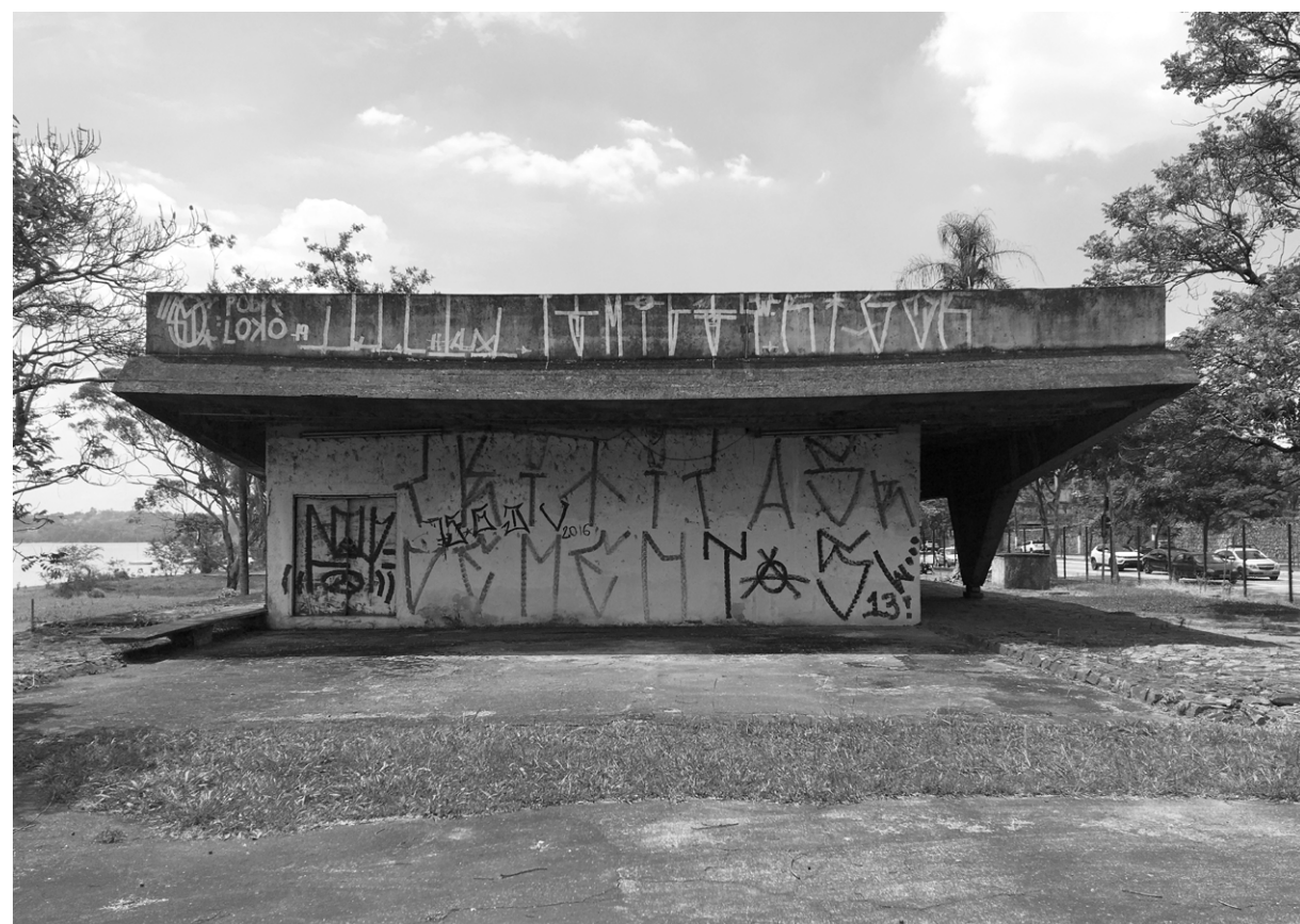
Vista para a elevação sudeste do edifício da garagem de barcos Foto: Bruno Manso, 2020
