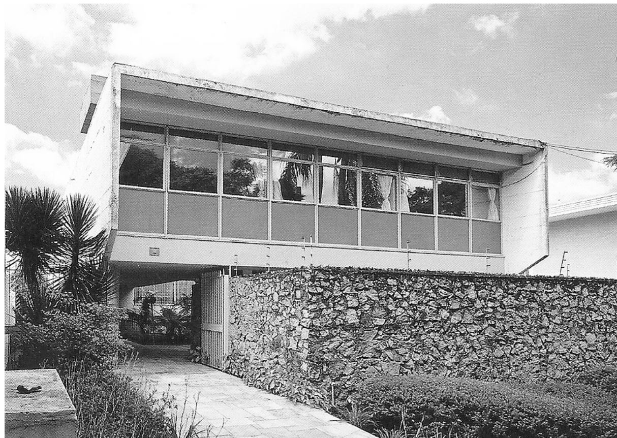
Vista para a fachada frontal da segunda residência a José Mário Taques Bittencourt Foto: Nelson Kon, sem data
