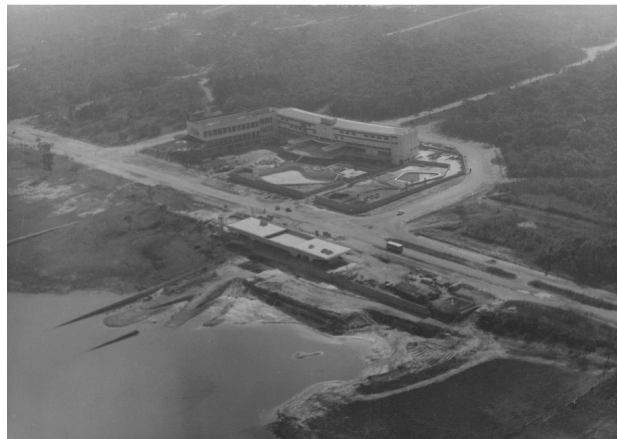
Vista aérea do Santapaula late Clube em obras Foto: sem autor e data / Fonte: Acervo da Biblioteca da FAUUSP
