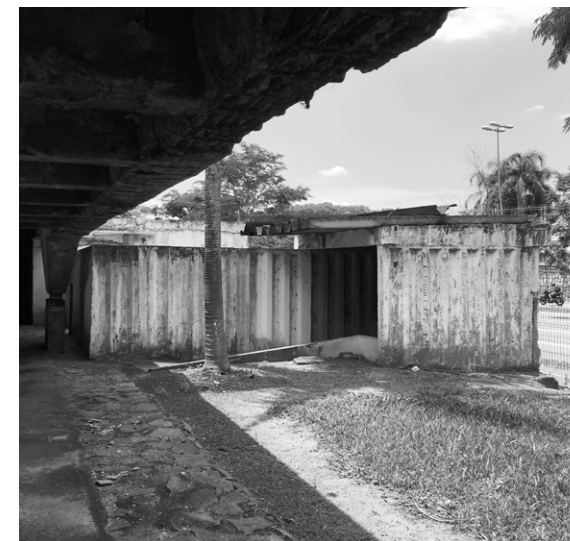
Cabine de acesso pela avenida marginal Foto: Bruno Manso, 2020
