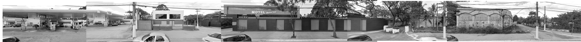
Quadras fiscais F431, F430 e F429 - ao norte da antiga sede social do Santapaula / face voltada à via marginal
