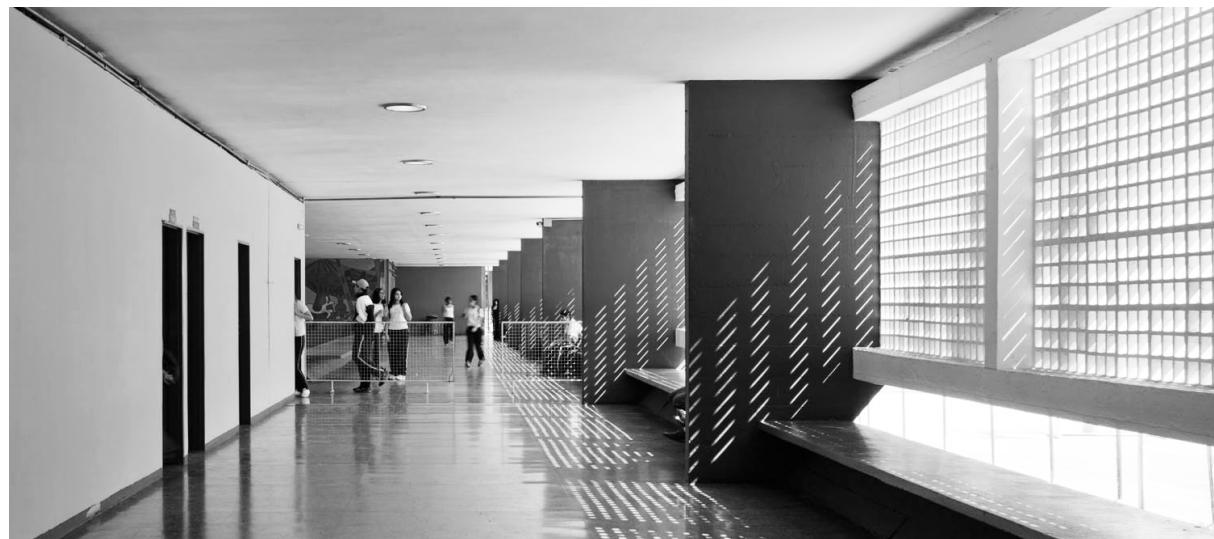
Detalhe dos elementos vazados pré-moldados em argamassa prensada no Ginásio Estadual de Guarulhos Foto: Nelson Kon, sem data
