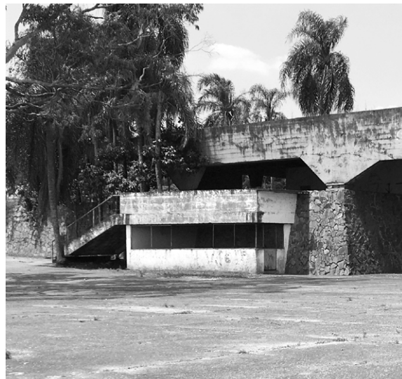
Anexo sob a escada-mirante para o bar Foto: Bruno Manso, 2020
