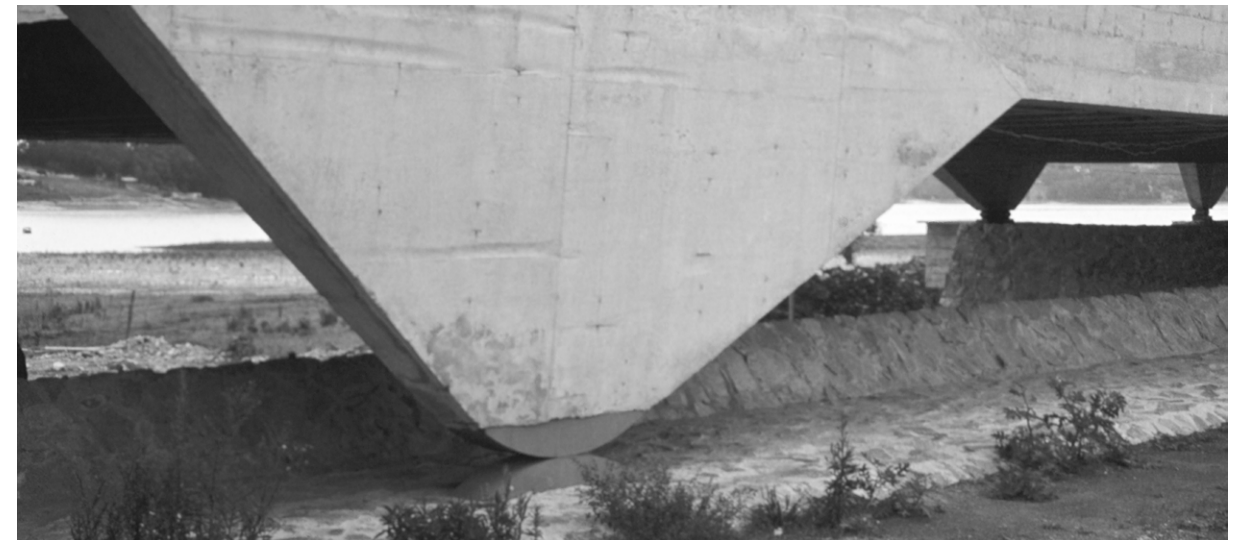
Detalhe do pilar nº03 da garagem de barcos
