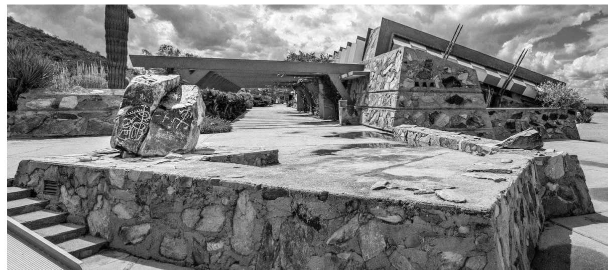
Detalhe dos arrimos de pedra no Taliesin West Foto: Paul Vanderveen, 2017
