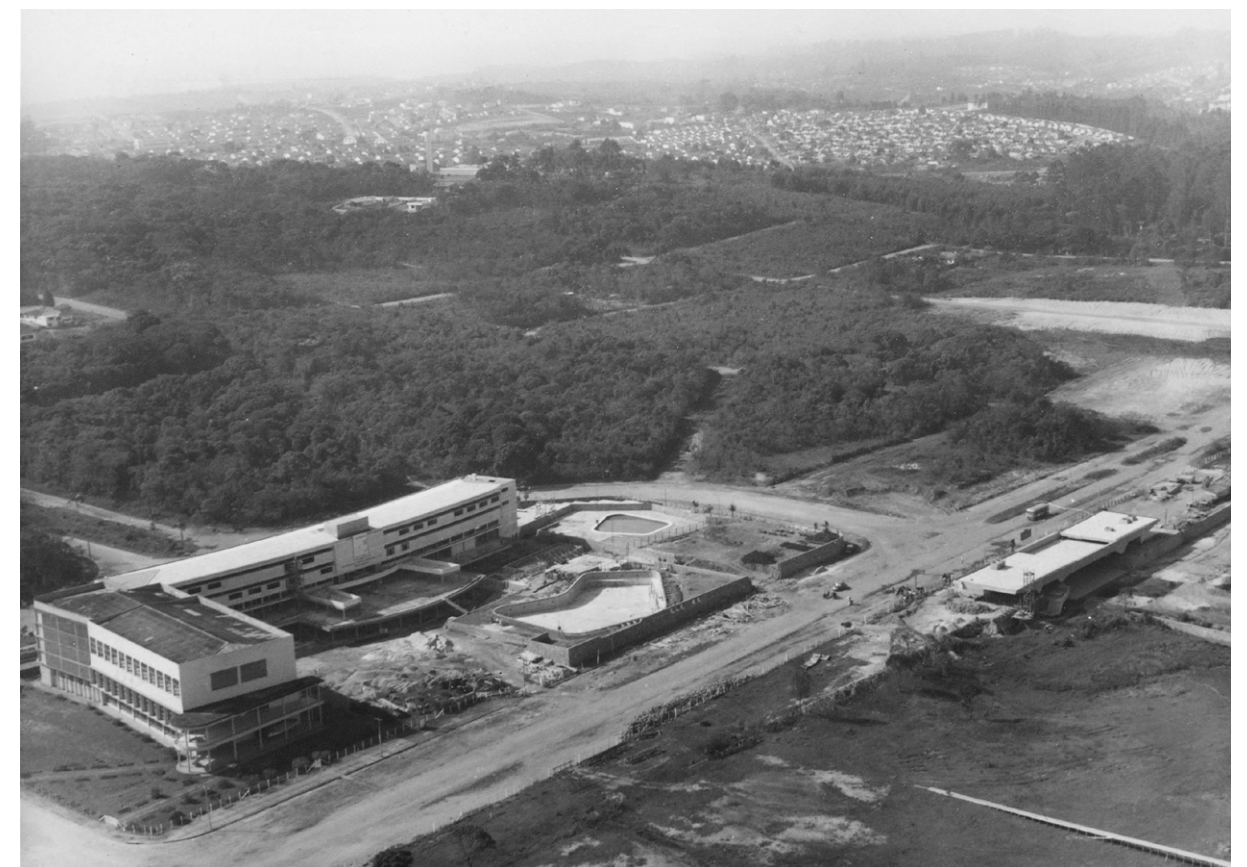
Santapaula late Clube em obras, bairro-jardim ainda sem ocupação, início da década de 1960 Foto: sem autor e data / Fonte: Acervo da Biblioteca da FAUUSP
