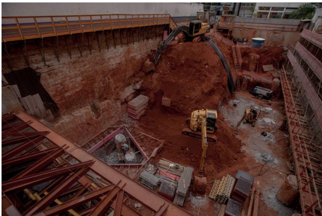
Figura 79 - Execução do subsolo (3 de outubro de 2014)
