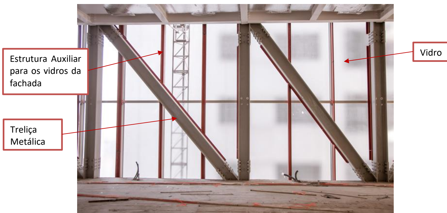
Figura 112 -Fachada em construção, vista interna- (17 de fevereiro de 2017)
