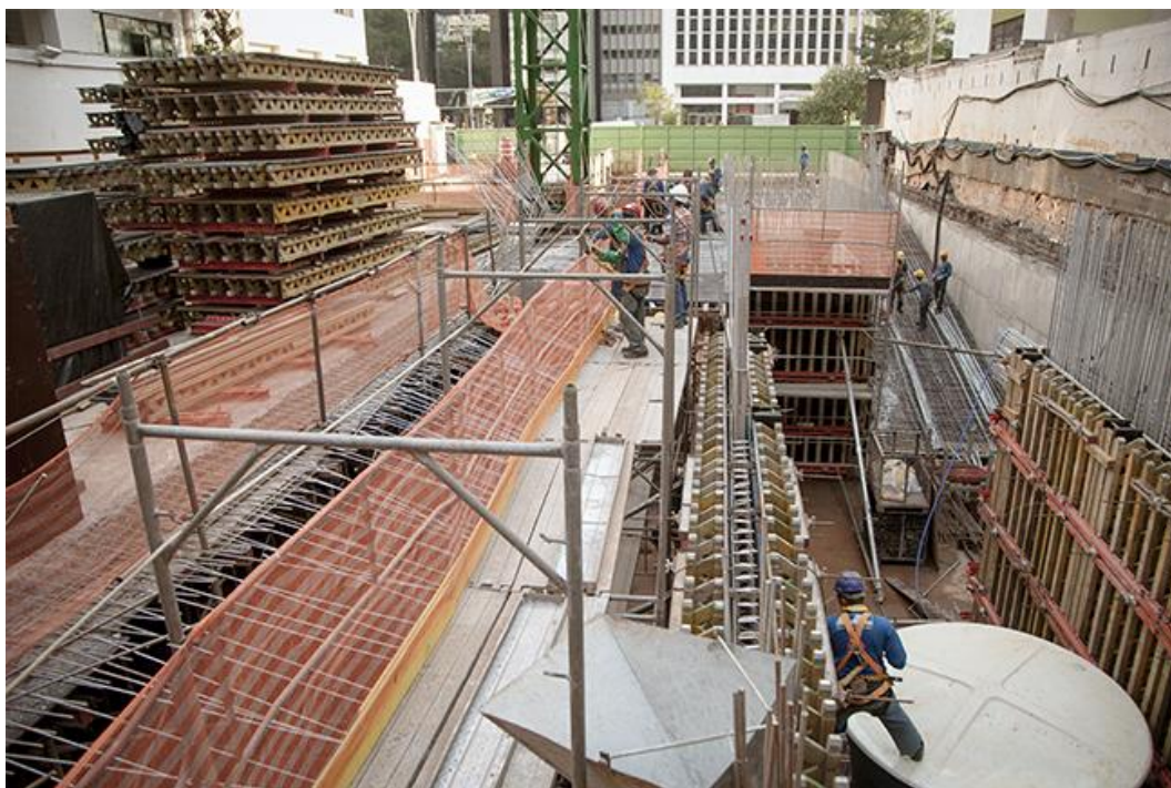
Figura 81 - Execução do subsolo (16 de janeiro de 2015)
