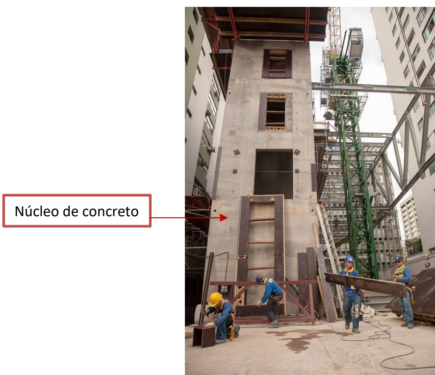
Figura 88 - Execução do núcleo de concreto (28 de outubro de 2015)
