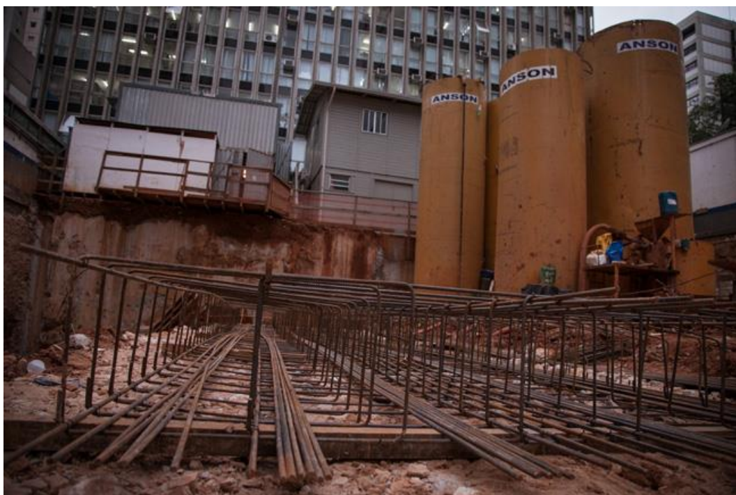
Figura 78 - Execução do subsolo (25 de julho de 2014)
