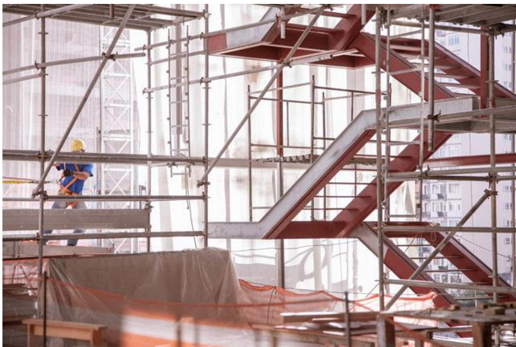
Figura 132 - Escada metálica em construção (20 de março de 2017)
