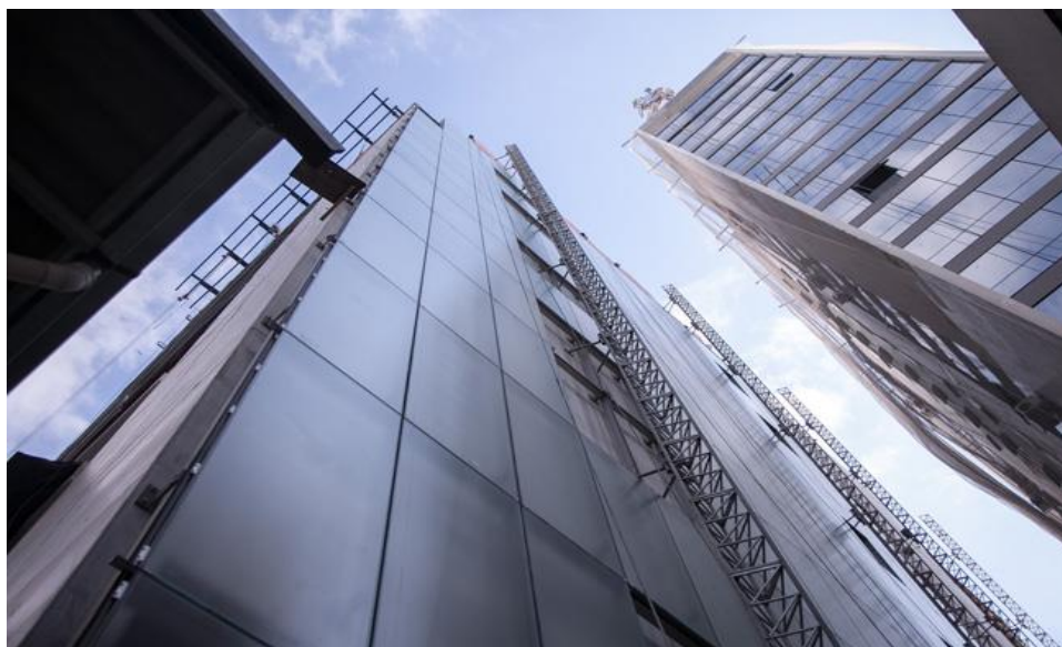
Figura 110 -Fachada em construção vista externa - (28 de outubro de 2016)
