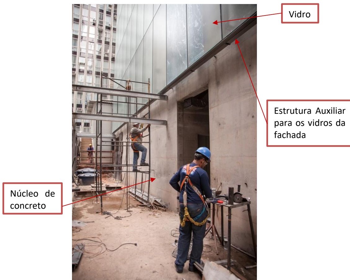
Figura 111-Fachada em construção, vista externa- (31 de janeiro de 2017)
