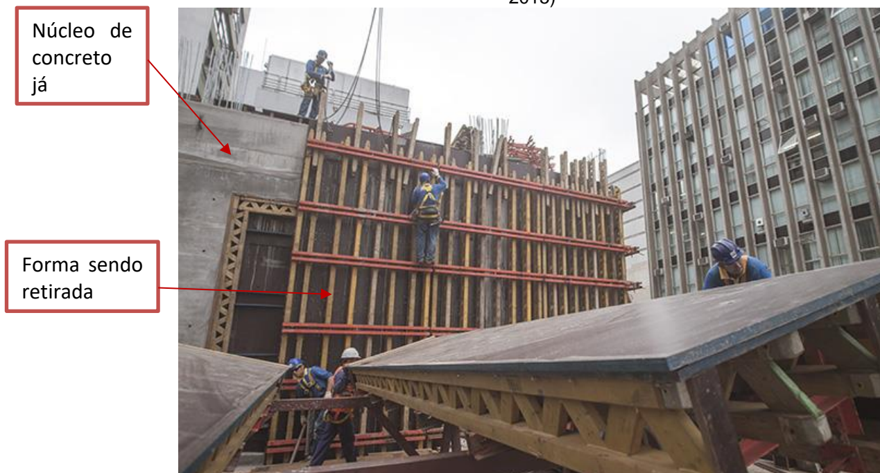
Figura 91 - Retirada das formas do núcleo de concreto para fixação da metálica (16 de novembro de 2015)
