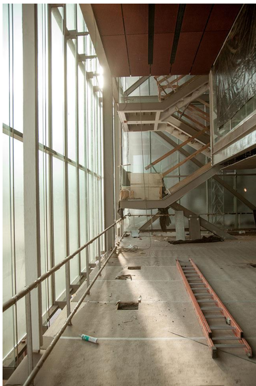
Figura 126 - Execução do piso de basalto, imitando o mosaico português da antiga Av. Paulista (18 de julho de 2017)
