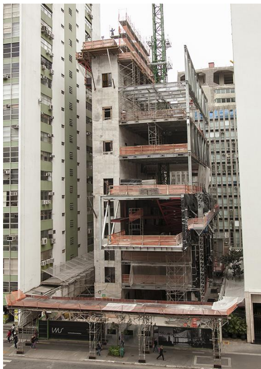
Figura 74 - Foto da obra, onde é possível identificar o núcleo de concreto e a estrutura metálica
