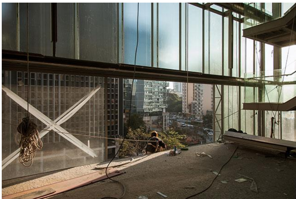
Figura 127 – Construção do piso no térreo elevado (28 de julho de 2017)
