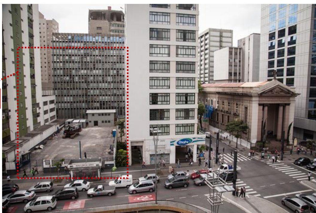
Figura 76 - Terreno do IMS antes da construção (21 de novembro de 2013)
