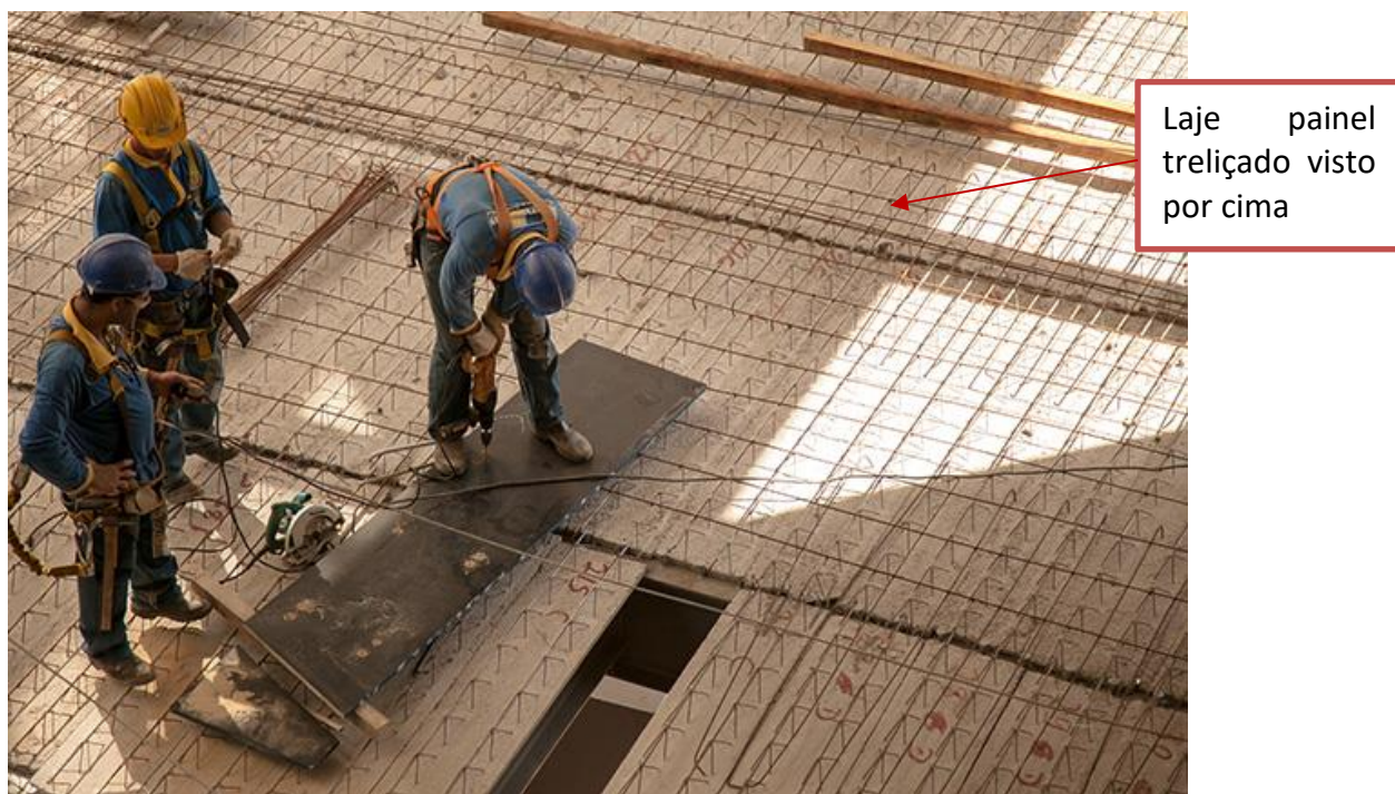
Figura 96 - Laje painel em execução (12 de fevereiro de 2016)
