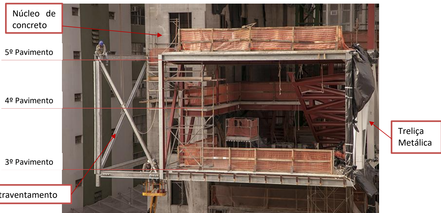
Figura 99 - Laje e estrutura metálica dos pavimentos superiores do IMS (10 de junho de 2016)
