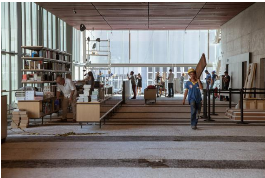
Figura 129 – Piso na área da loja do pavimento térreo elevado (12 de setembro de 2017)
