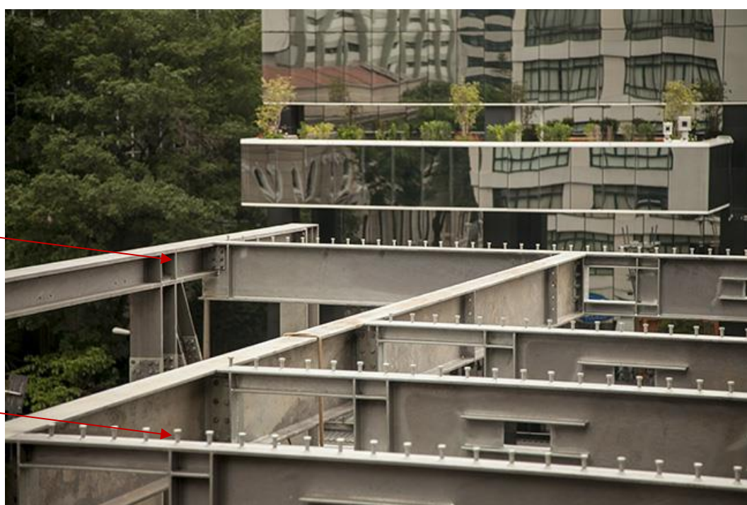
Figura 93 - Vigas metálicas e Stud Bolt para posterior fixação da laje painel (1 de dezembro de 2015)
