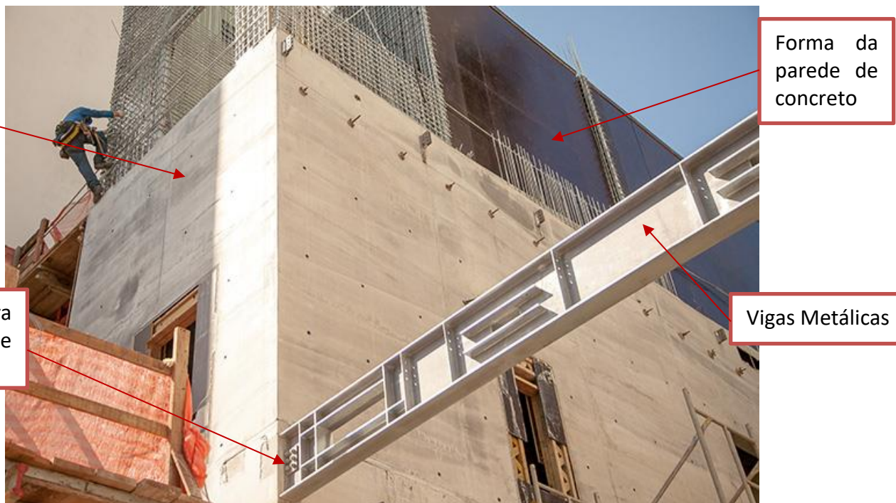
Figura 95 - Viga metálica fixada no núcleo de concreto (12 de fevereiro de 2016)
