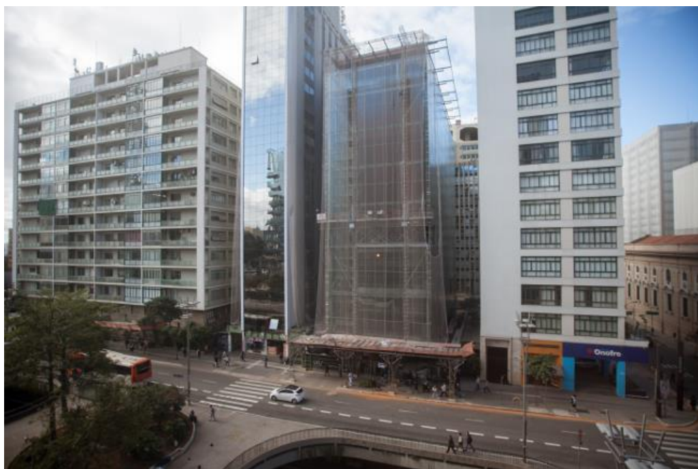
Figura 119 – Fachada do IMS- (30 de junho de 2017)
