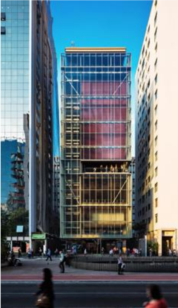
Figura 23 - Fachada do IMS
