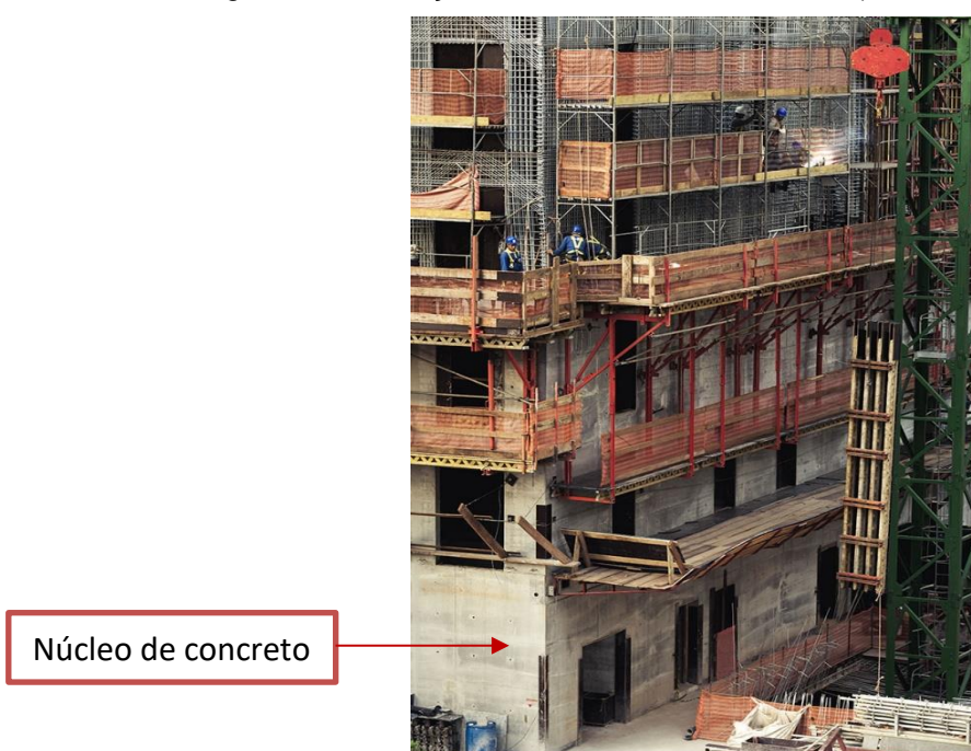
Figura 87 - Execução do core: núcleo de concreto (22 de setembro de 2015)
