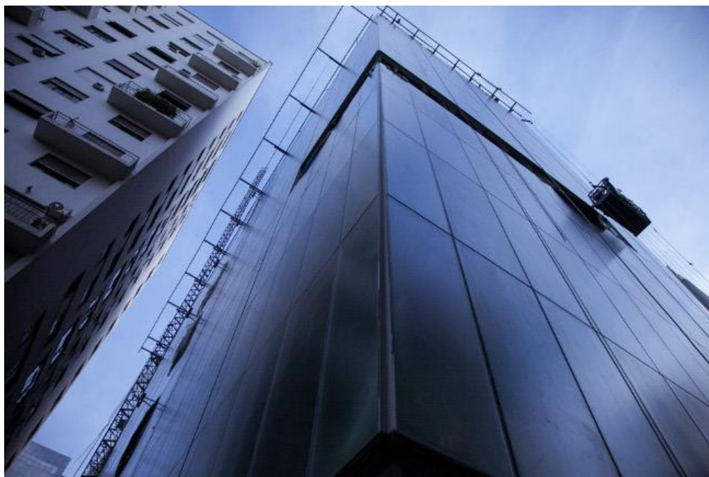
Figura 116 – Fachada concluída (29 de maio de 2017)
