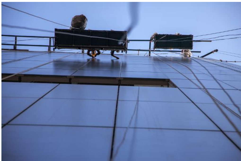
Figura 115 -Fachada, vista externa (12 de maio de 2017)
