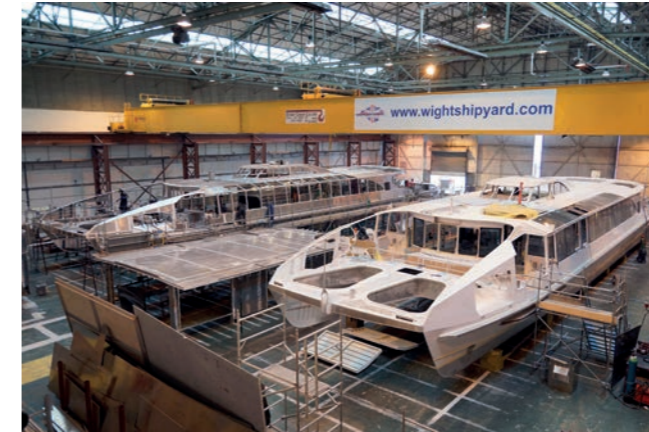
Ilustração: Foto da embarcação Thames Clippers no estaleiro, em processo de construção.
