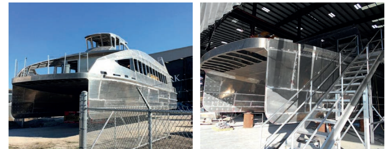
Ilustrações: Fotos da embarcação NYC Ferry, ainda em construção.
