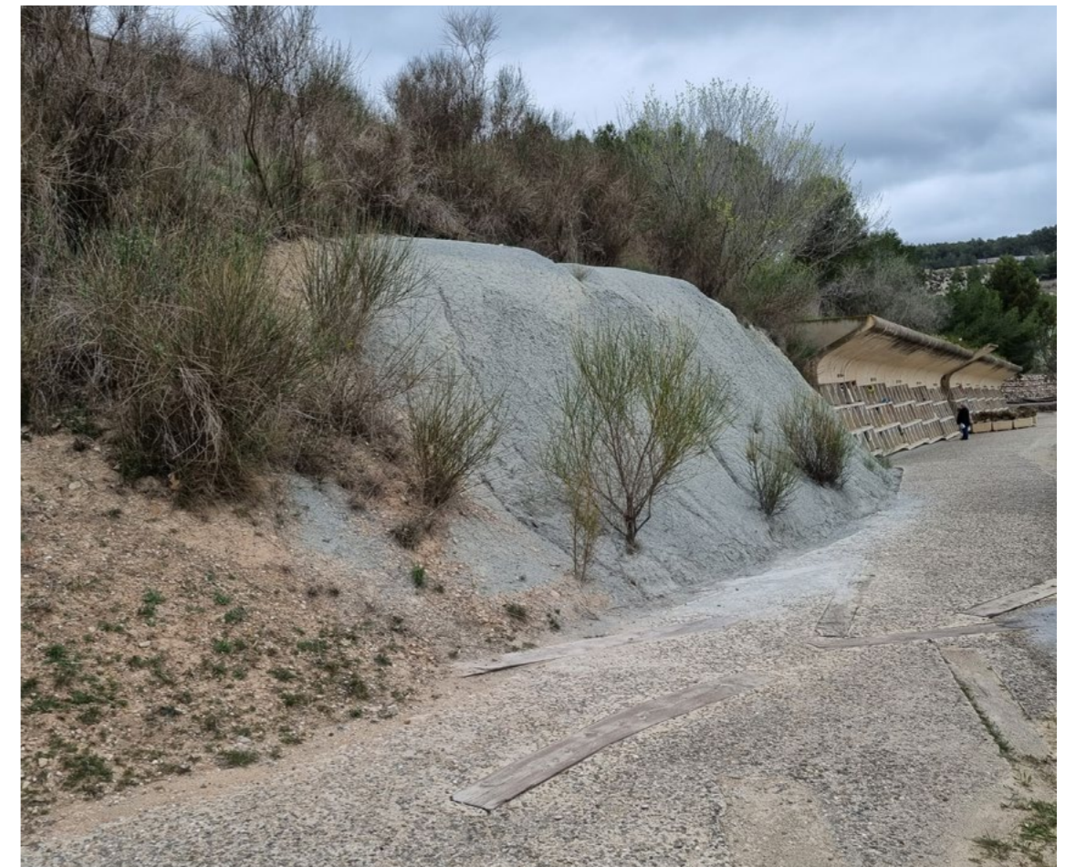
051 - Rampa de Descida - O piso se mescla com a terra e o concreto apresenta o limo da chuva
