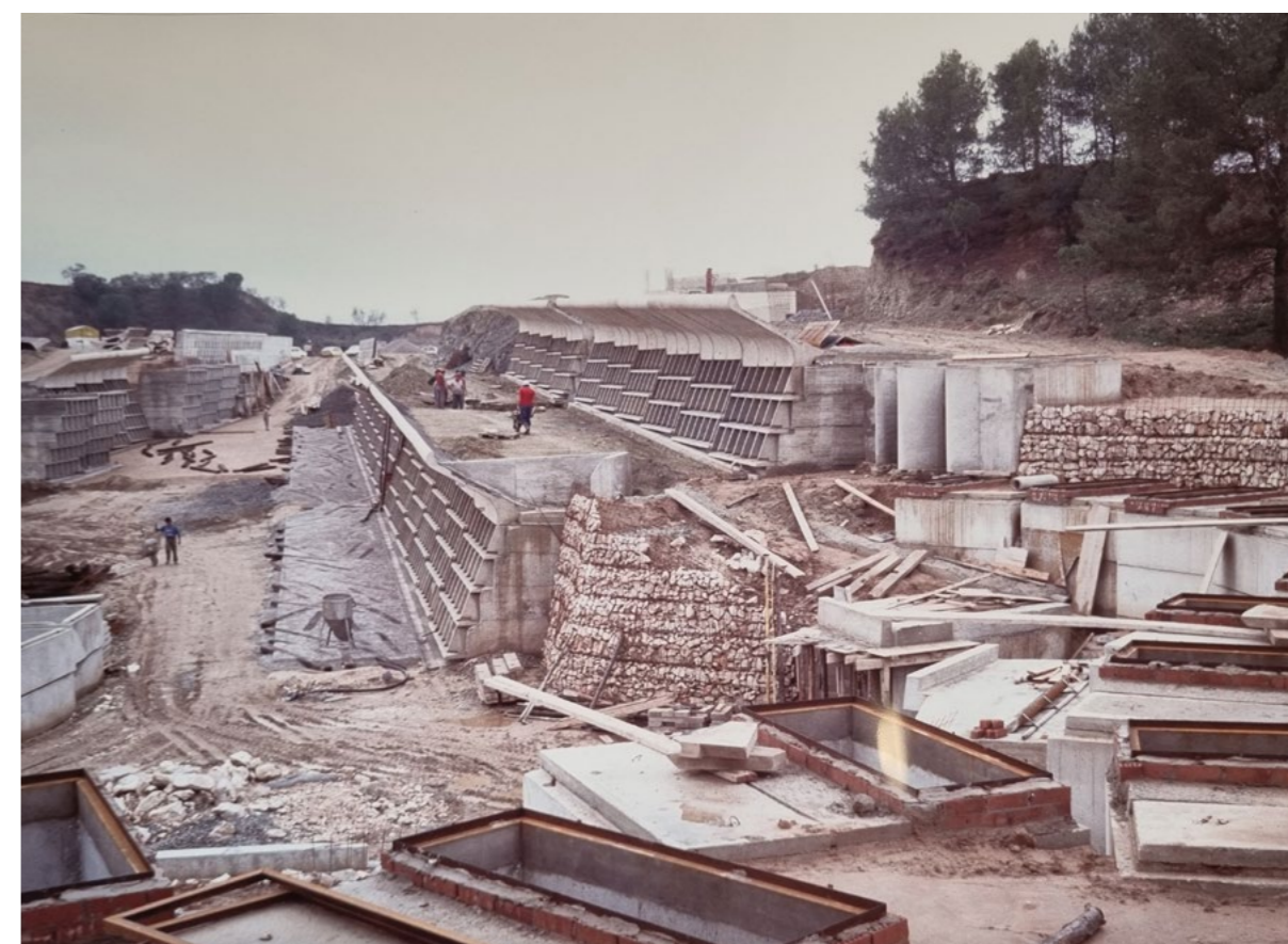
043 - Foto de Obra - Início da instalação do piso da rampa
