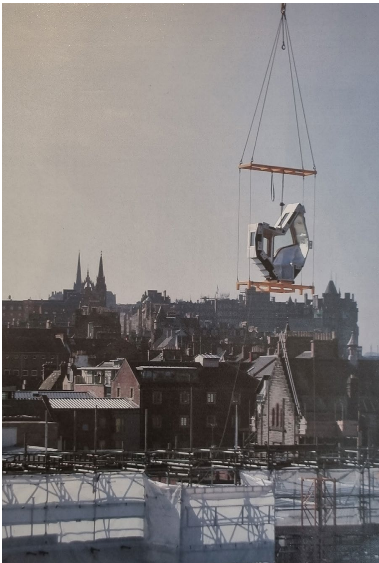
006 - Instalação das Janelas-Assento dos Parlamentares - Parlamento de Edimburgo - 1998-2004
