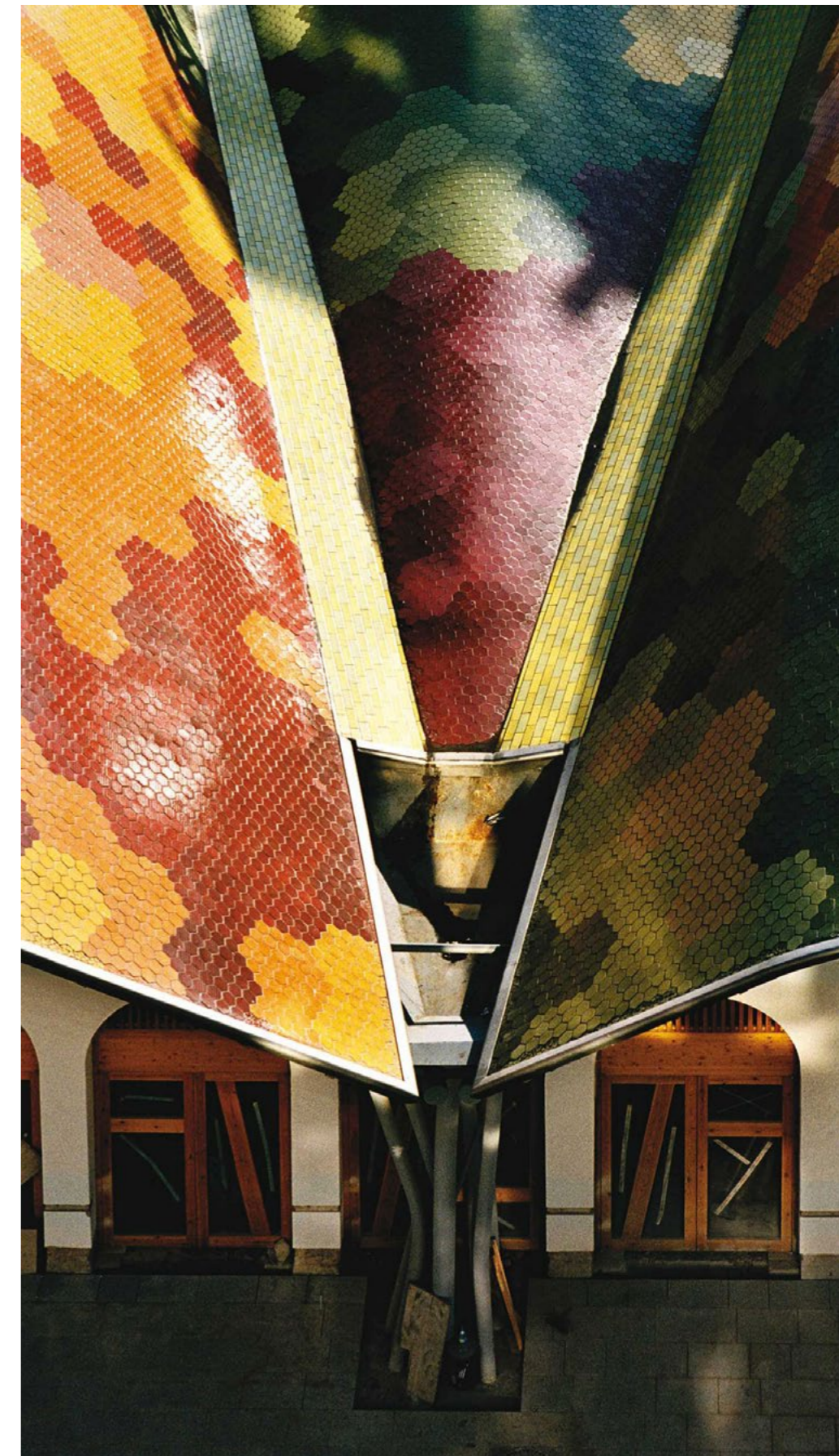
095 - Mercado de Santa Caterina - Detalhe caimento e escoamento pluvial pelos pilares
