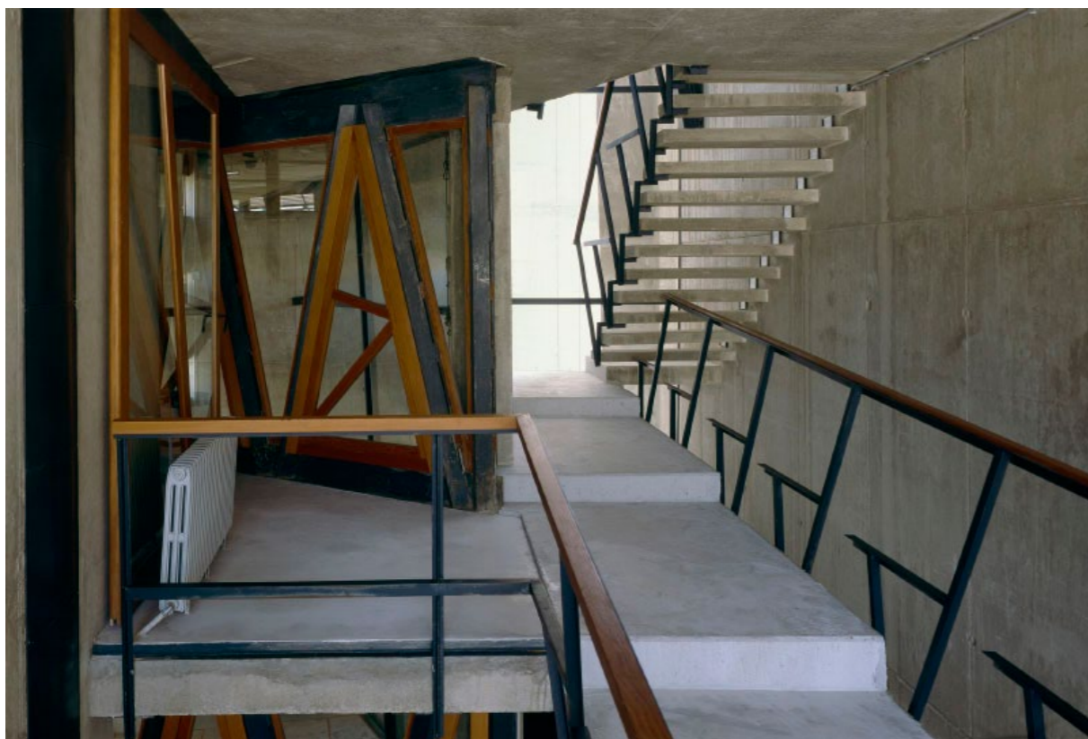
069 - Hostalets Civic Center - Escadas - Duccio Malagamba.
