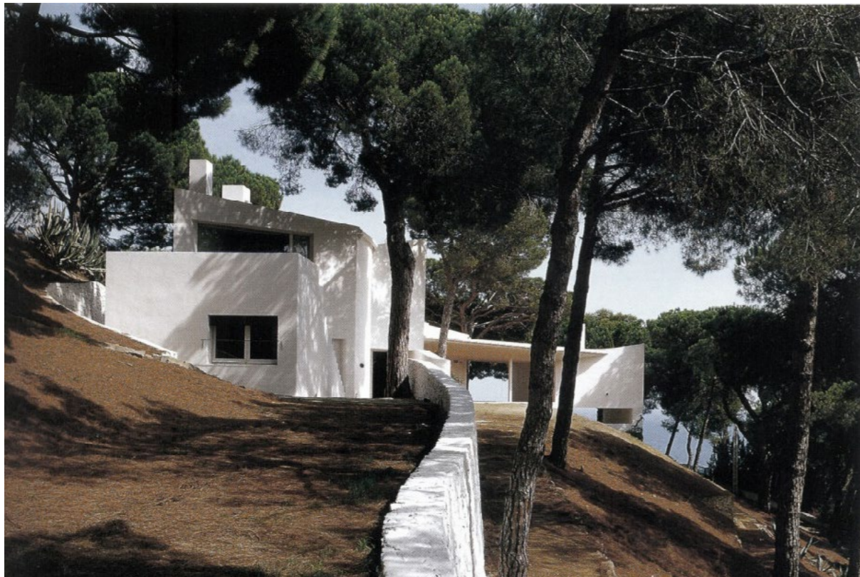
005 - Casa Ugalde - 1951 - José Antonio Coderch & Manuel Valls Vergés Disponível em: < https://www.epdlp.com/edificio4.php?id=179 > Acesso em: 02 de jan. de 2023.
