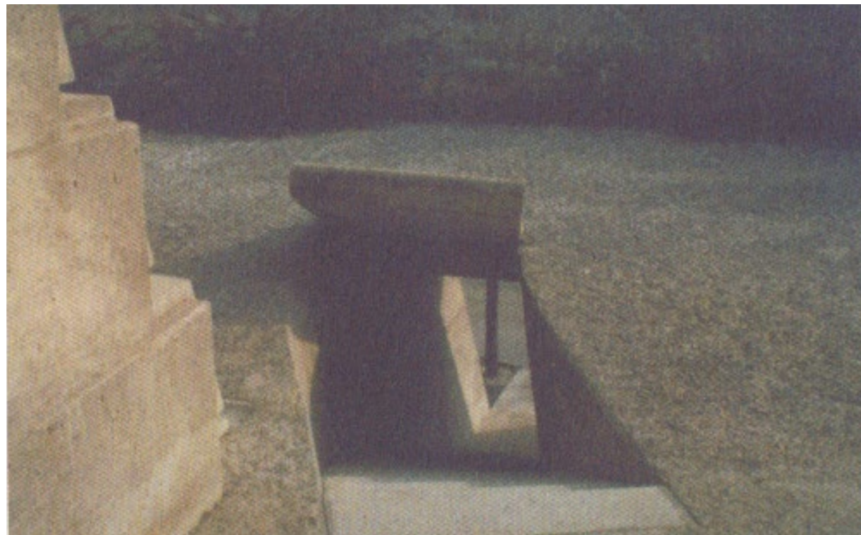
o67 - Patamar Intermediário da Escada
