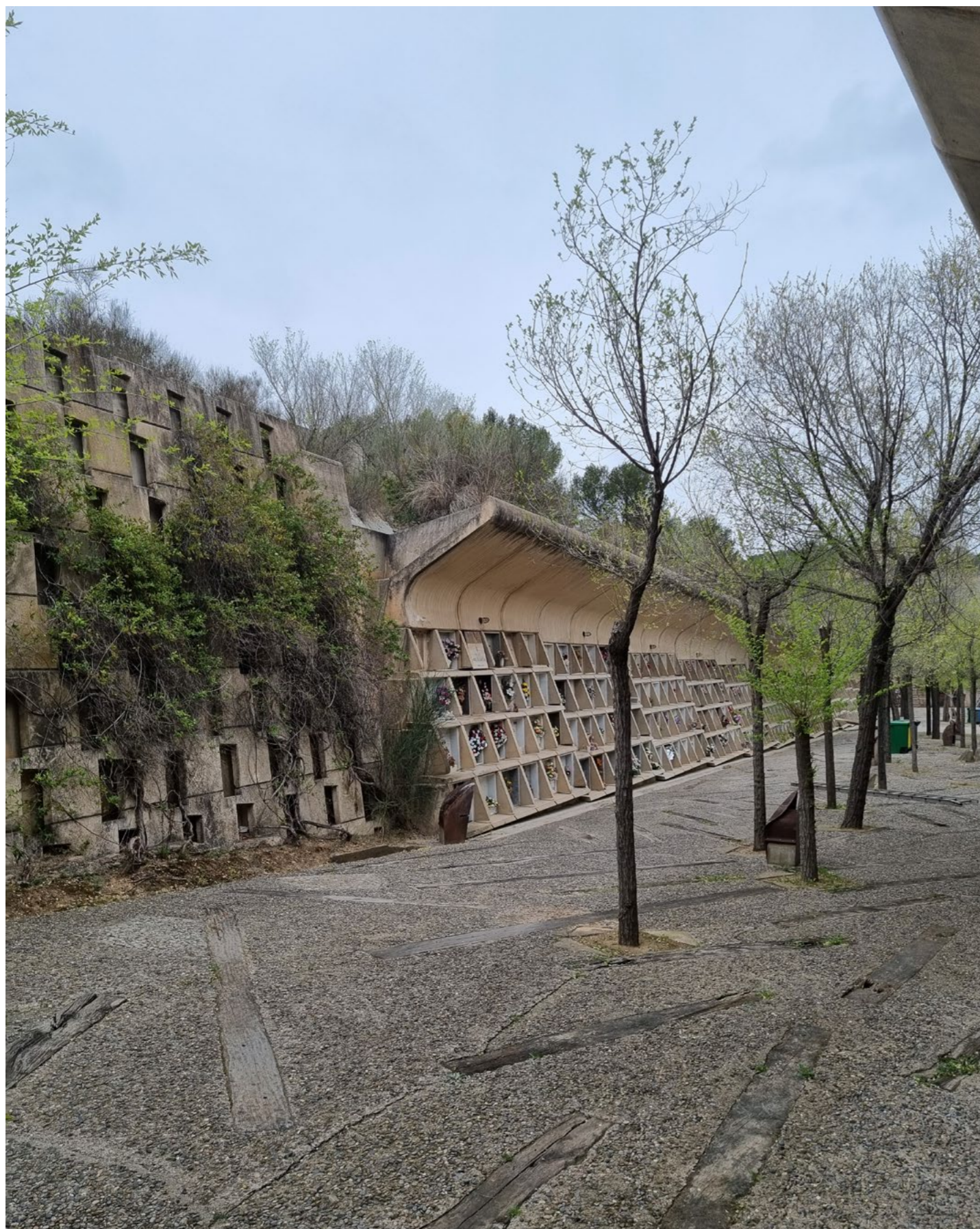
029 - Rampa de Descida e Muros de Sustentação
