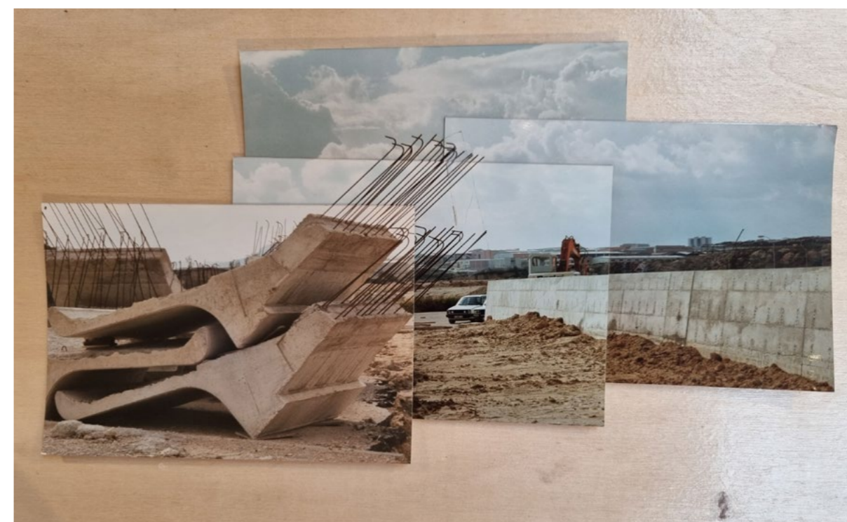
042 - Foto de Obra - Capitéis que enceram os lóculos e suportam a terra sobre os corpos
