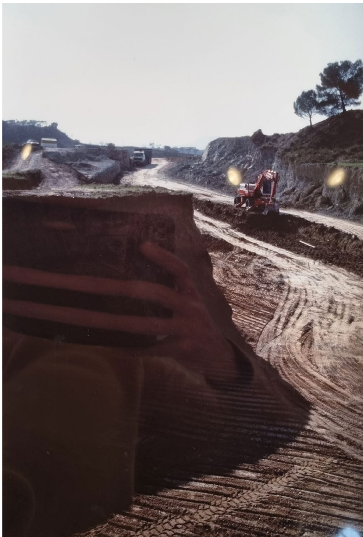
041 - Foto de Obra - Movimentação de Terra
