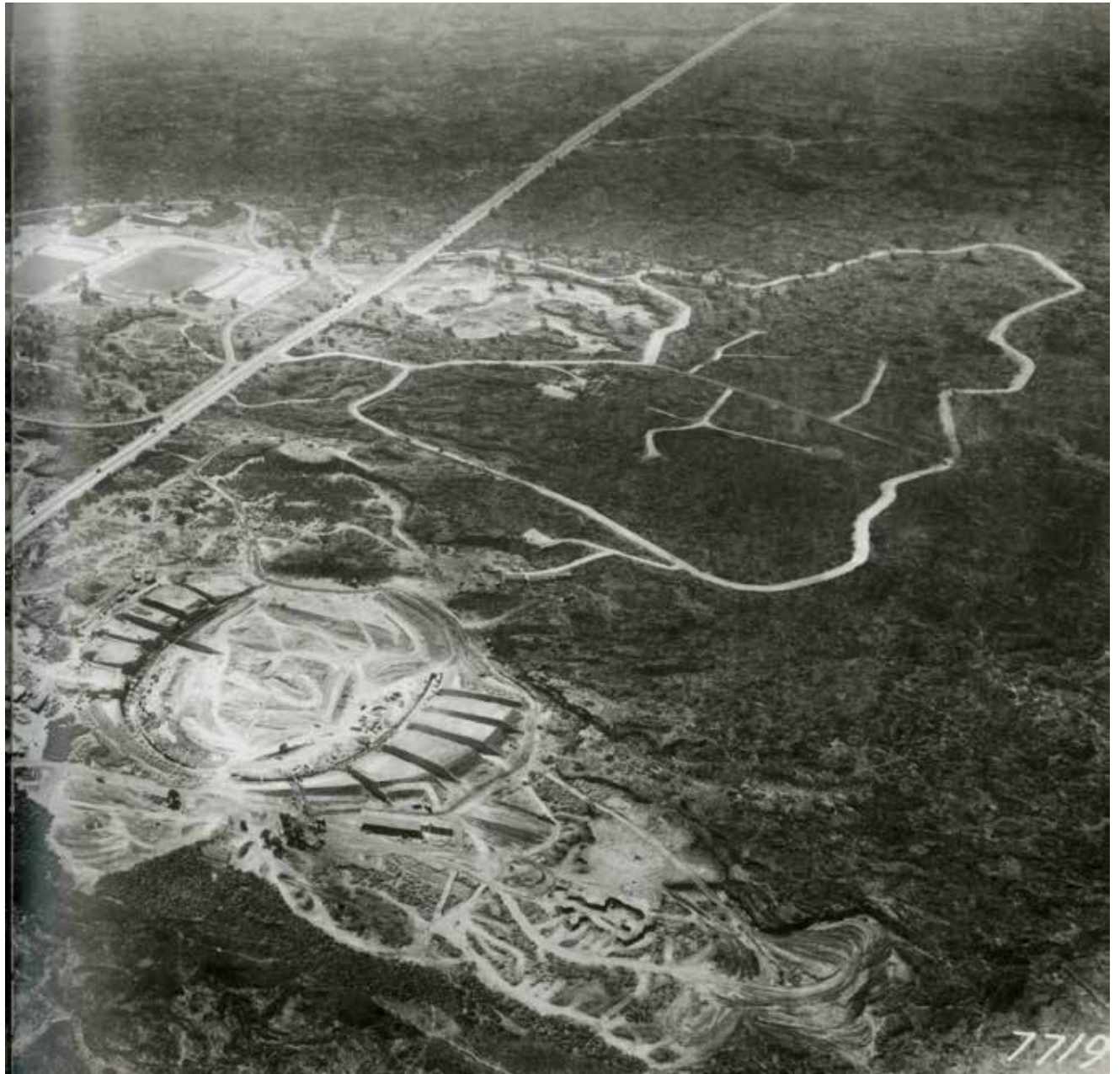
178. Foto aérea da obra do Estádio Olímpico com os cortes do terreno vulcânico para rebaixo do terreno e construção dos túneis. Fonte: CRUZ, 2011.
