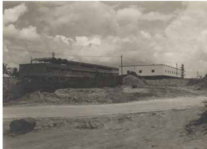
65. Instituto de Puericultura em obras. Vista do Hospital e do Ambulatório. Fonte: NPD / UFRJ
