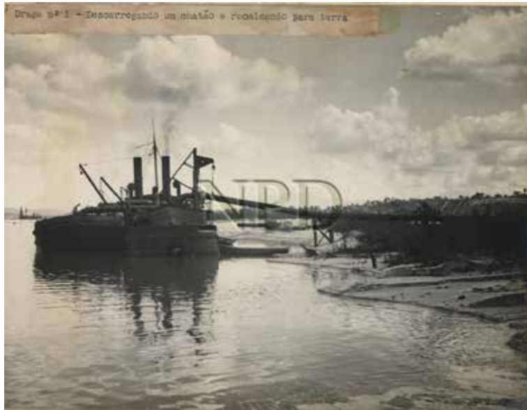
40. Draga Nº 01 Descarregando um Chatão e recalçando para a terra. Fonte: NPD/UFRJ
