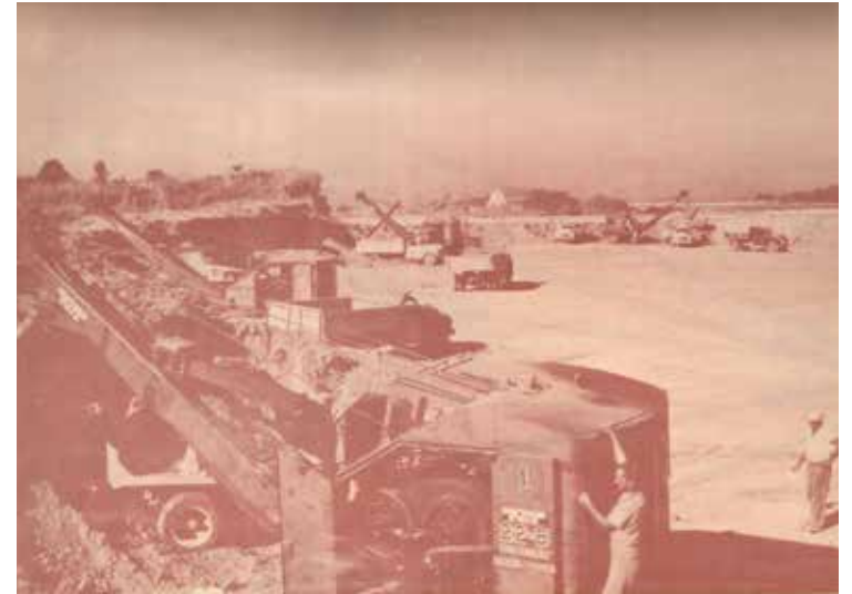
37. Escavadeiras na Ilha do Fundão. Fonte: Relatório de Atividades do ETUB em 1952- NPD / UFRJ
