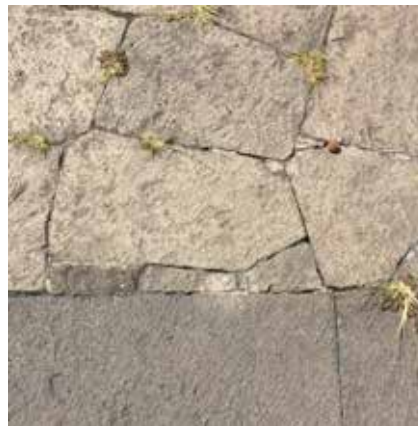
106. Degraus em pedras da Reitoria. Fonte: Autora, 2022.
