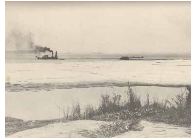
39. Dragagem e aterro com areias retiradas dos bancos. Fonte: Relatório de Atividades do ETUB em 1953- NPD / UFRJ
