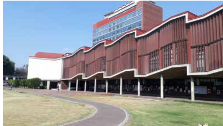
110. Brise em terra-cota na fachada das salas de aula na Faculdade de Ciências. Fonte: Autora, 2022.
