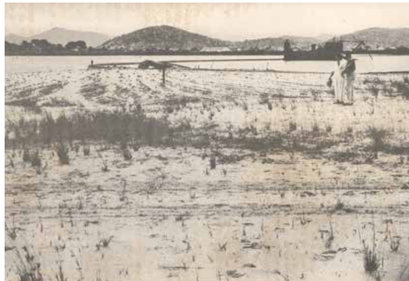
38. Obras gerais - uma das três dragas realizando aterro hidráulico. Fonte: Relatório de Atividades do ETUB em 1953- NPD / UFRJ
