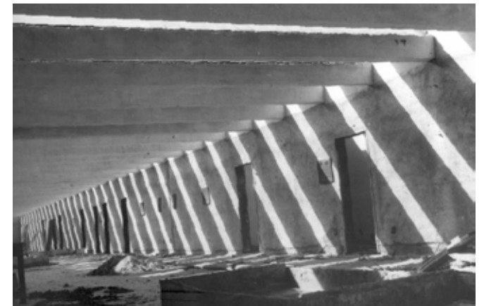
67. Instituto de Puericultura em obras. Vista do Primeiro Pavimento do Ambulatório. Fonte: NPD / UFRJ
