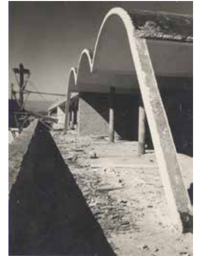
66. Instituto de Puericultura em obras. Vista do Segundo Pavimento do Hospital. Fonte: NPD / UFRJ
