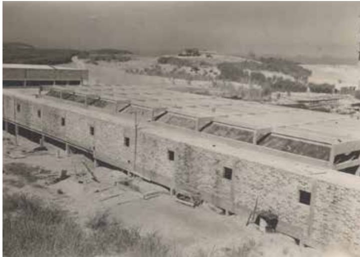
64. Instituto de Puericultura em obras. Vista a partir do Ambulatório. Fonte: NPD / UFRJ
