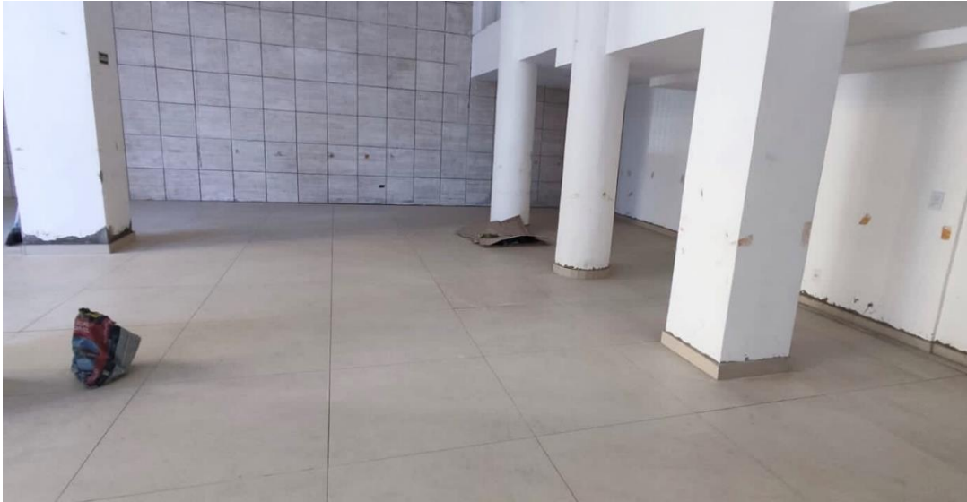
Figura 85 – Saguão de entrada: assentamento de revestimento (Fonte: Alexandre Hodapp, 2022)
