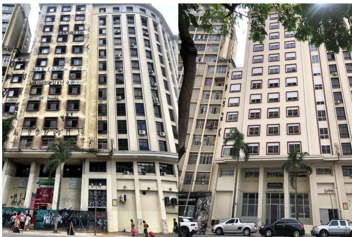
Figura 77 e 78– Antes (2019) e depois (2022) Edifício Residencial Cambridge em reabilitação, fachada para a Av. 9 de Julho, Centro - SP (Fonte: Nancy Laranjeira, 2019/2022)
