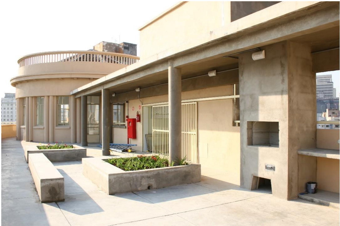
Figura 33 – Cobertura Ed. Riachuelo após a reabilitação (Fonte: Imagem cedida por Pedro Bruna)
