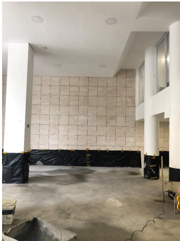
Figura 84 – Saguão de entrada: regularização para assentamento de revestimento (Fonte: Nancy Laranjeira, 2019)
