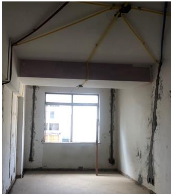
Figura 80 – Reabilitação em andamento 7º. Andar (Fonte: Nancy Laranjeira, 2019)
