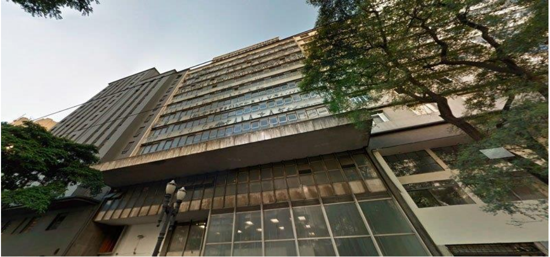
Figura 44 – Fachada do Edifício Dandara antes da reabilitação (Fonte: https://apublica.org/2018/06/milhares-de-imizeis-da-uniao-estao-vagos-para-uso/ )
