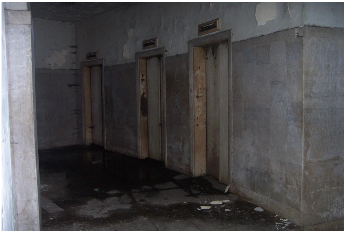
Figura 26 – Hall dos elevadores Edifício Riachuelo quando da vistoria inicial pelo escritório Paulo Bruna Arquitetos Associados (Fonte: Imagens cedidas por Pedro Bruna)
