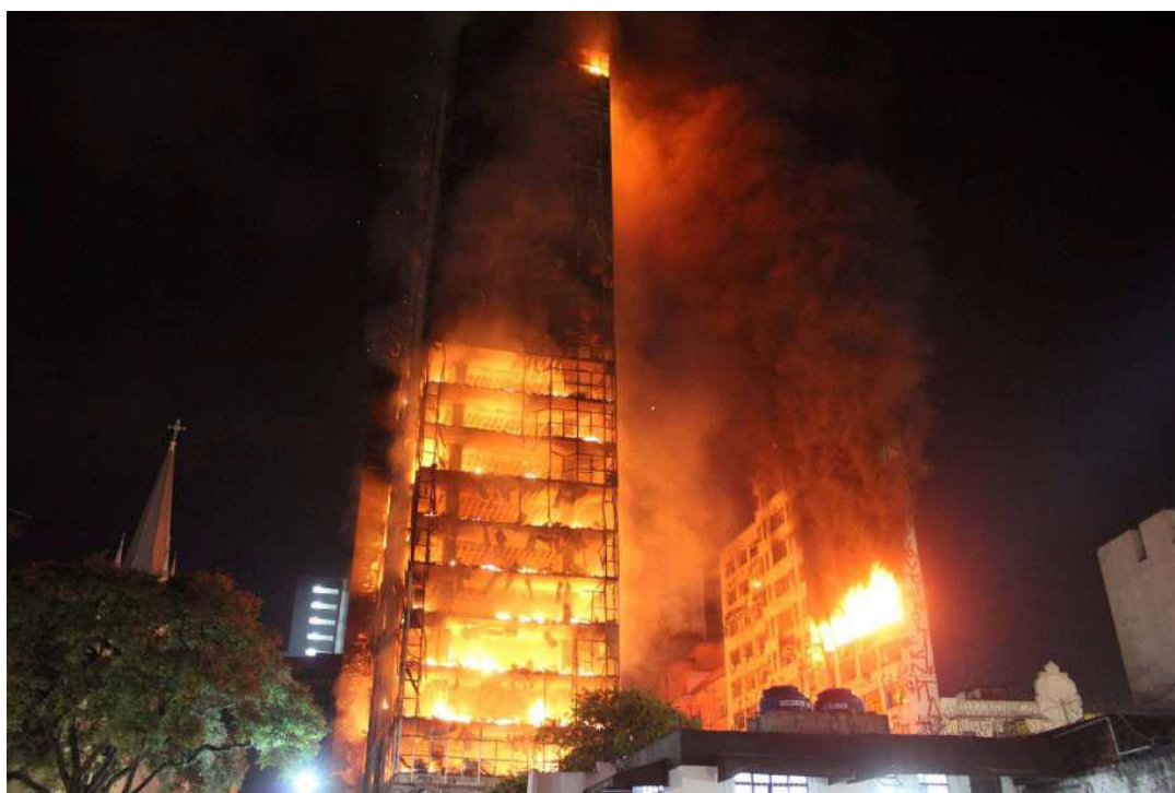
Figura 02 – Edifício Wilton Paes em chamas 1º. De maio 2018 (Fonte imagem: Folha Press)
