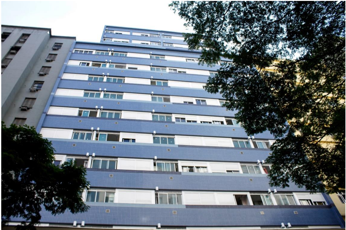
Figura 45 – Edifício Dandara - Fachada após reabilitação (Fonte: Daia Oliver, 2018)
