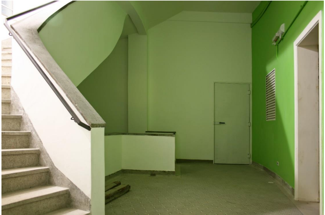
Figura 40 – Depois – Hall de elevadores após a reabilitação (Fonte: Imagem cedida por Pedro Bruna)
