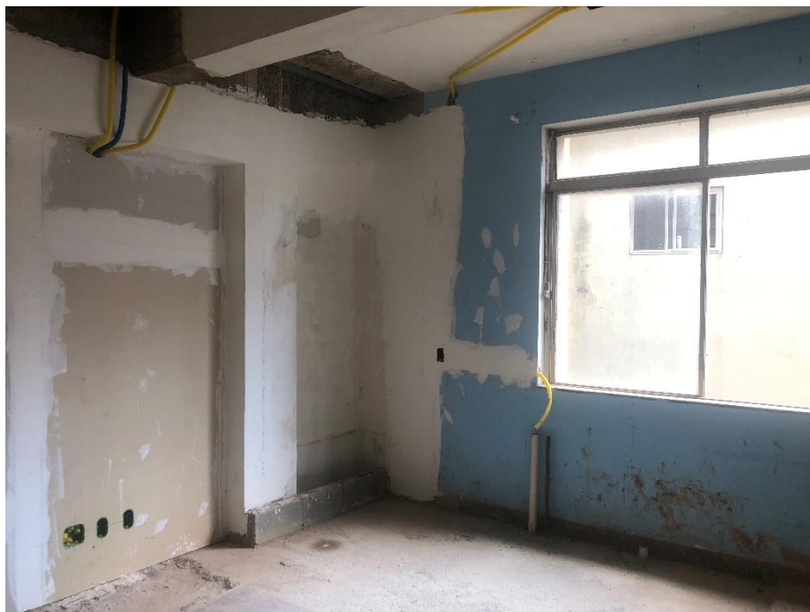
Figura 71 – Reabilitação em execução 7º. Andar (Fonte: Nancy Laranjeira, 2019)
