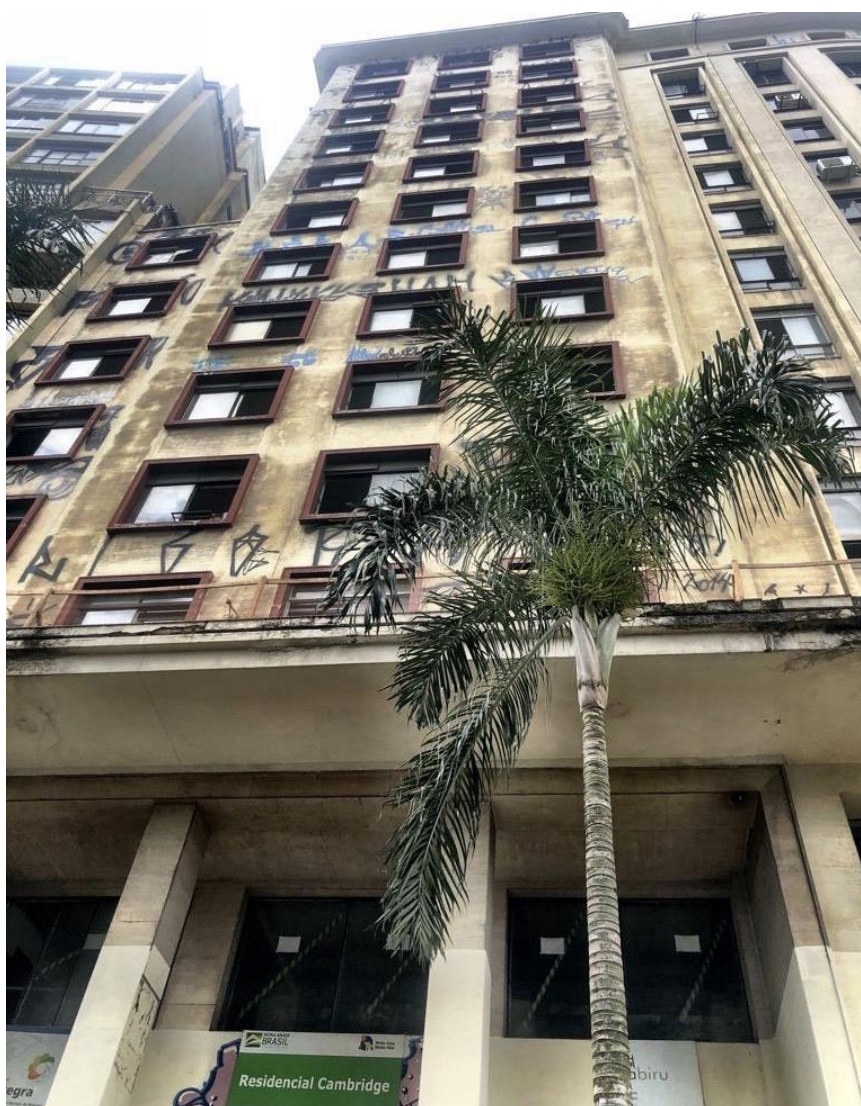
Figura 64 - Edifício Residencial Cambridge durante a reabilitação (Fonte: Nancy Laranjeira, 2019)
