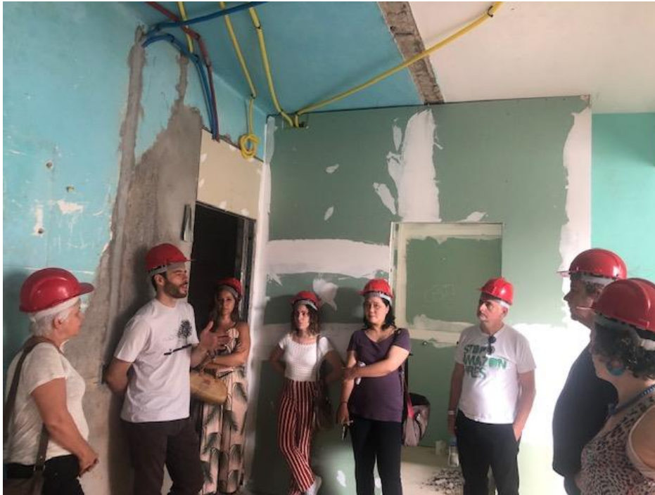
Figura 79 – Visita Técnica ao Edifício em reabilitação pelo grupo de Arquitetos e coordenação da Comissão de Desenvolvimento do CAU/SP (Fonte: Nancy Laranjeira, 2019)
