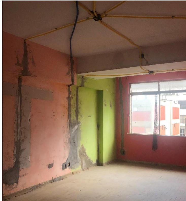
Figura 81 – Reabilitação em andamento 7º. Andar (Fonte: Nancy Laranjeira, 2019)
