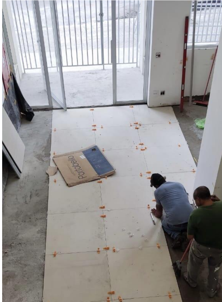
Figura 87– Saguão de entrada: assentamento de revestimento (Fonte: Alexandre Hodapp, 2022)
