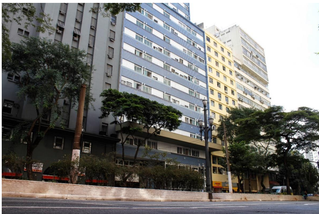
Figura 43 – Fachada Edifício Dandara após a reabilitação (Fonte: Daia Oliver, 2018)
