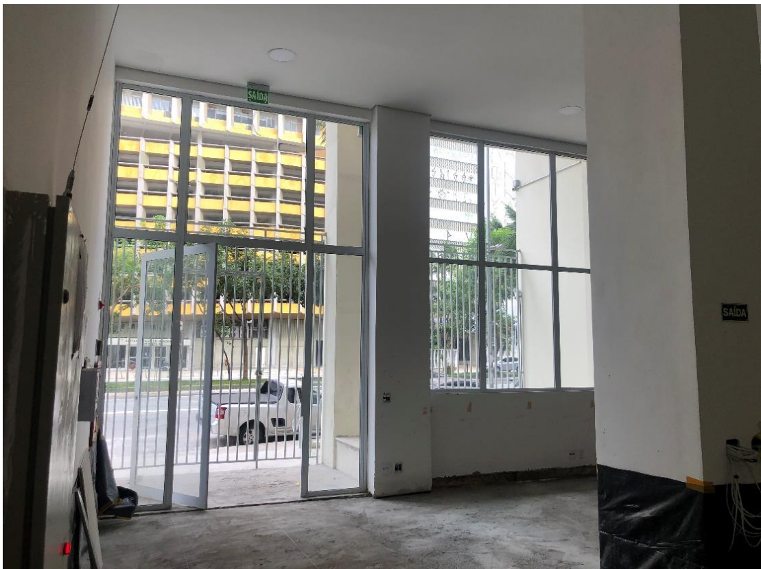
Figura 86– Saguão de entrada: regularização para assentamento de revestimento (Fonte: Nancy Laranjeira, 2019)
