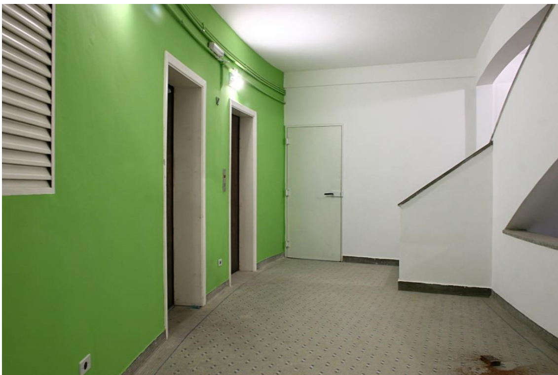
Figura 27 – Hall dos elevadores Ed. Riachuelo após a reabilitação (Fonte: Imagens cedidas por Pedro Bruna)
