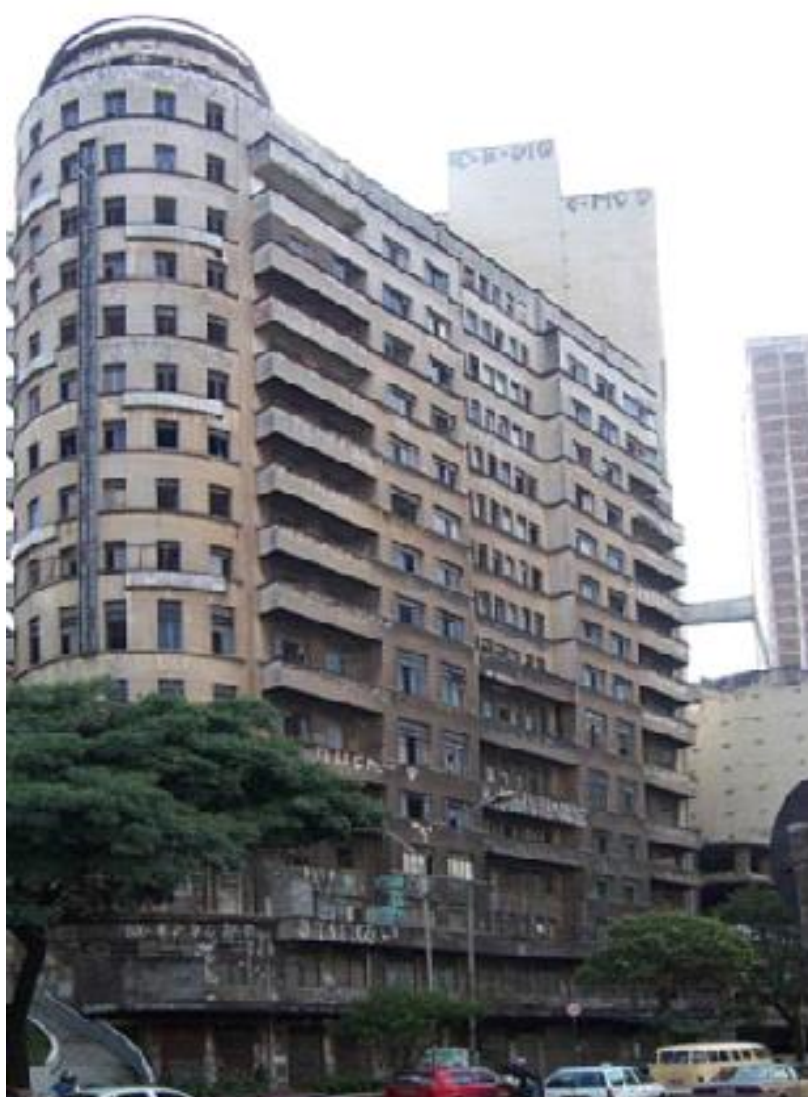
Figura 25 - Fachada antes da reabilitação (Fonte: Sonia Gouveia)
