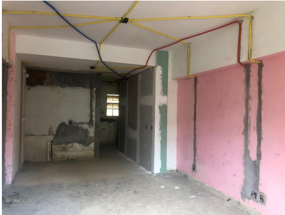
Figura 69 – Reabilitação em execução no 7º. Andar do antigo Hotel Cambridge (Fonte: Nancy Laranjeira, 2019)
