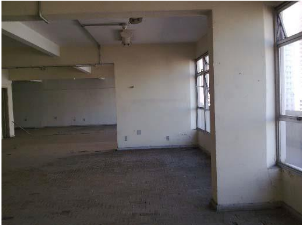
Figura 48 – Mezanino antes da reabilitação (Fonte: Integra)
