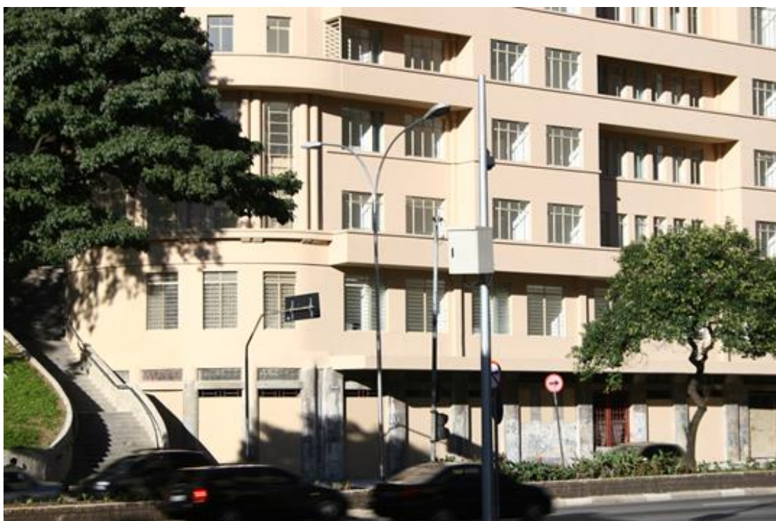
Figura 32 – Fachada Ed. Riachuelo após reabilitação (Fonte: Imagem cedida por Pedro Bruna)
