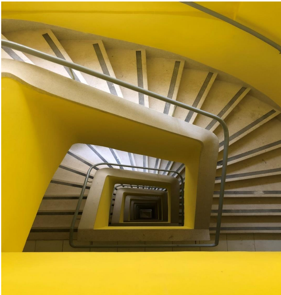
Figura 63 – Escadaria: o retrofit manteve o granito original (Fonte: Nancy Laranjeira, 2022)
