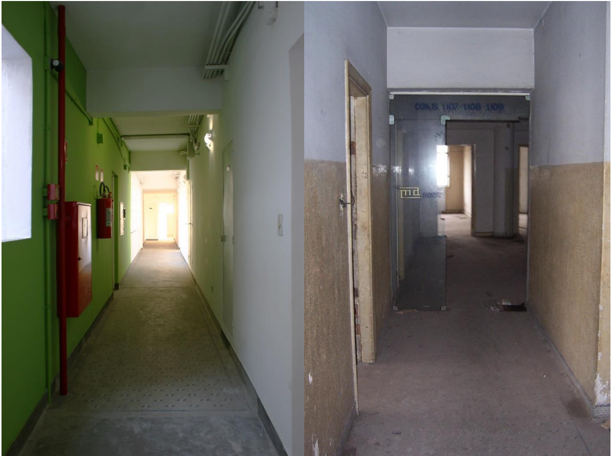
Figura 37 e 38 – Antes e depois da reabilitação – circulação (Fonte: Imagens cedidas por Pedro Bruna)
