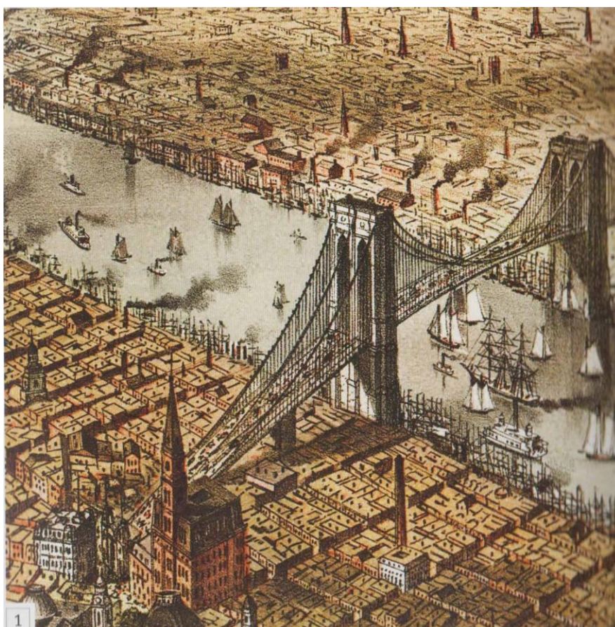
Figura 3: a cidade de Nova York (1875) e ponte do Brooklyn (1869) Autor: Parsons & Awater
