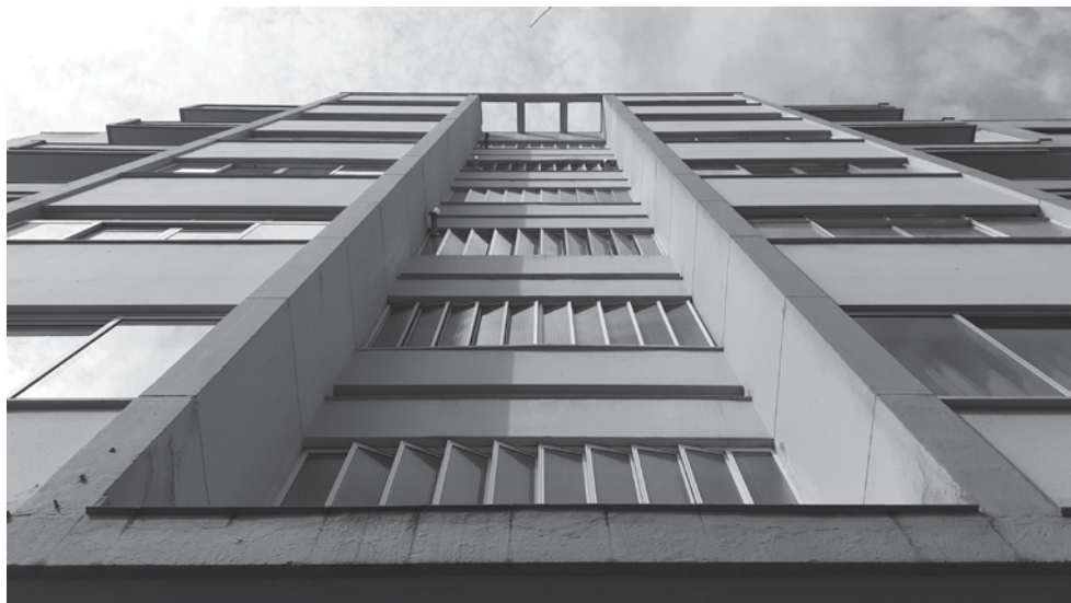
Figuras 184 - 187: Fotos do edifício J. B. Ferreira Lopes (março de 2019 – fevereiro 2022). Fonte: autora.
