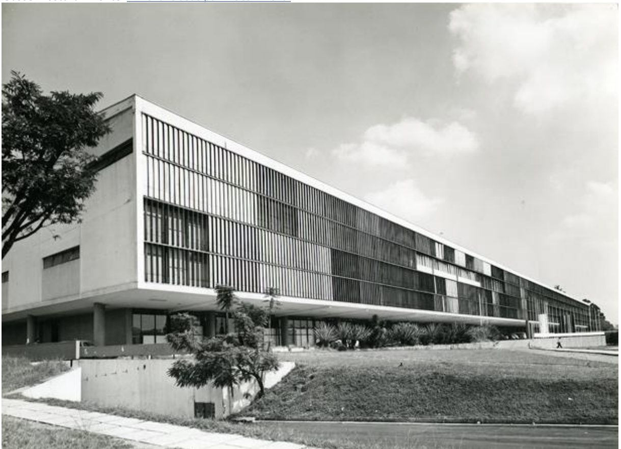
Figura 4-231 – Palácio das Indústrias – passou a se chamar Pavilhão Cicillo Matarazzo, hoje é popularmente conhecido como o prédio da Bienal Nesta fotografia já é possível ver os acréscimos desastrosos de tubos sob o balanço do prédio – ©José Moscardi – fonte: A Bienal e seus pavilhões - Bienal
