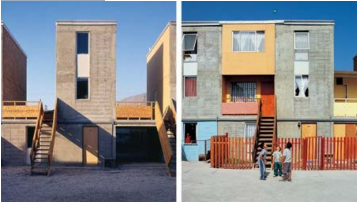
Figura 4-160 – Conjunto residencial projetado por Alejandro Aravena, Quinta Monroy em Iquique no Chile no ano de 2003, a esquerda a residências entregues à população e a direita a ampliação da área construída da moradia. Fonte: Archdaily - stringio.jpg (1100x627) (adsttc.com)
