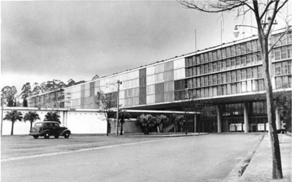
Figura 4-230 – Palácio das Indústrias, fotografia de 1961, quando ainda existia o trecho livre de quebra-sol na fachada, nota-se no lado esquerdo do prédio os andaimes de madeira da construção – autor desconhecido – fonte: Pavilhão fotogênico - Bienal
