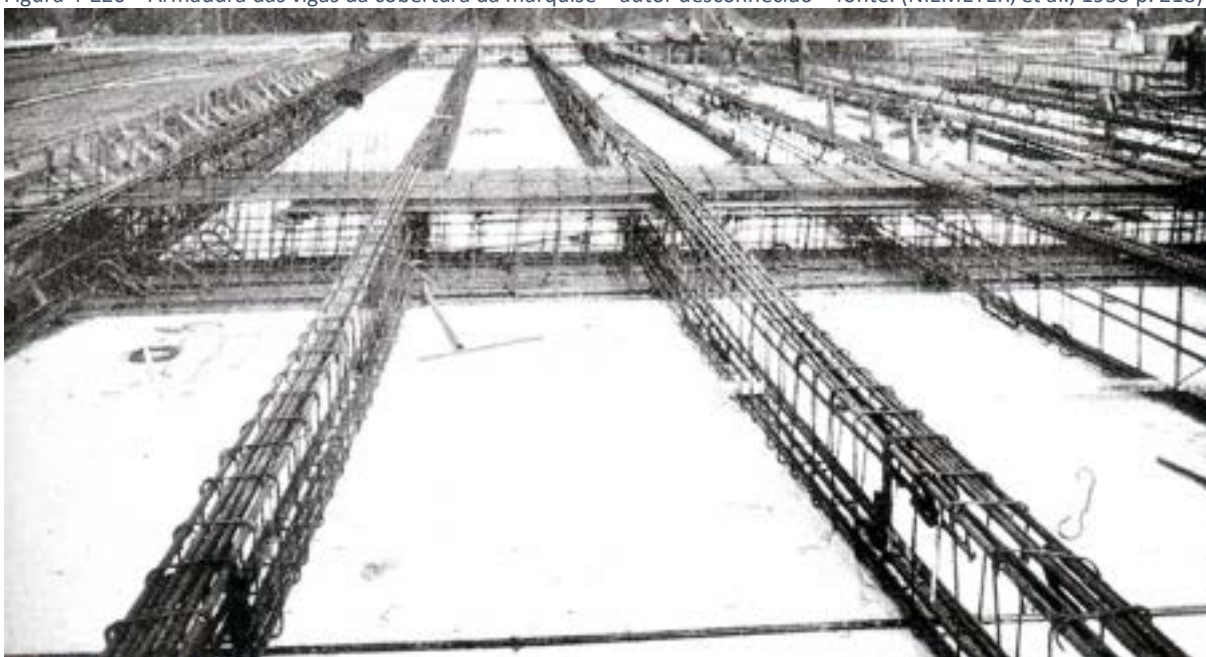
Figura 4-220 – Armadura das vigas da cobertura da marquise – autor desconhecido – fonte: (NIEMEYER, et al., 1953 p. 218)
