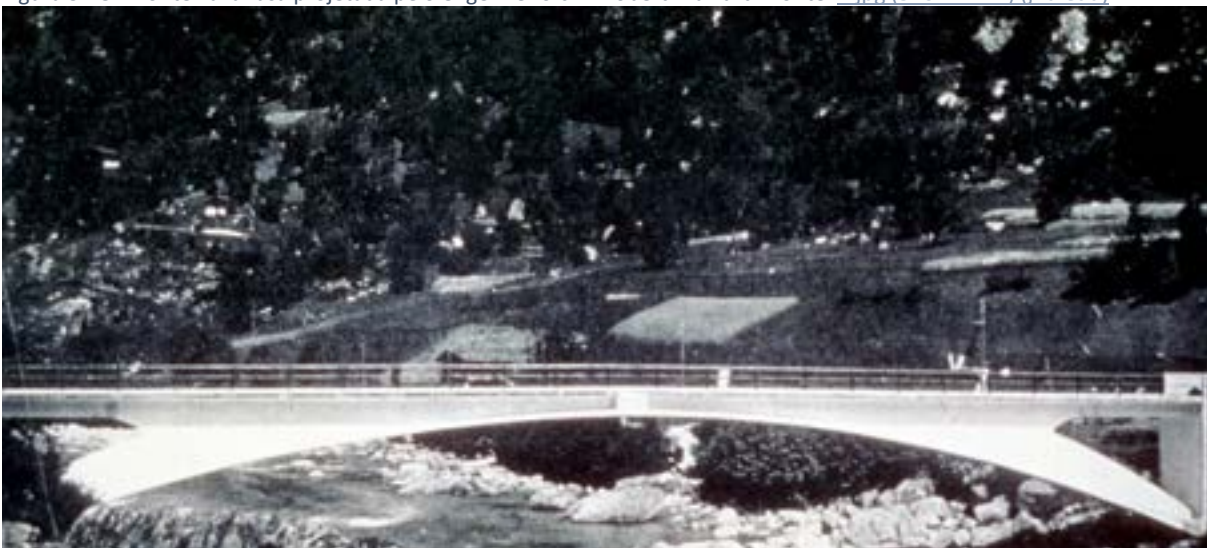
Figura 5-28 – Ponte Tavanasa projetada pelo engenheiro civil Robert Maillart – fonte: 4.jpg (3262x2141) (jhu.edu)
