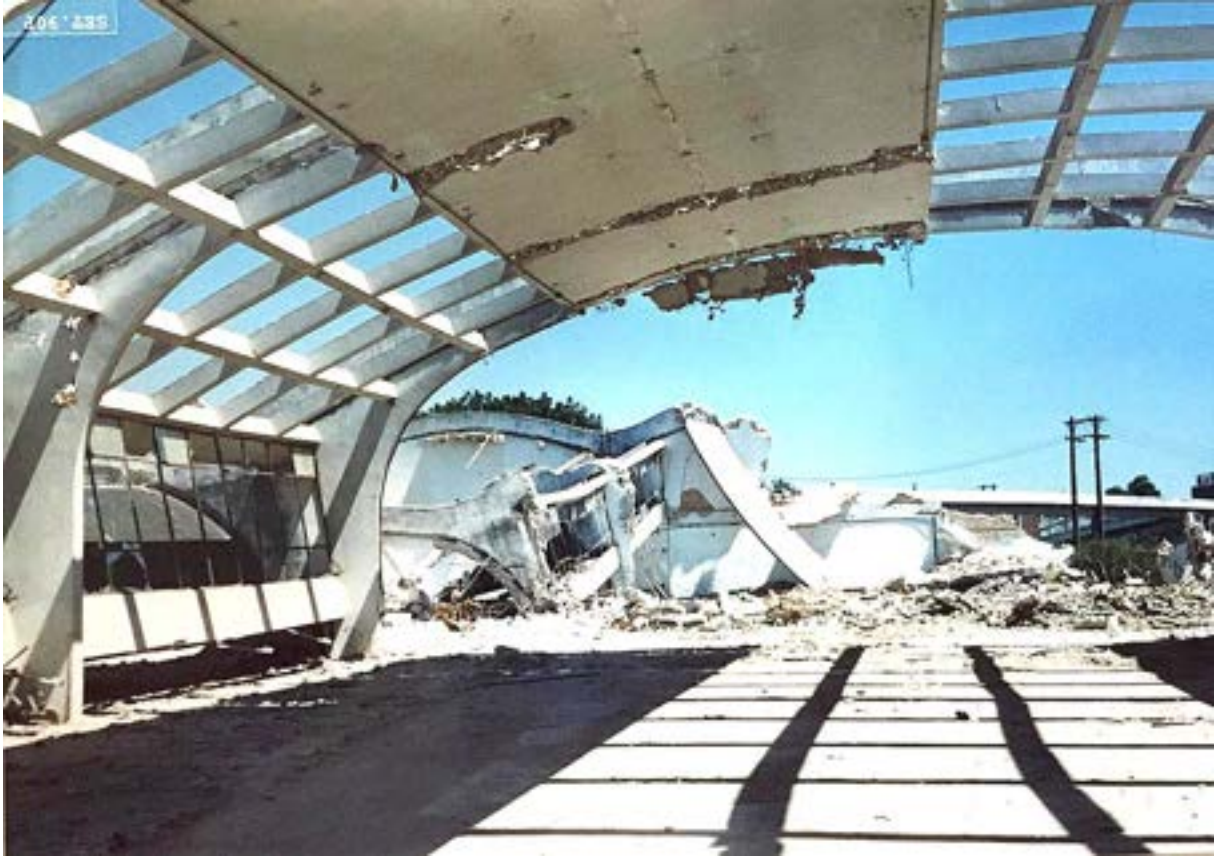
Figura 4-99 – Fotografia da demolição do prédio Fonte: https://www.facebook.com/oscar niemeyerworks/photos/a.1408658639403597/2110037092599078
