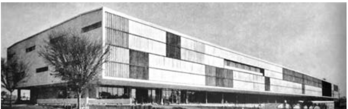
Figura 4-224 – Palácio das Indústrias recém-inaugurado, fachada noroeste – autor desconhecido – fonte: (MINDLIN, 1999 p. 208)
