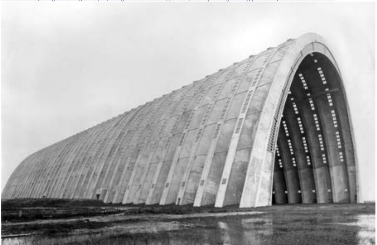
Figura 2-49 – Hangar de Orly, projetado por Eugène Freyssinet e construído entre 1916-1923. – fonte: https://www.architecture.com/image-library/RIBApix/image-information/poster/airship-hangar-orly/posterid/RIBA2243-16.html
