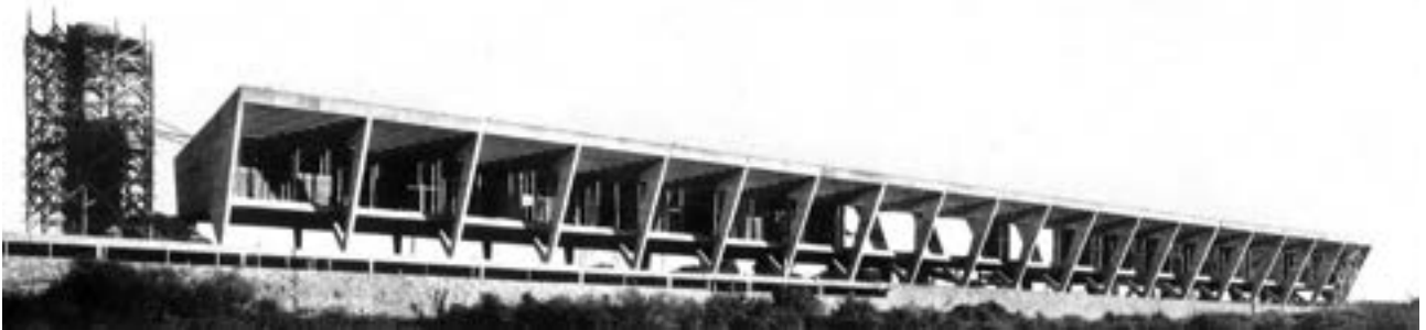
Figura 4-127 – Colégio Brasil Paraguai – Foto da construção. Fonte: (FRANCK, 1960 p. 63)
