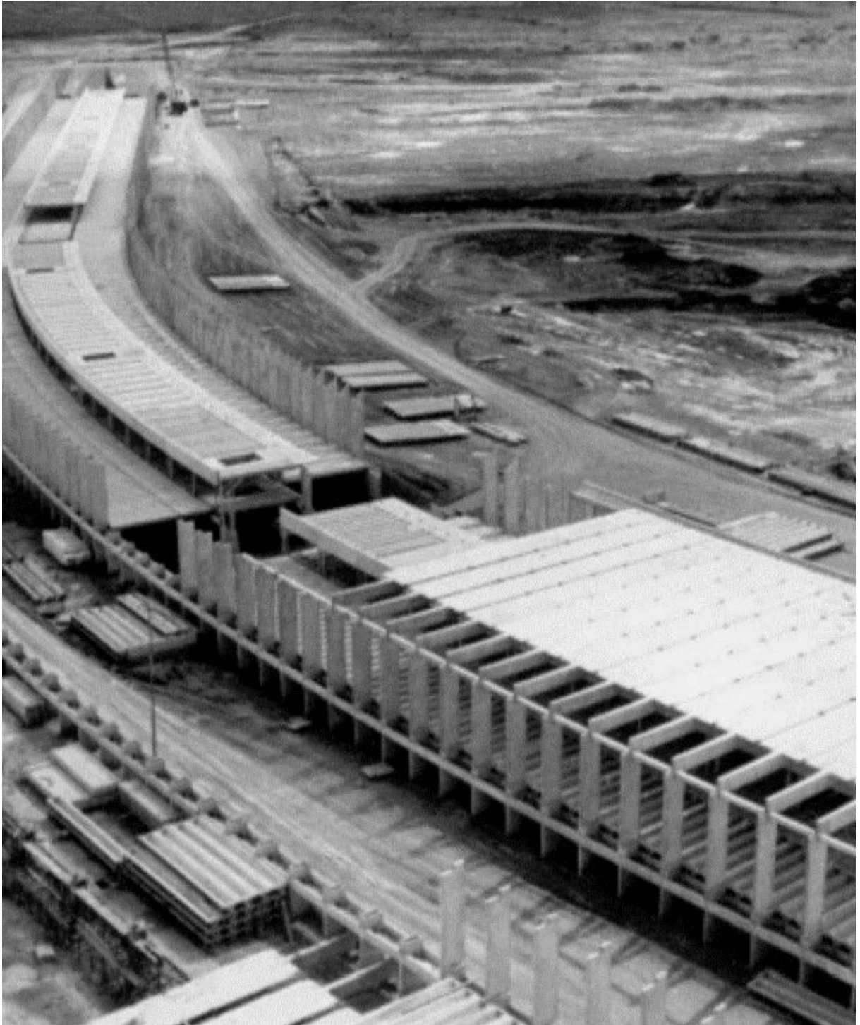
Figura 4-162 – Foto da construção do prédio – fonte: (BORGES, 2015 p. 70)
