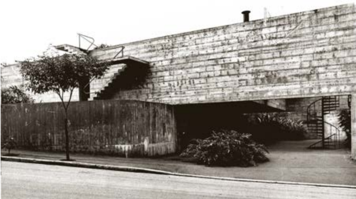
Figura 5-136 – Residência Milan (1974) – Paulo Mendes da Rocha – Leonardo Finotti – Fonte: Millán House, São Paulo - Paulo Mendes da Rocha | Arquitectura Viva https://images.adsttc.com/adbr001cdn.archdaily.net/wp-content/uploads/2011/12/1324475867_cais_das_artes_4.jpg
