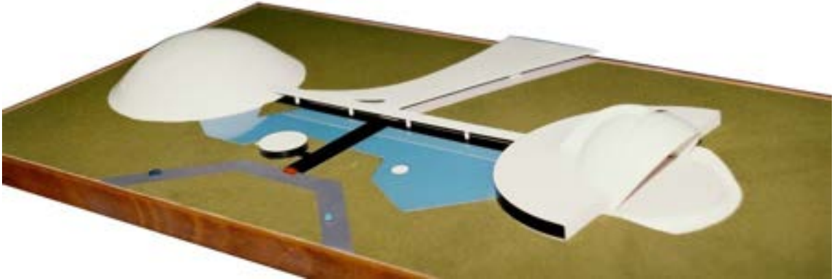
Figura 5-80 – Todo o prédio foi implantado um nível abaixo, nota-se a rampa de transição de níveis sob a marquise linear. – Foto e maquete Gilberto Antunes – Fonte: Acervo Gilberto Antunes
