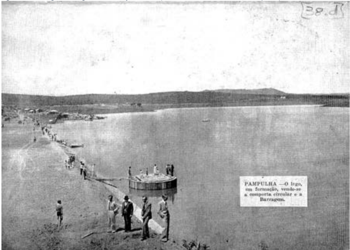
Figura 2-43– Fotografia da lagoa em construção – fonte: (Prefeitura de Belo Horizonte, 1941 p. 38d)
