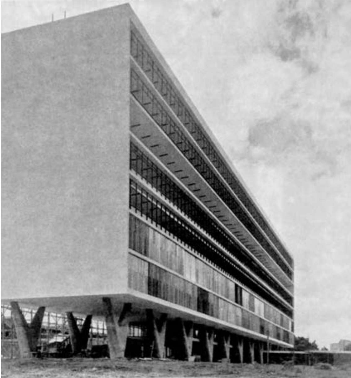
Figura 4-210 – instalação dos brises e caixilhos, nota-se a falta da marquise presente na fotografia anterior – autor desconhecido – fonte: (MINDLIN, 1999 p. 212)
