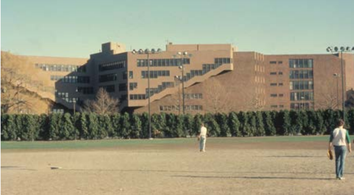
Figura 5-135 – MIT baker house dormitory – Alvar Aalto – fotografia: Larry Speck – fonte: Baker House at MIT - Larry Speck
