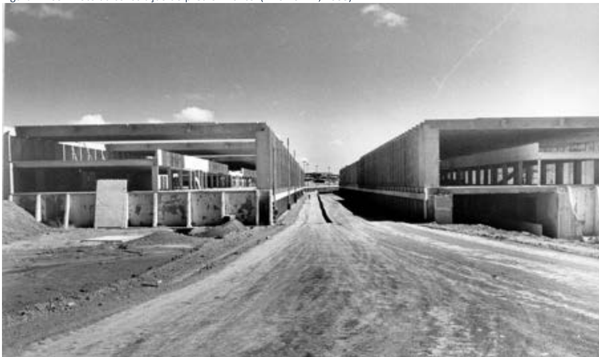
Figura 4-163 – Foto da construção do prédio – fonte: (NASIASENE, 2008)
