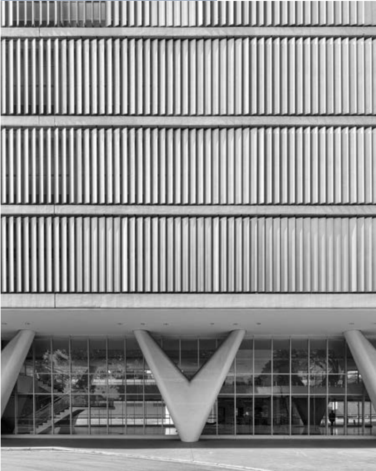
Figura 4-37 – Fotografia do prédio – Manuel Sá. Fonte: https://images.adsttc.com/media/images/5bea/bf55/08a5/e50e/3f00/00b4/large_jpg/Pal%C3%A1cio_da_Agricultura_Museu_de_Arte_Contempor%C3%A2nea_Image_%C2%A9_Manuel_S%C3%A1.jpg?1542111056
