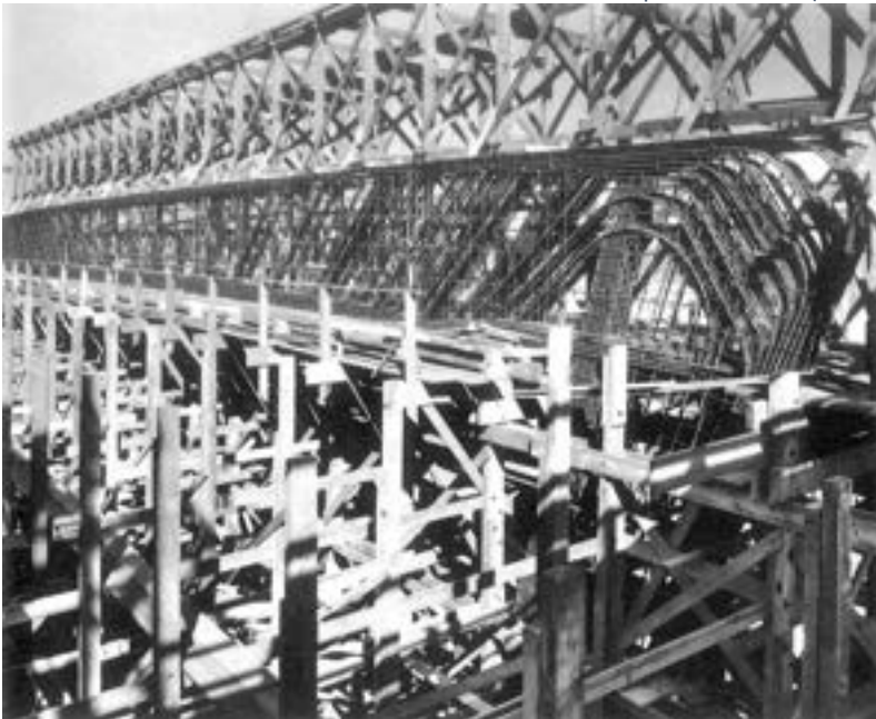
Figura 4-130 – Museu de arte moderna do Rio de Janeiro – foto da armadura do pórtico. Fonte: (FRANCK, 1960 p. 77)
