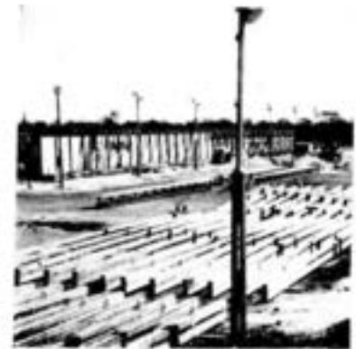
Figura 4-154 – Croqui e fotos das peças em concreto pré-fabricado do edifício sede do Ceplan Oscar Niemeyer (NIEMEYER, 1963 p. 26)
