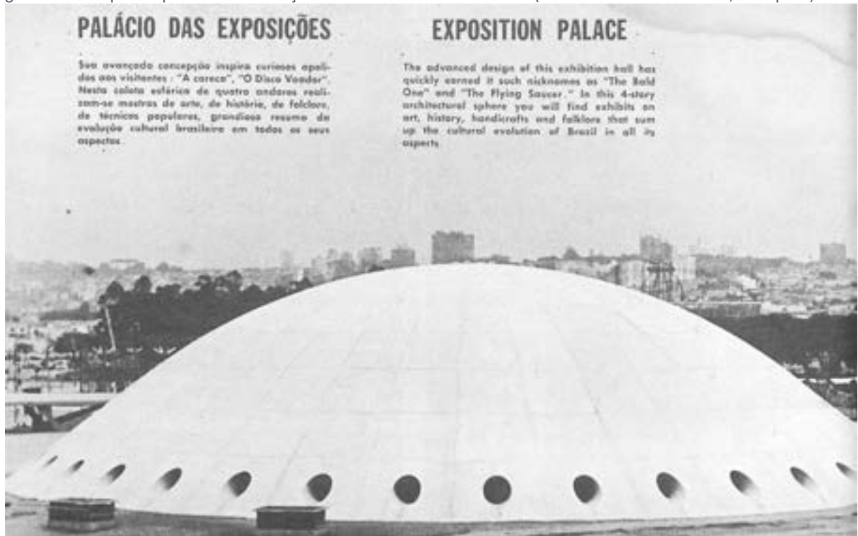
Figura 4-277 – O Palácio das Artes recém-construído revelava as marcas das fôrmas para a concretagem. O prédio já teve outros apelidos além de “Oca” era chamado de “A Careca” e “O Disco Voador” – um pouco abaixo da linha do horizonte o ginásio do Ibirapuera aparece em construção. – Autor desconhecido – fonte: (Manchete - revista semanal, 1954 p. 26)
