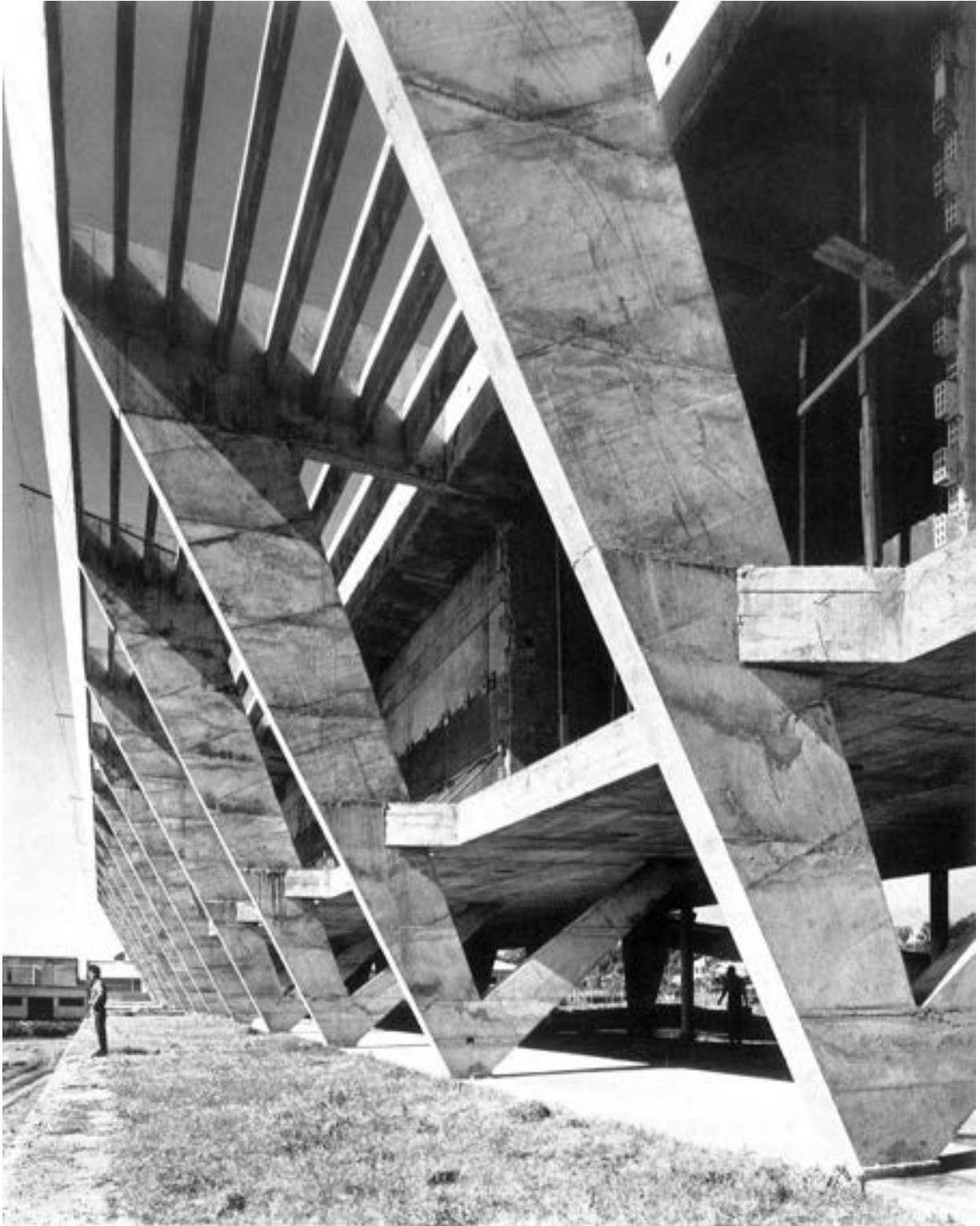
Figura 4-128 – Colégio Brasil Paraguai – Foto da construção. Fonte: (FRANCK, 1960 p. 65)
