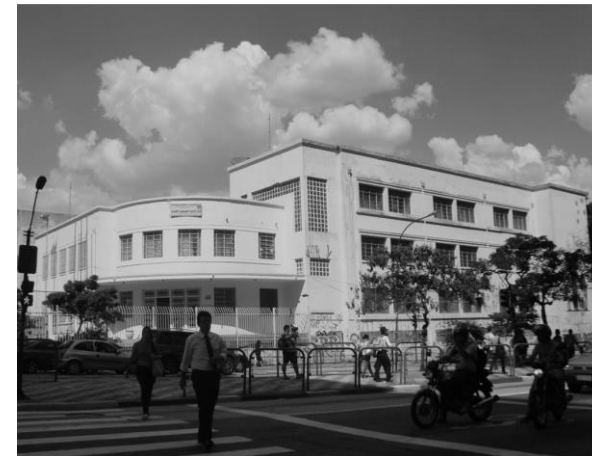
Figura 3: 1936 | EE Marina Cintra | São Paulo | Autoria: José Maria da Silva Neves | 1939 | Foto: autora
