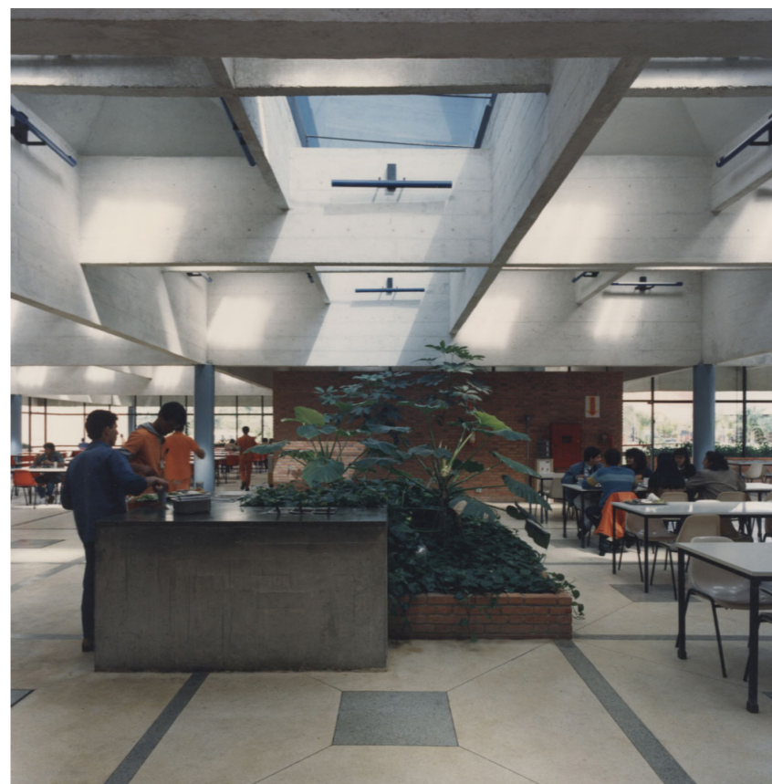
Imagem 32 Fotografia do interior do restaurante da Sew Motors, Guarulhos, SP. Destaque para a grelha de vigas de concreto aparente no forro. Crédito: Cristiano Mascaro. Fonte: SIMPLICIDADE, 1989, p.82.
