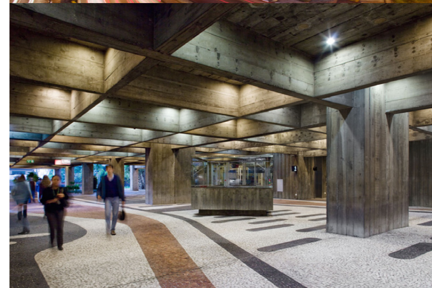
Imagem 8 Fotografia do térreo do condomínio-edifício São Luiz, com destaque para a grelha de vigas aparentes no forro. Crédito: KON, 2009.
