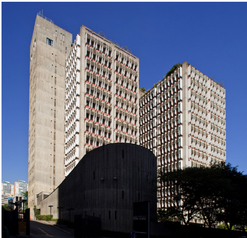
Imagem 4 Fotografia da fachada norte do condomínio-edifício São Luiz. Crédito: KON, 2009.
