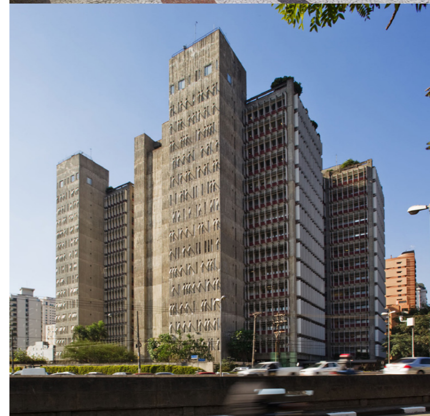
Imagem 9 Fotografia da fachadas sul e leste do edifício-condomínio São Luiz. Crédito: KON, 2009.
