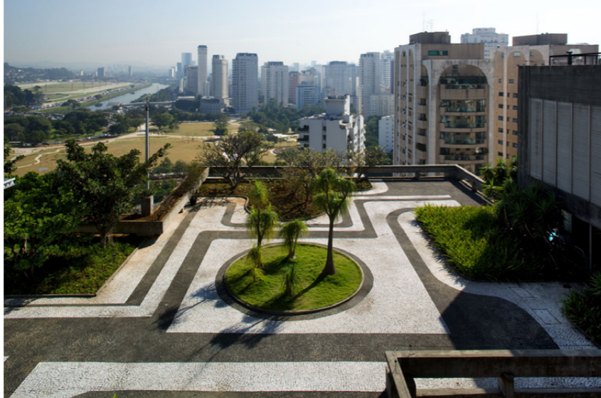
Imagem 5 Fotografia do terraço do 14o pavimento do condomínio-edifício São Luiz. Crédito: KON, 2009.
