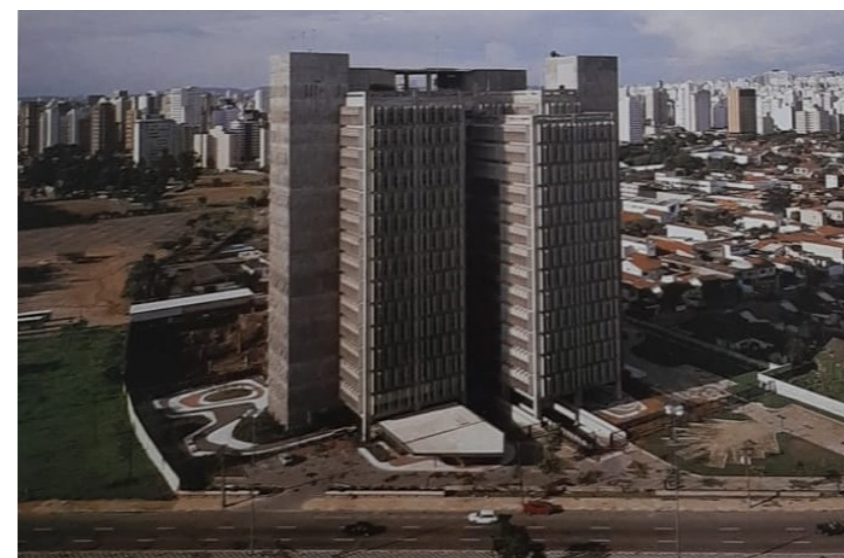
Imagem 150 Fotografia do condomínio-edifício São Luiz à época da conclusão do quadrante 2 (1985?). Destaque para o entorno ainda ocupado, majoritariamente, por edificações baixas e o térreo do quadrante 3 em obras. Autor desconhecido. Fonte: acervo do Arq. David G. da Costa Lopes.
