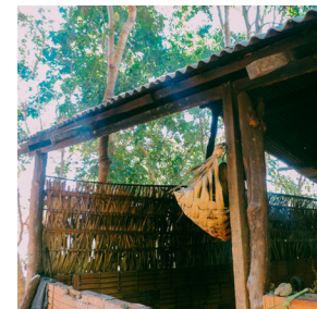
alvenaria, palha e telha de fibrocimento
