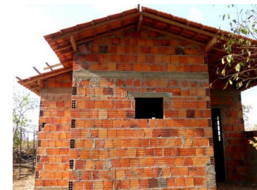
(1) Execução em alvenaria;
