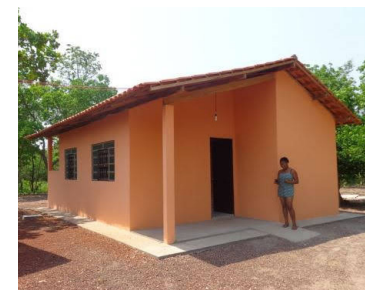
(3) Vista externa da casa.
