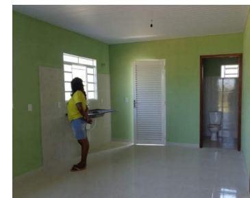
(2) Interior da sala;
