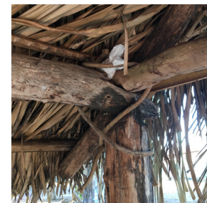
estrutura de madeira
