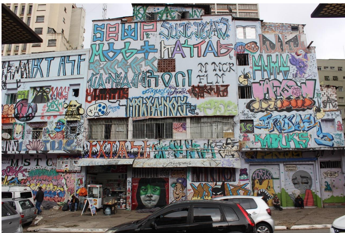
Figura 14: Fachada Ocupação Rio Branco.
