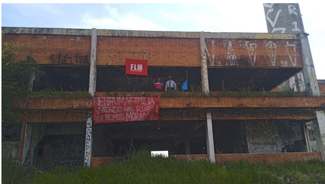
Figura 10: Edifício Ocupado pela FLM, em Itaquaquetuba, em dezembro de 2021.
